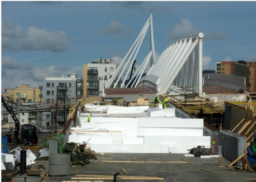
Figur 24. EPS fylling ved Nordenga bru. Foto Statens vegvesen
