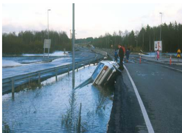
Figur 28. Oppdrift av EPS blokker. Noen fikk glede av EPS blokkene som fløt opp på RV 159 Flom bruer. Foto Statens vegvesen.
