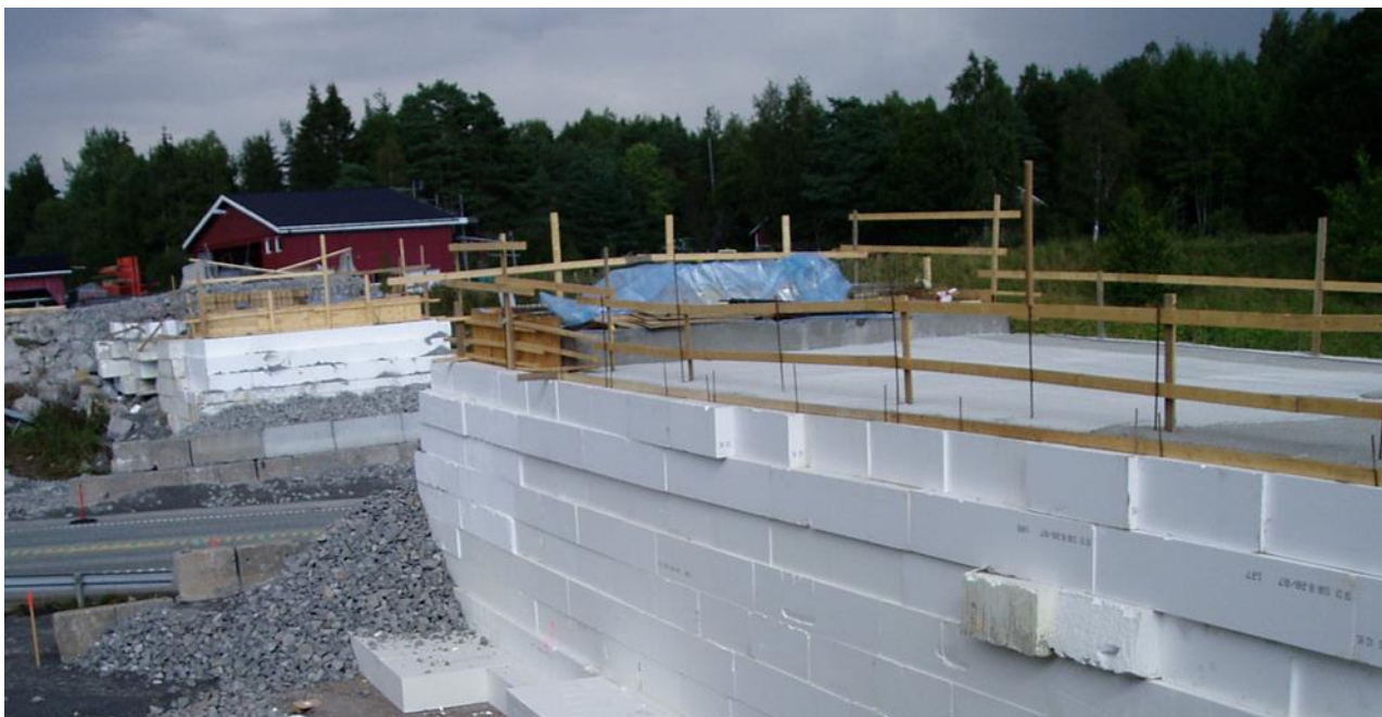
Figur 2. Grimsøyvegen bru, Kryssing av E6. Fundamentering av bru på EPS. Foto Roald Aabø Statens vegvesen
