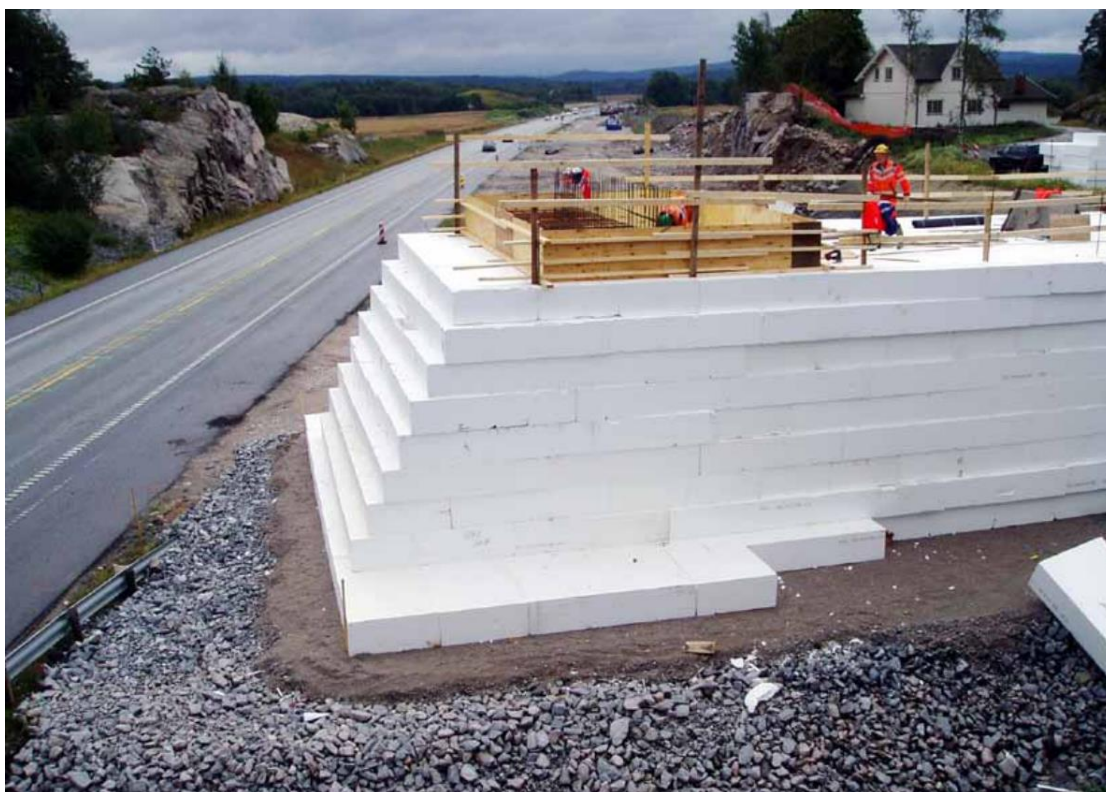
Figur 34 Fyllinger for interimsbru over E 6 ved Gimsøyvegen (Foto; Tor Helge Johansen Statens vegvesen)
