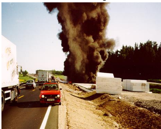
Figur 30. Brufundament skadet av EPS-blokker satt i brann. Foto Statens vegvesen
