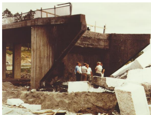
Figur 30. Brufundament skadet av EPS-blokker satt i brann. Foto Statens vegvesen
