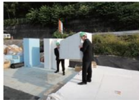
NPRA 技術者 2名来日 (2010年) EDO-EPS 施工現場視察
