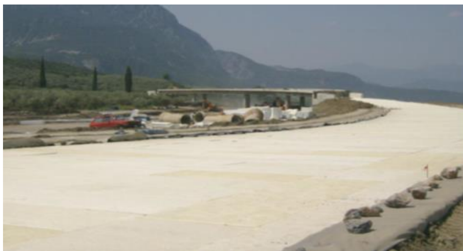
Figur 32. 65.000 m 3 EPS-blokker på E 75 ved Thermopylene, Hellas (Bilde: Sotiropoulos & Associates SA)
