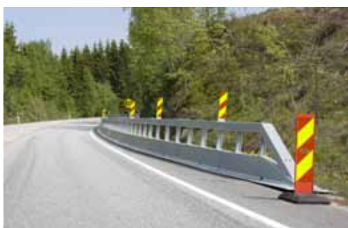
Figur 4.13 Langsgående sikring (eksempler).
