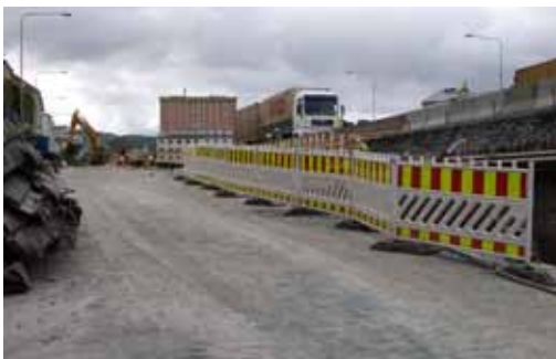
Figur 4.14 Sikring mot gående og syklende (eksempler).
