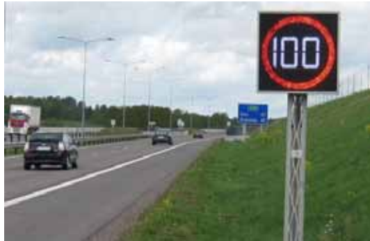
Figur 2.2 Eksempel på lysende billedpunktsskilt.
