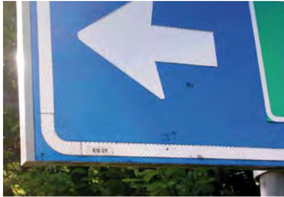
Merking av trafikkskilt med kode for leverandør og angivelse av hvilket år skiltet ble produsert
