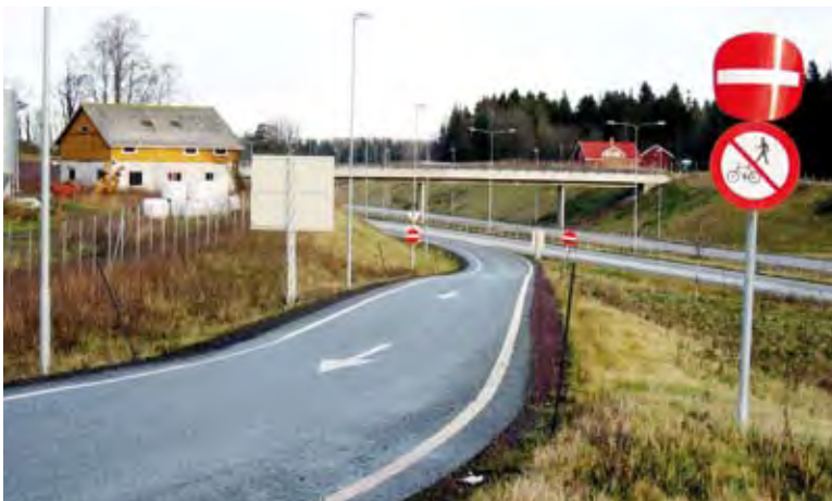
Fig. 11 Eksempel på skilt 302 «Innkjøring forbudt» satt opp på rampe fra flerfeltsveg, for å hindre utkjøring.
