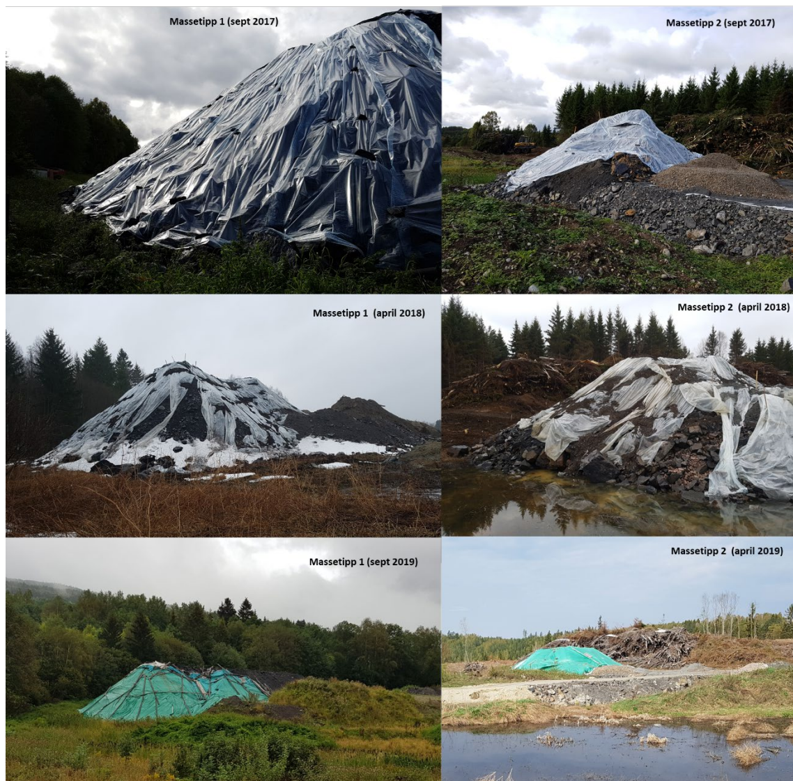
FIGUR 5. FOTO AV TILDEKKING AV MASSETIPP 1 OG 2, FOTO FRA OKTOBER 2017 TIL SEPTEMBER 2019. FOTO: ØVRE OG MIDTRE BILDER: HALDIS FJERMESTAD, NEDERSTE BILDER: GINE LØVSTAD HEGSETH.
