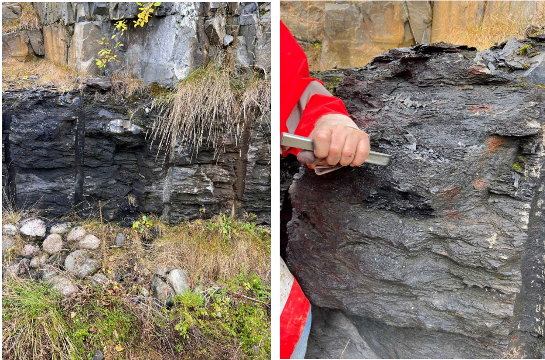
FIGUR 40. FOTO FRA LOKALITET 1. LANGS KISTEFOSSEVEIEN TATT VED UTTAK AV PRØVER I SEPTEMBER 2022. FOTO: CECILIE HALLINGSTAD.
