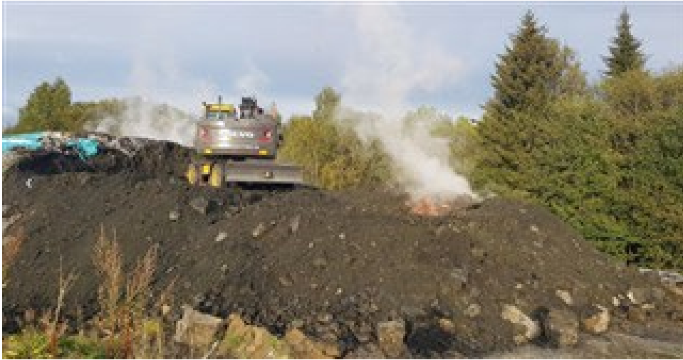
FIGUR 15. OVERSIKTSBILDE LOKALISERING AV VARME MASSER. FOTO: PAL-STEINAR KARLSEN SVV.
