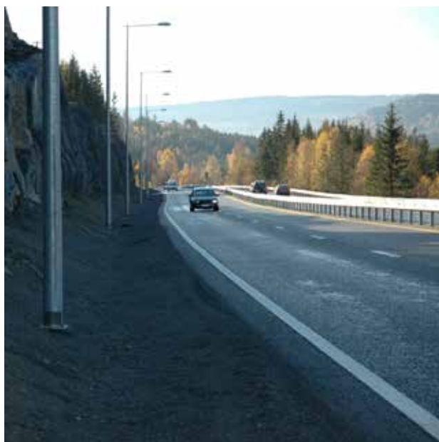
E6 Hunderfossen_Firefeltsveg med sideterreng fylt opp mot fjellskjering og lysmast med knekkledd.
