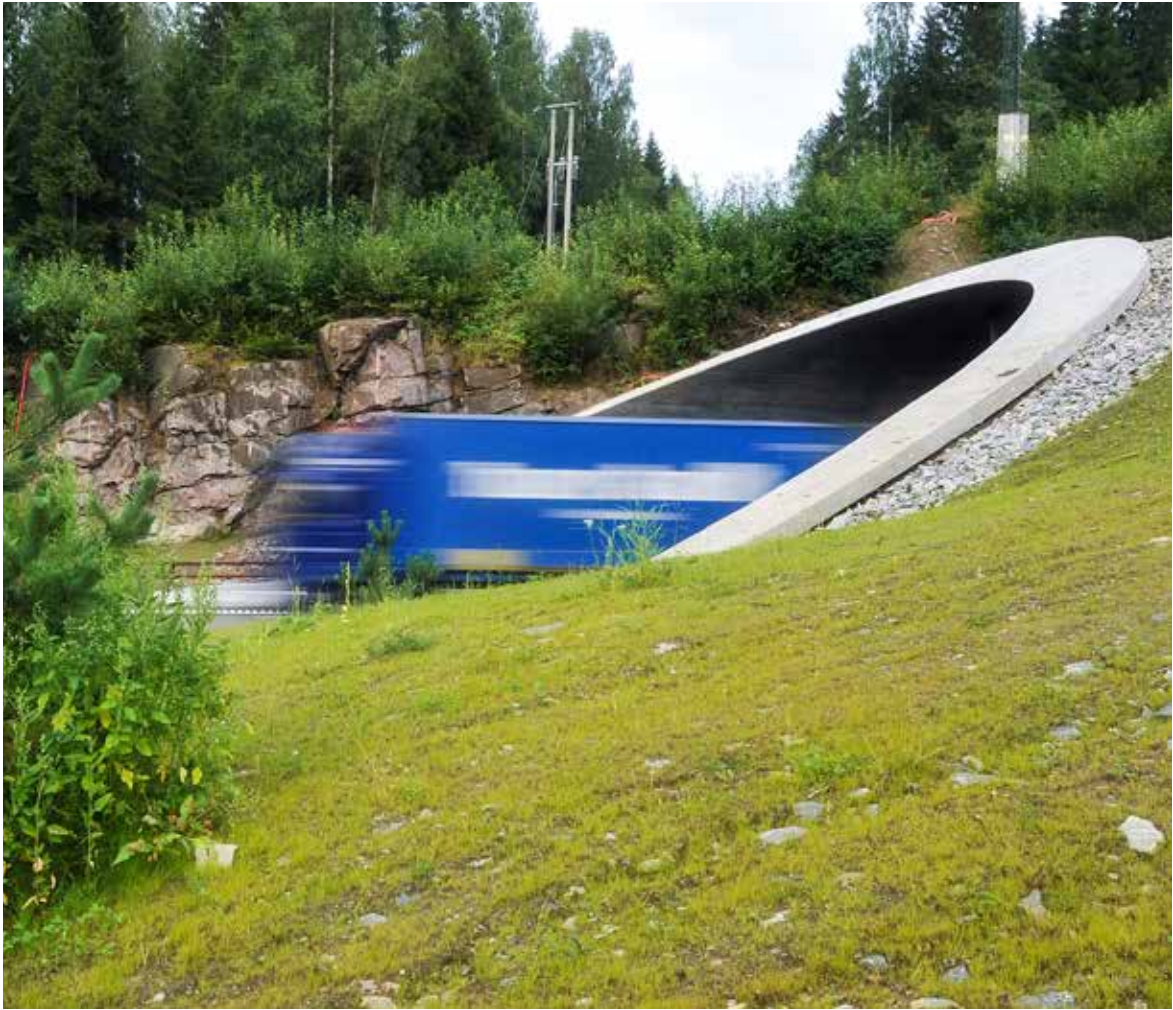
E6 Eidsvolltunnelen. Foto Knut Opeide
