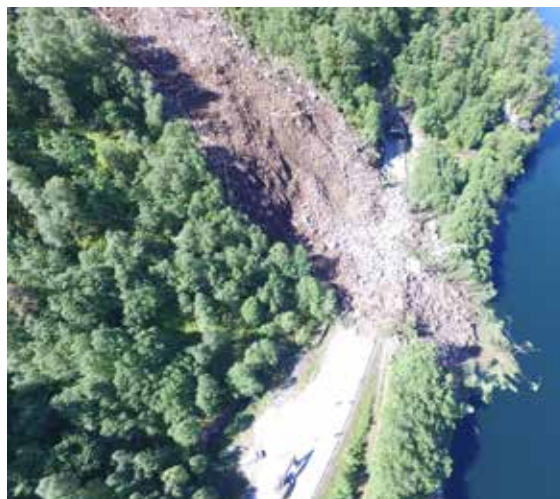
E16 Ras over Hyvingtunnelen. Foto Harald Hauso
