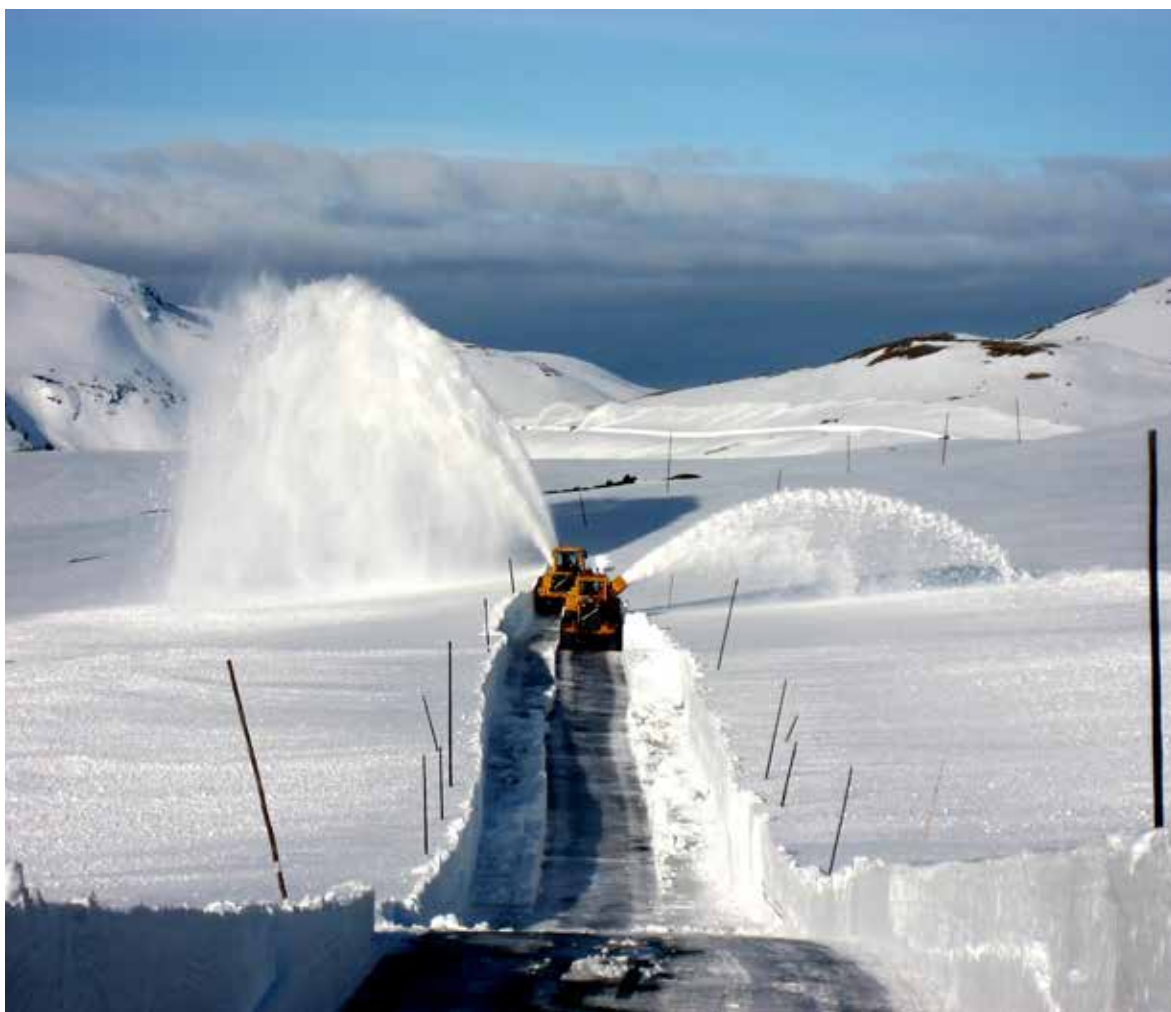
Fresing av rv 55 over Sognefjellet. Foto : Geir Skjåk
