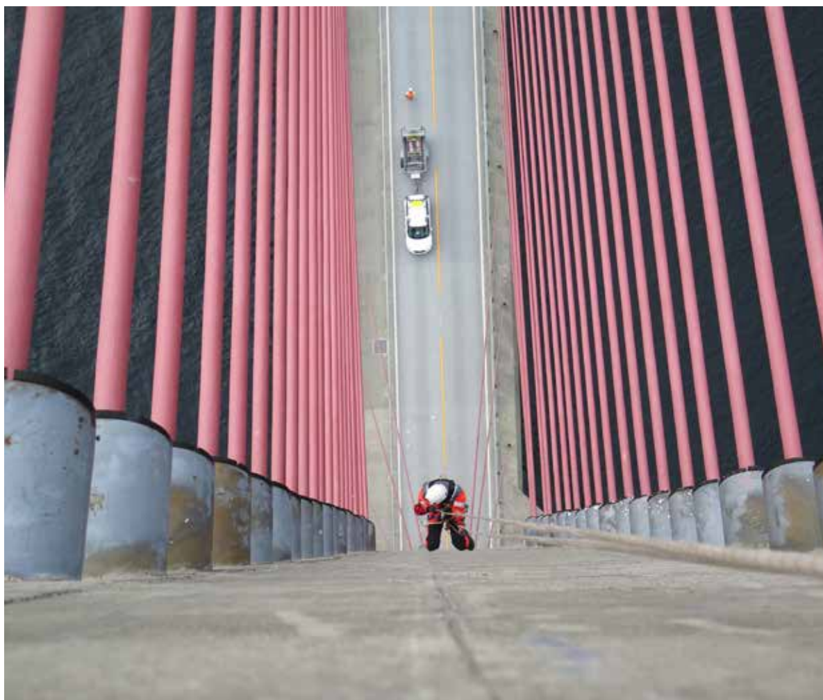
Bruinspeksjon av Skarnsundbrua langs rv 755. Foto: Elin Spildo
