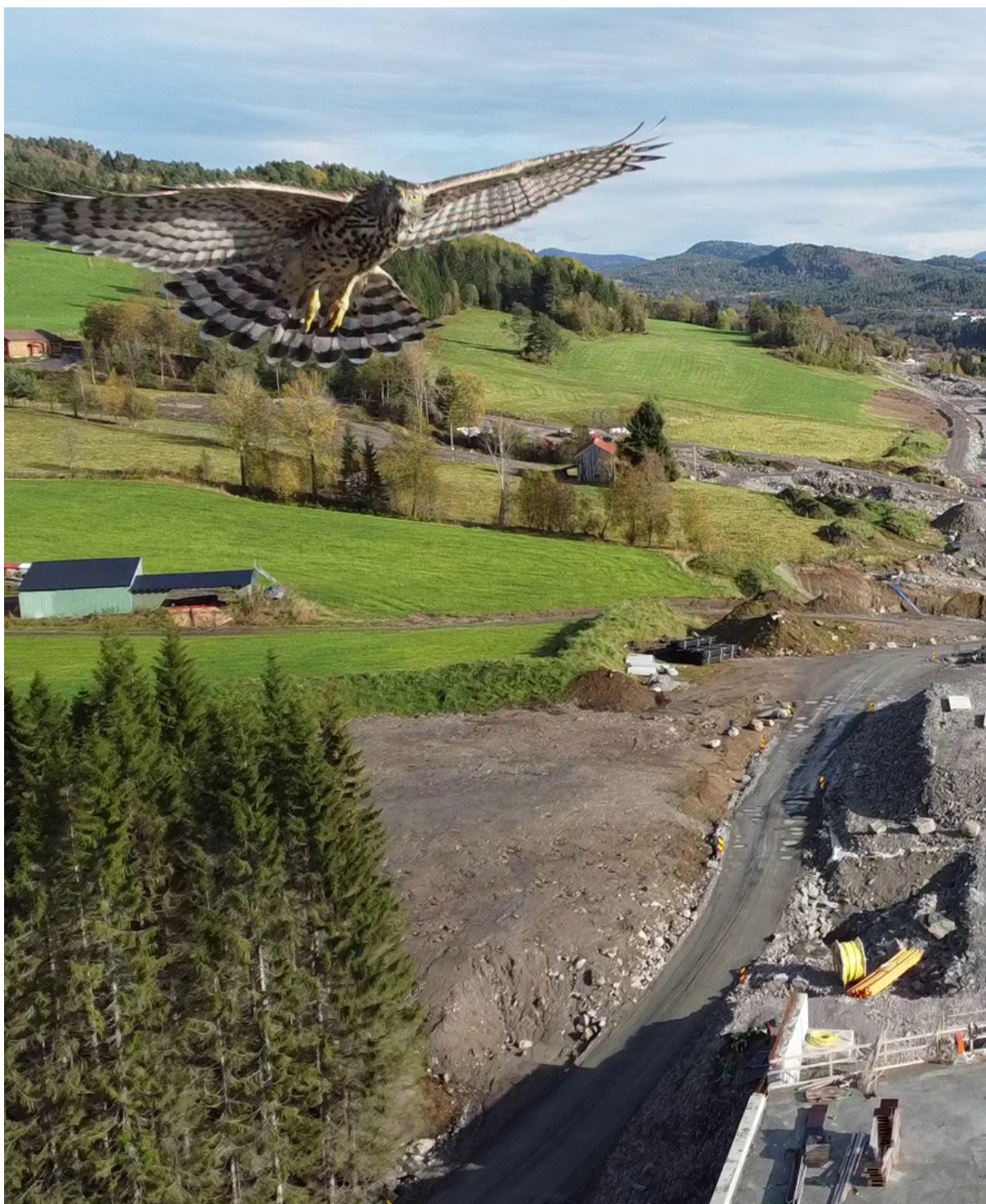
Hønehawk over anlegget på E39 Lønset-Hjelset. Foto: Maria Madrid, Statens vegvesen
