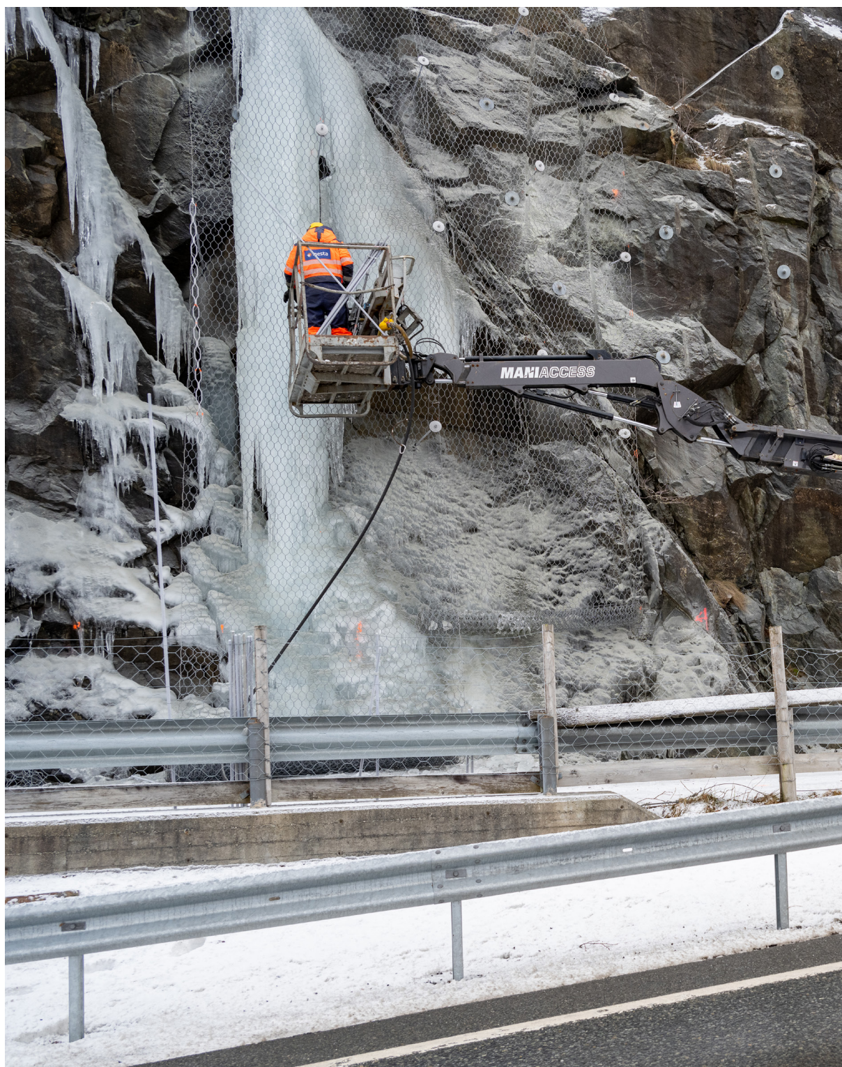
Rassikring ved E134 Kypring. Foto: Bård Asle Nordbø, Statens vegvesen.
