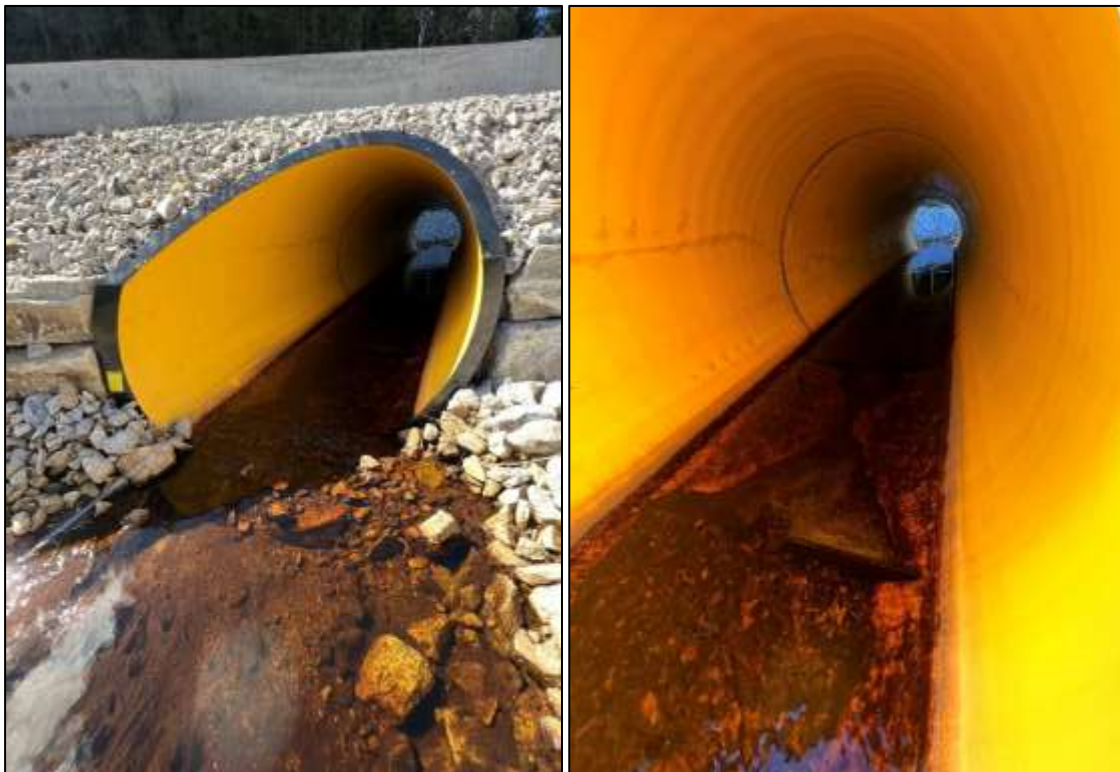
Figur 49. Plastrør med støpte terskler (Foto: Øyvind Haugland).
