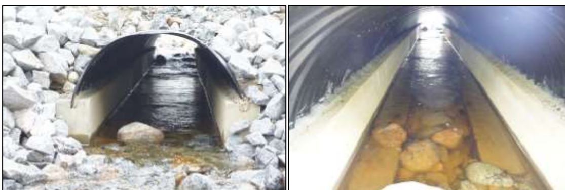
Figur 36. Hvelvkulvert i en mindre bekk med naturlig bunnsstrat (Foto: Henrik Lissman/Emma Persson).
