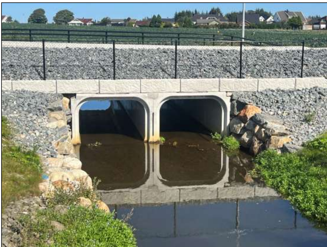
Figur 48. Bokskulvert i Kleppekanalen på Klepp i Rogaland (Foto: Øyvind Haugland).
