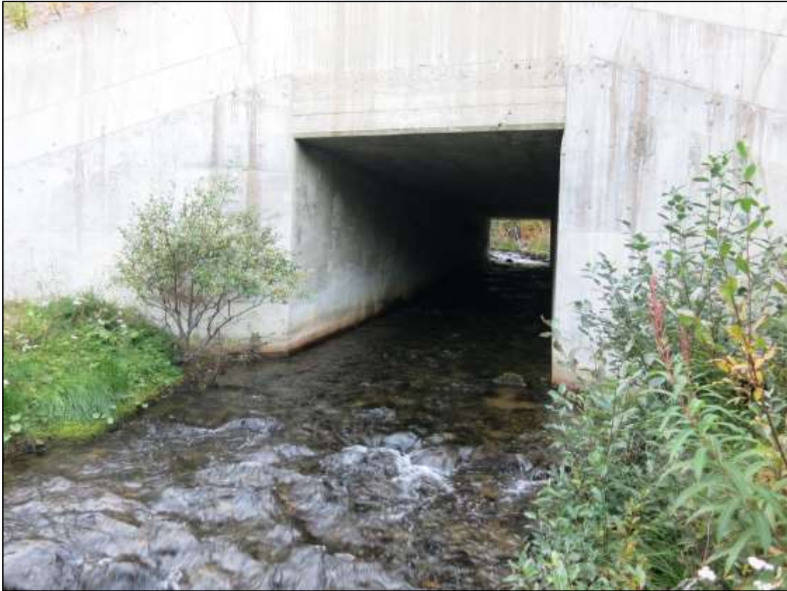
Figur 30. Plasstøpt bru i fylling kan også være en god løsning som sikrer ivaretagelse av naturlig bunnsbunnsstart og gode vandringsforhold for fisk. Viktig at bredden på elva ikke blir innsnevret (Foto: Øyvind Haugland).
