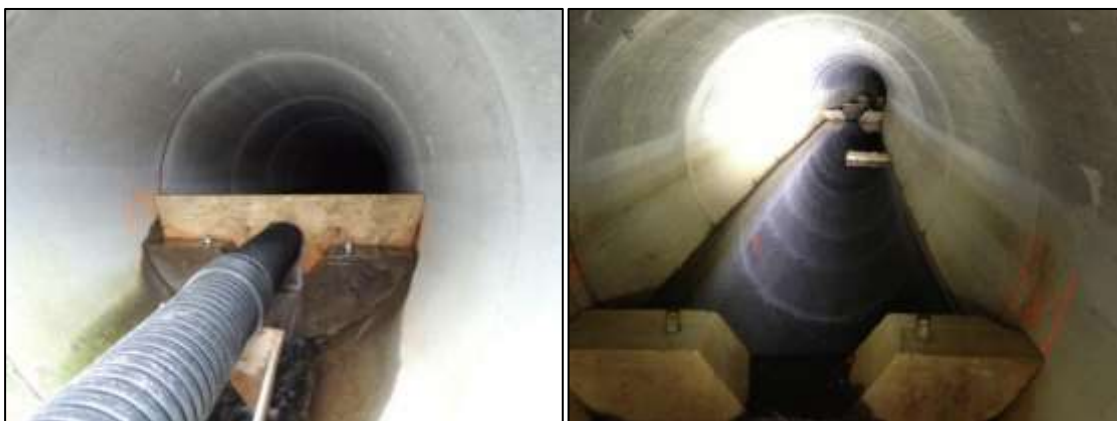
Figur 67. Det ble støpt terskler inni kulverten for å bremse vannhastigheten (Foto: Paul Ridola).
