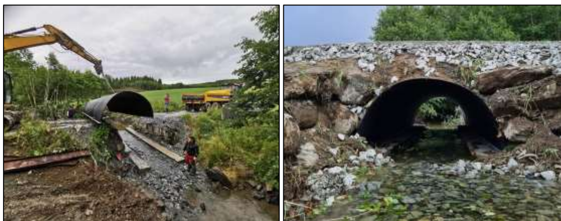
Figur 43. Hvelv/halvbuen ble heiset på plass. Bunnsstrat etablert i bekken mellom fundamentene. Gode vandringsforhold for fisk gjennom hvelvkulverten (Foto: Sigbjørn Hammer, Hammer Skogtjenester AS).
