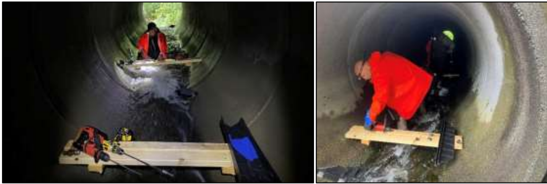
Figur 65. Montering av fleksiterskler i betongkulvert (Foto: Sjøørretprosjektet i Rogaland).
