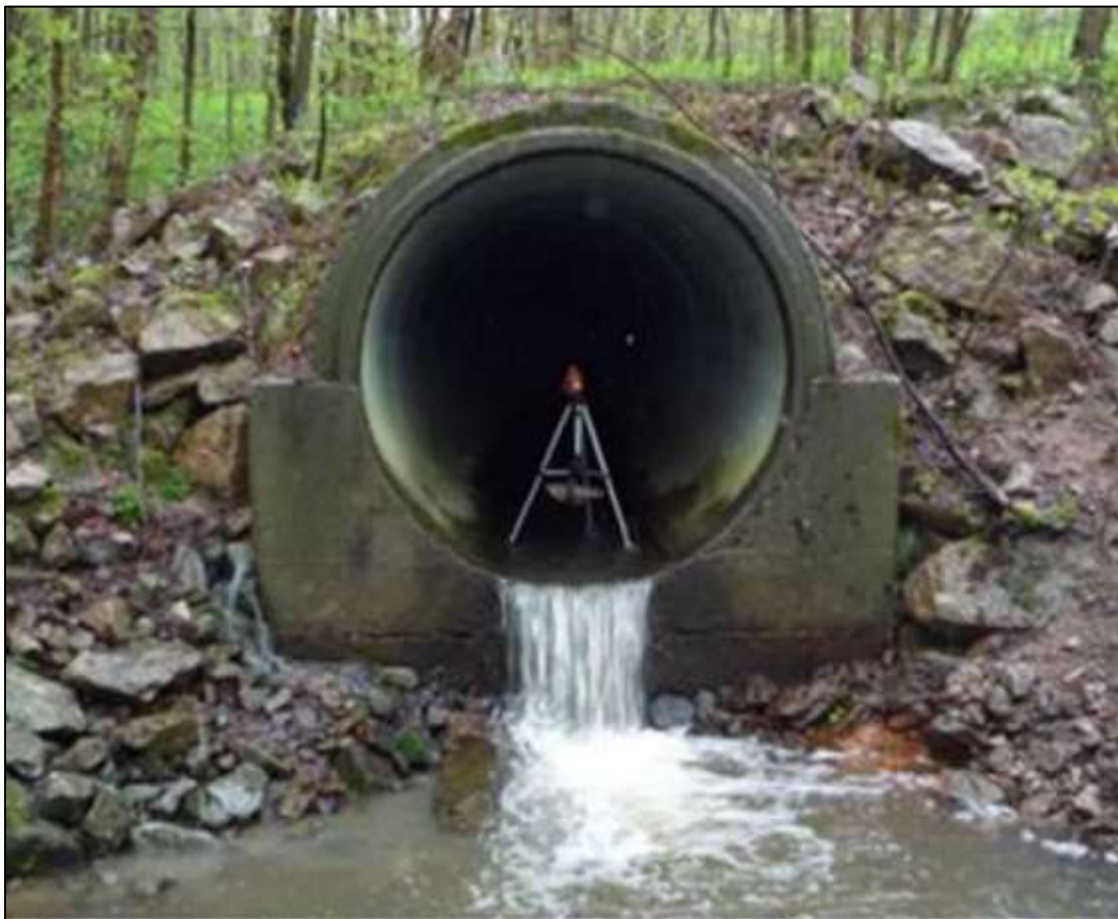
Figur 66. Høyt sprang ved utløpet av kulverten i Sævelibekken (Foto: Norconsult).
