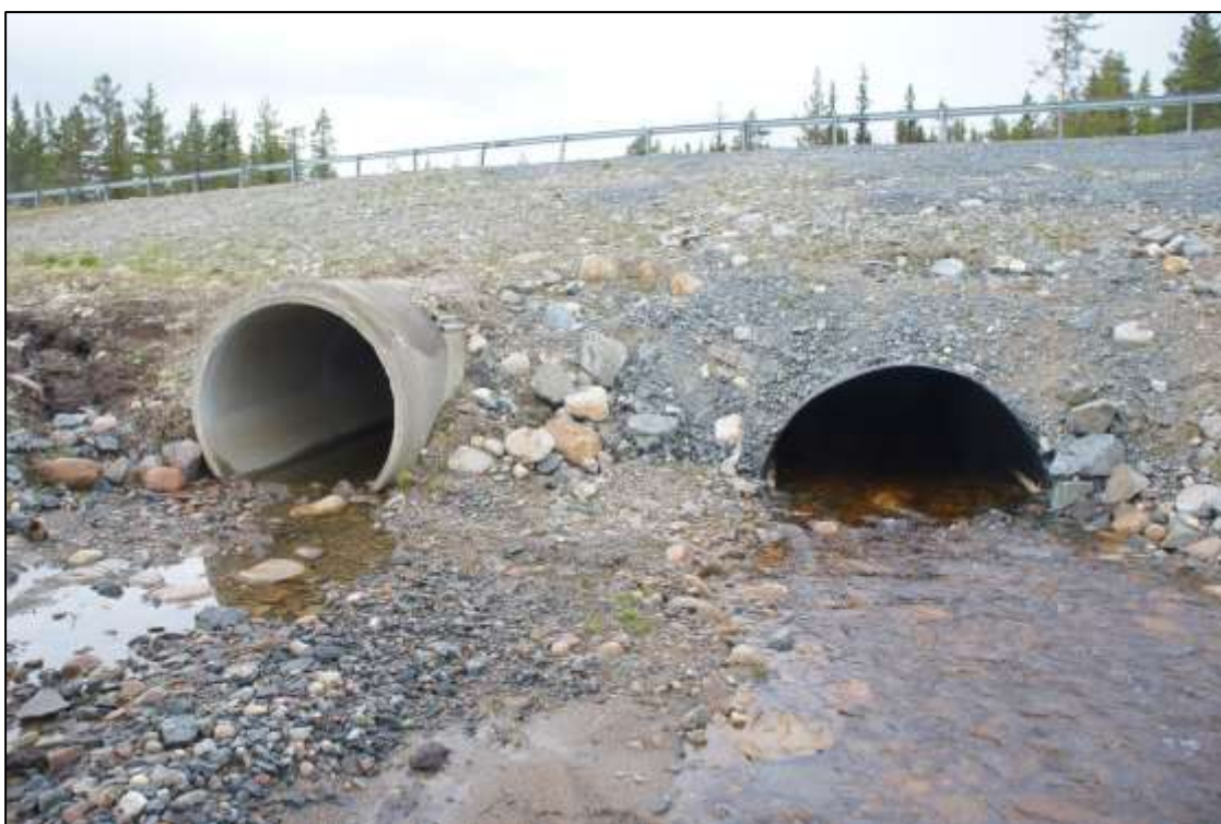
Figur 38. Sirkulær betongkulvert kombinert med hvelvkulvert, hvor hvelvkulverten har hovedvannføringen og betongkulverten fungerer som et overløp ved høyere vannføring og flom (Foto Henrik Lissmann/Emma Persson).
