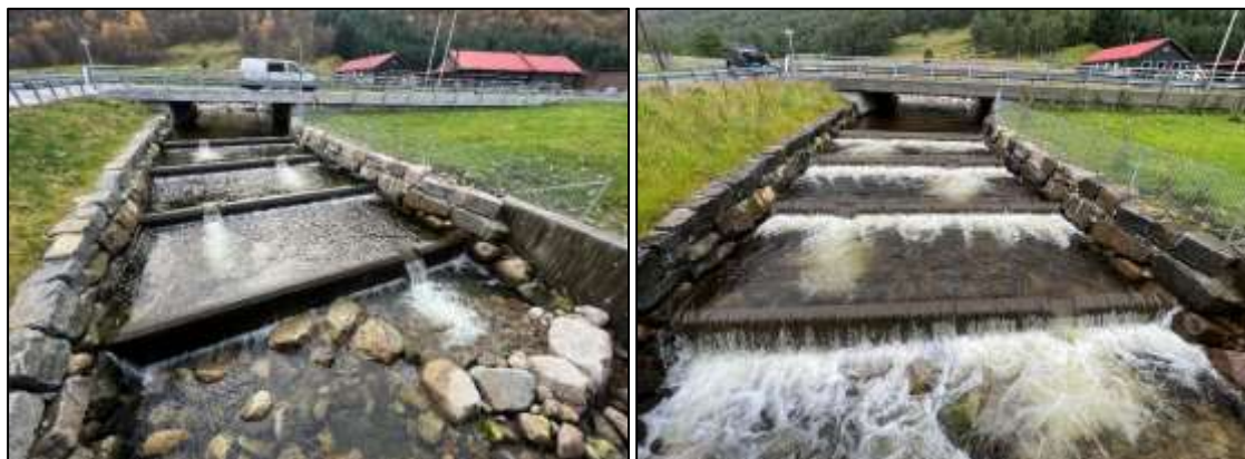
Figur 70. Terskler ble etablert nedstrøms brua for å lette oppgangsforholdene for fisk opp til brua. Bildene viser oppvandringsforholdene på ulike vannføringer i bekken (Foto: Øyvind Haugland).
