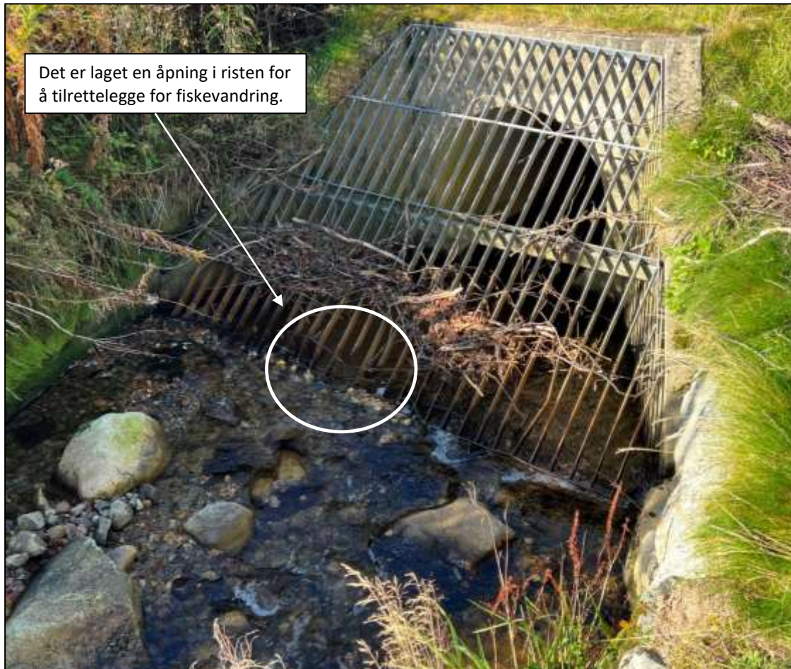
Figur 56. Dersom rist etableres i fiskeførende elver og bekker så bør det gjøres tiltak mht. fiskevandring. Mulige løsninger kan da være å lage en åpning i risten (Tiltak gjennomført i regi av Sjøørretprosjektet i Rogaland, foto: Øyvind Haugland). Problemet med rister vil i mange tilfeller forsvinne ved å øke rørdimensjonen da større dimensjoner på rørene vil kunne føre til at rørene blir selvrensende og behovet for rist ikke være til stede.
