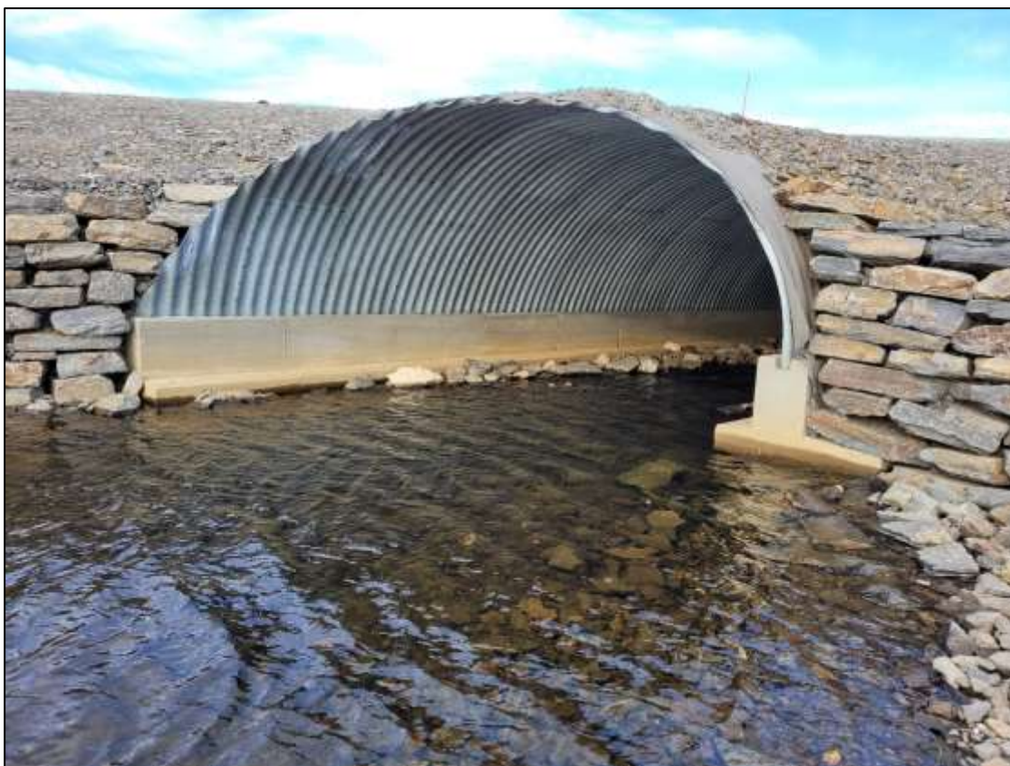
Figur 35. Stor hvelvkulvert støpt på betongelementer i en større elv (Foto: Lemet Heaika Klemetsen Hætta).
