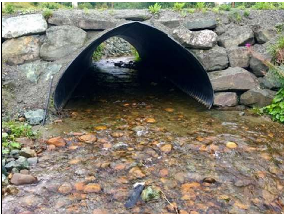
Figur 14. Historisk vegbru med naturlig elvebunn (øverst) og moderne bygget kryssing med halvrør utført på riktig måte. Den naturlige elvebunnen er bevart. Alle relevante fiskearter kan passere når vannstanden er riktig (Foto: Morten A. Bergan, NINA).
