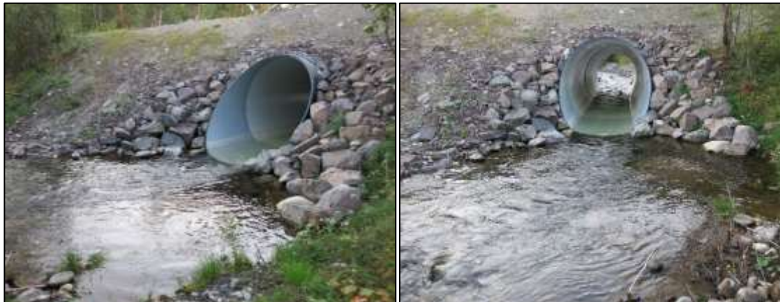
Figur 53. Plastrør uten naturlig bunnsstrat. Fin vanddybde ved inn- og utløp gjør at det blir gode vandringsforhold for fisk gjennom røret (Foto: Øyvind Haugland).
