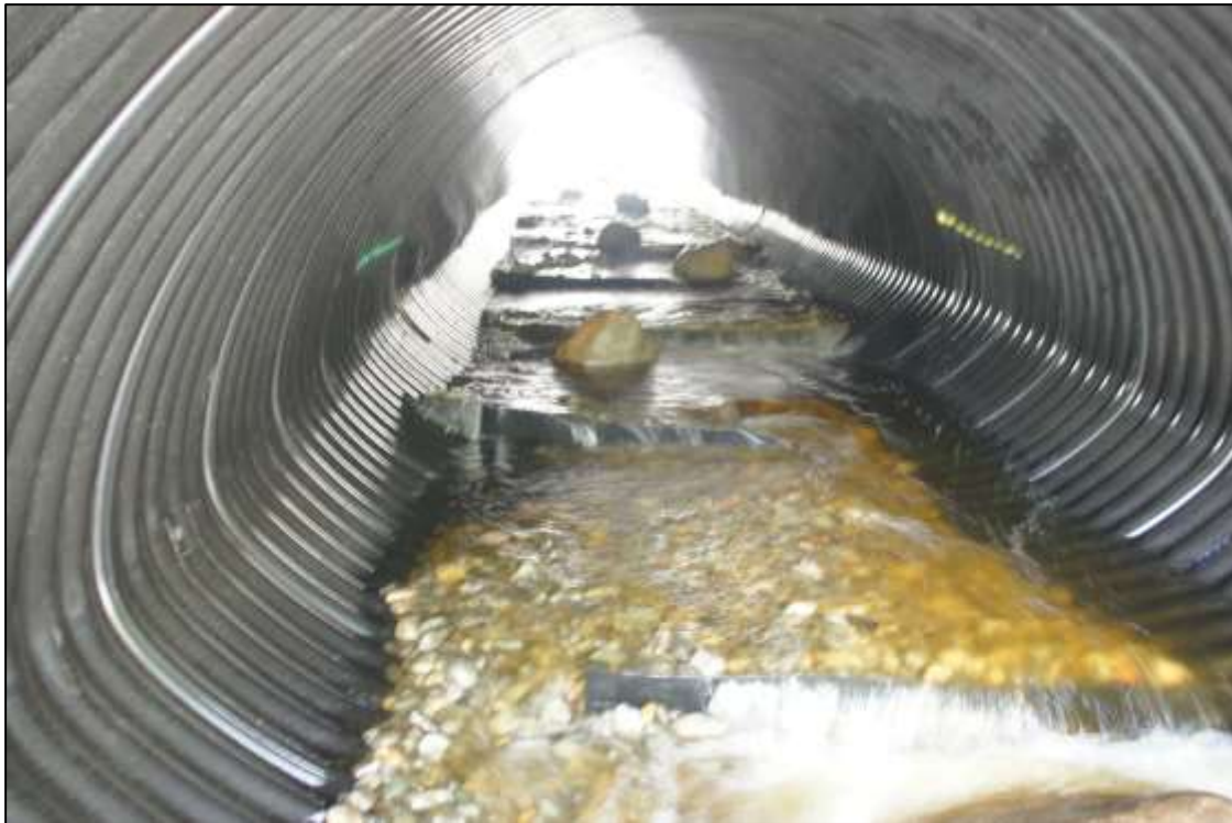
Figur 50. Ovalformede plastrør med terskler og naturlig bunnsbstrat (Foto: Henrik Lissman/Emma Persson)
