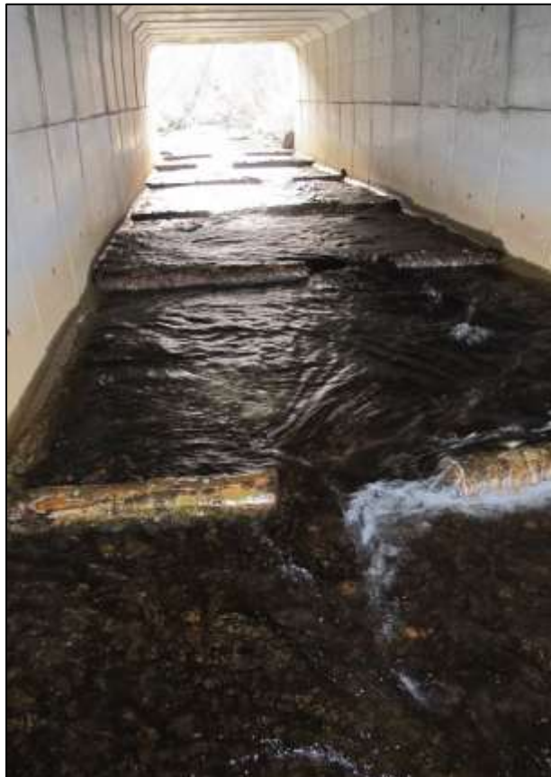
Figur 63. Skisse av treterskelkonstruksjon (osp/malmstokker) i kulvert (Kilde: NVE Region nord) og kulvert med ospestokker, som fungerer som fisketrapp (Foto: Øyvind Haugland).
