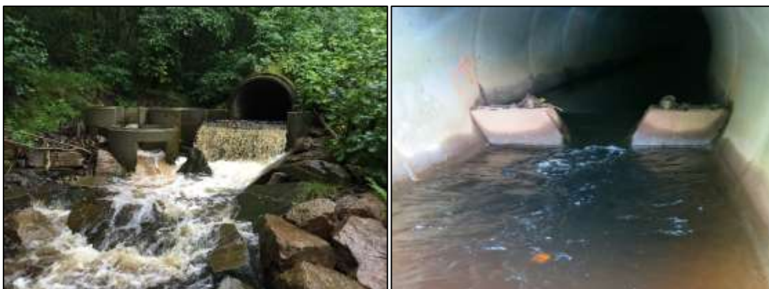
Figur 69. Gode vandringsforhold for fisk opp og gjennom kulverten etter utbedringen (Foto: Paul Ridola).
