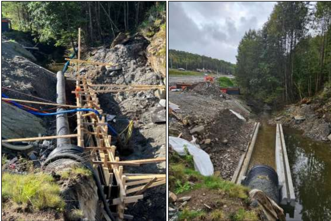
Figur 40. Fundament til hvelvkulverten støpes på stedet. Det etableres naturlig bunnsstrat i bekken mellom fundamentene (Foto: Øyvind Haugland).
