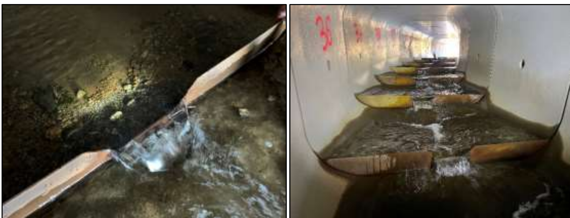
Figur 45. Terskler etablert inni bokskulverten i Høylandsåna (Sjøørretprosjektet i Rogaland, foto: Øyvind Haugland).
