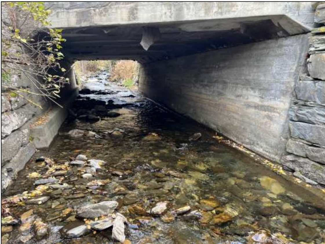
Figur 31. Naturlig bunnsbunnsstart i plasstøpt bru i fylling (Foto: Øyvind Haugland).
