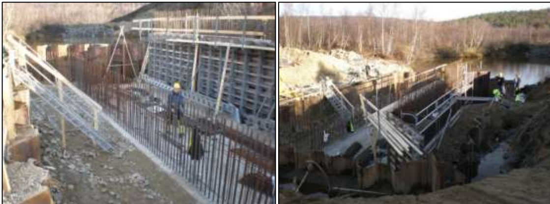
Figur 32. Støping av betongkulvert (bru i fylling) i Savkadasjohka, sideelv til Tana. Spuntet byggegrep ble brukt i prosjektet for å gjøre det mulig for entreprenøren å jobbe tørt (Foto: Haile Garmann Hansen).
