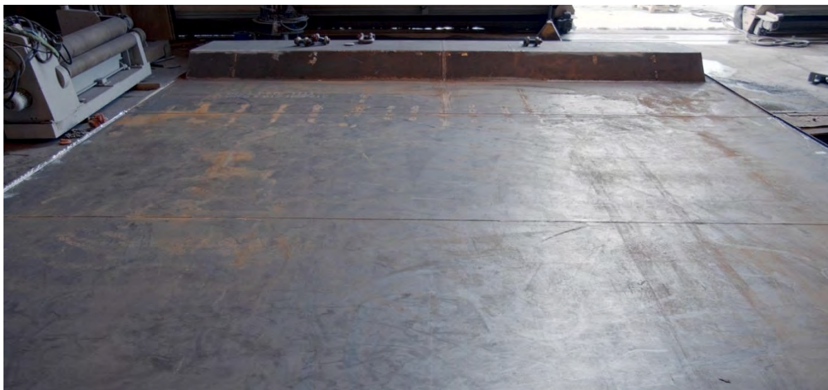
Figur 28 Dekksflate sveist med laser uten etterbehandling med varme
