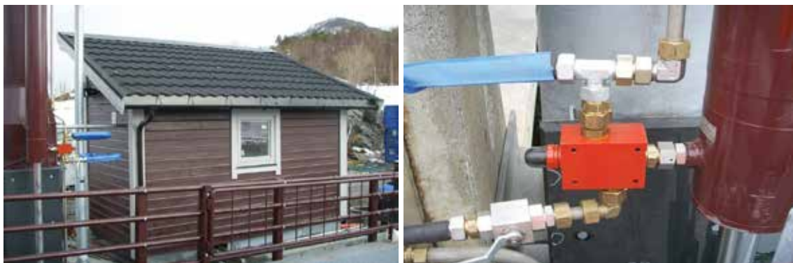
Figur 10: Sjokkventil montert på hydraulisk sylinder
