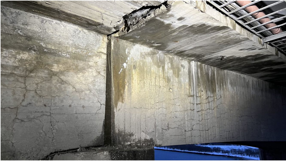
Figur 4.3: Opplegg i akse 32. Eget bilde fra inspeksjon.
