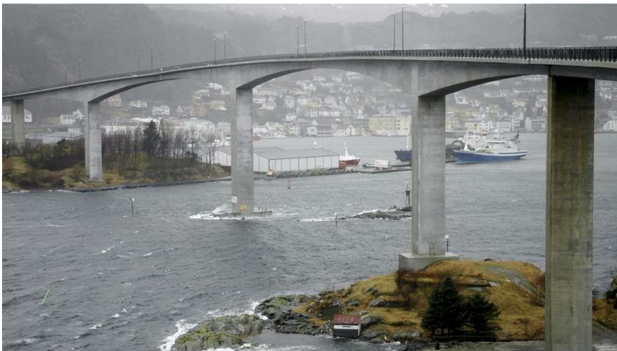
Figur 2.1 - De to hovedspennene på Måløybrua med lengde 125m (Gloppen, 2017)
