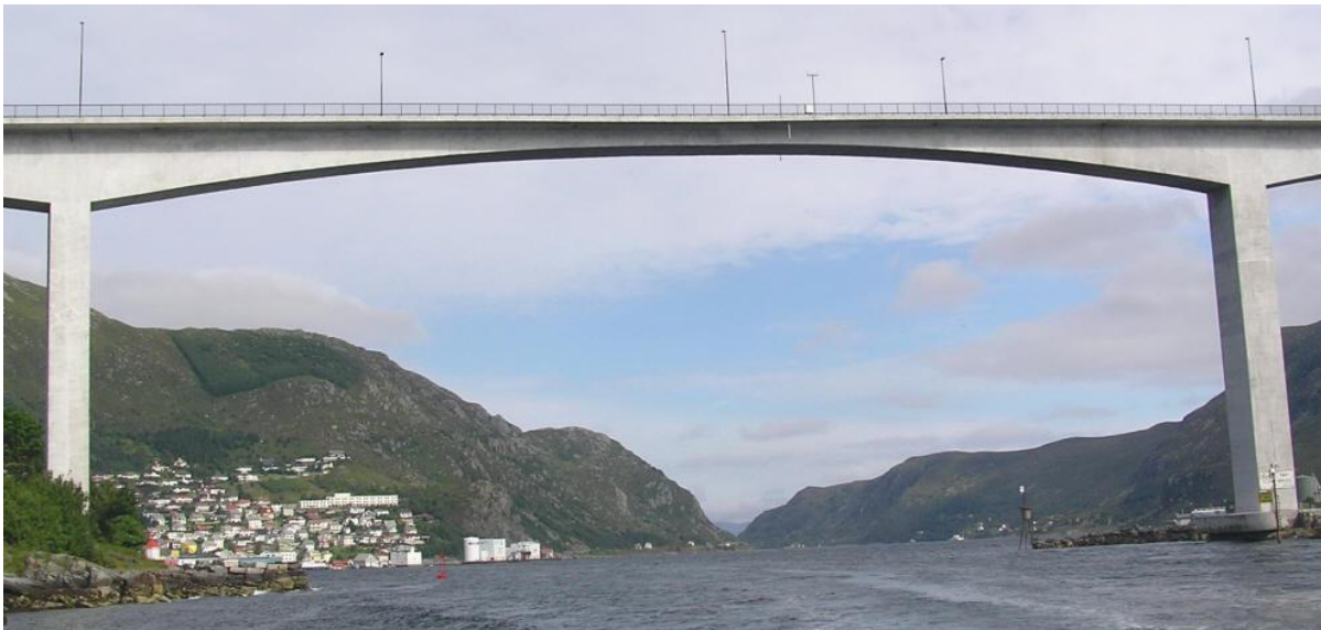
Figur 6.10 – Ett av hovedspennene på Måløybrua
