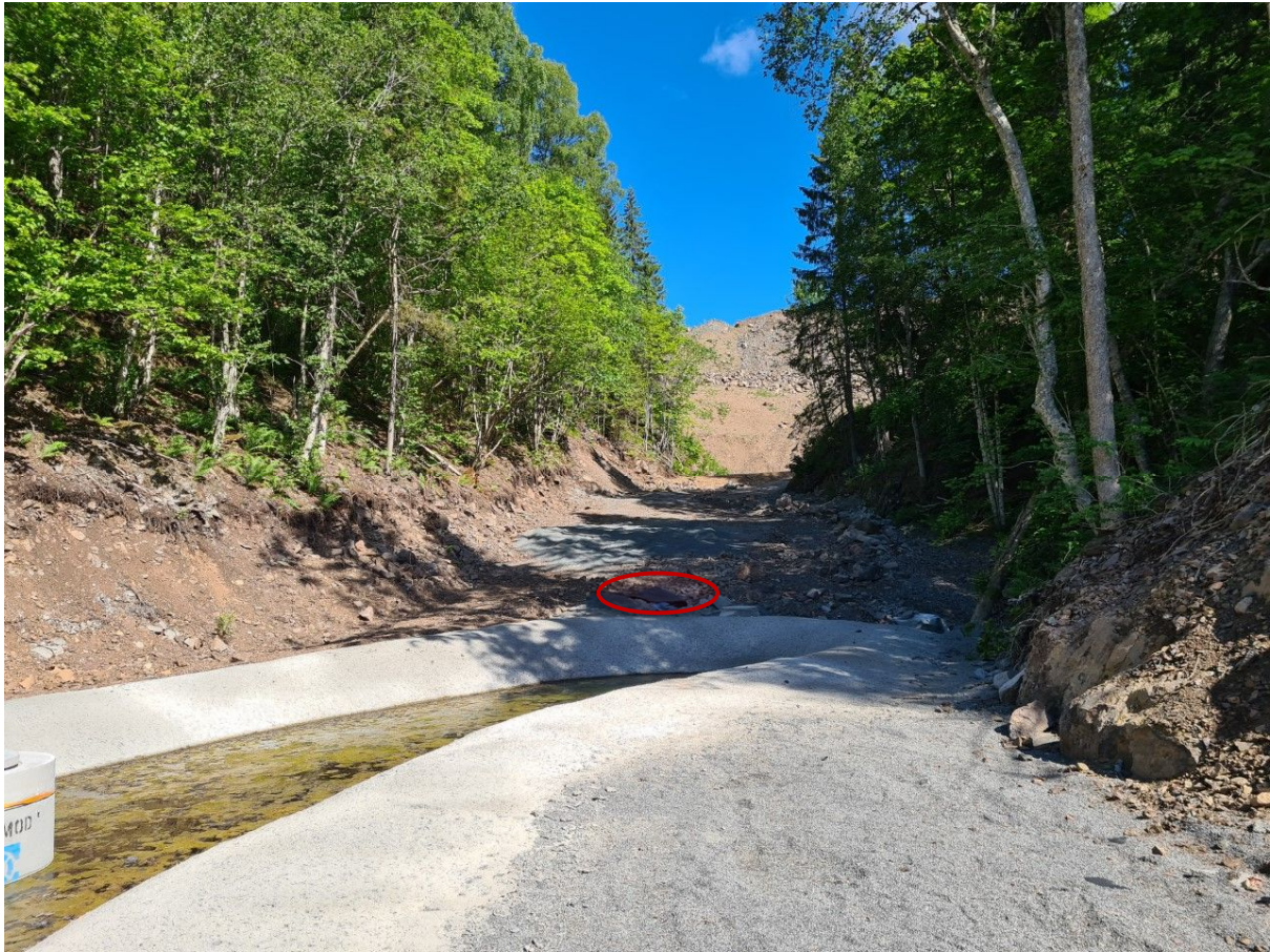
Figur 4. Forkammer med steinfyllingen i bakgrunnen. Innløpskummen for forkammeret blir illustrert med en rød sirkel. (foto: Manh-Tien Bui)
