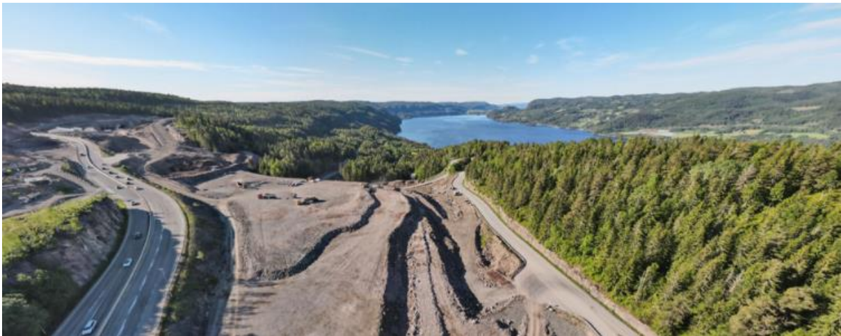
Figur 4. Dronebildet av deponiet mot Holsfjorden (dronebilde, SVV).
