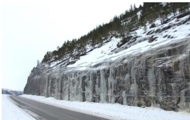
Figur 17) Vannet renner i et tynt torvlag og fryser der det kommer ut på kalde svaberg. E39, Vinjefjorden. Foto. A. Liereng
