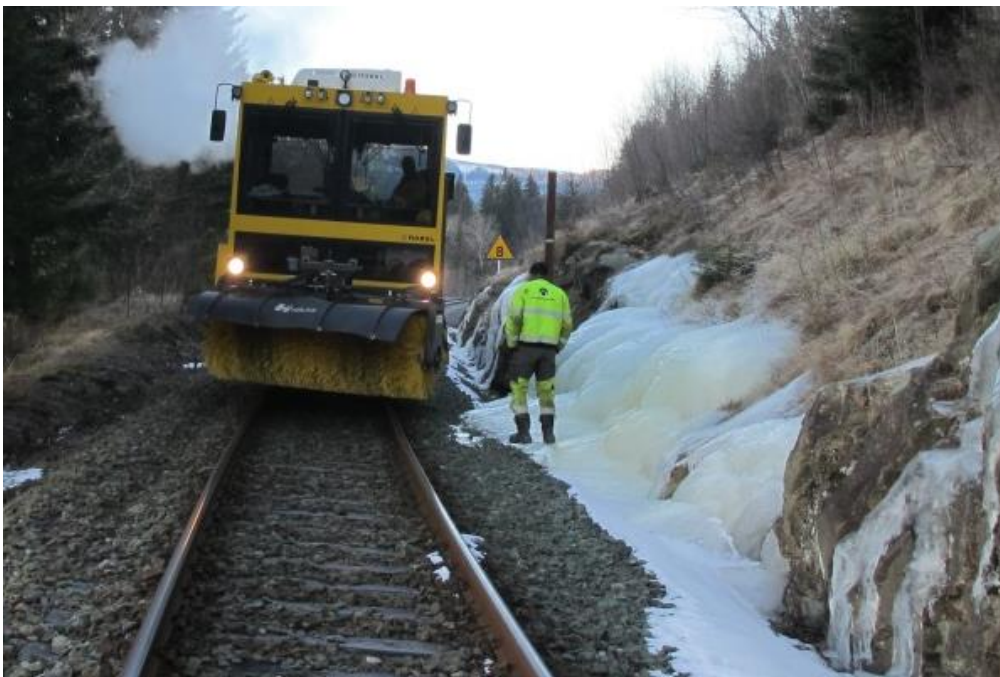
Figur 30) Iskjøving fra grunnvann i lav skråning langs Meråkerbanen. Vannet ble presset til overflaten etter en periode med barfrost. Foto. A. Liereng (15.1.16)
