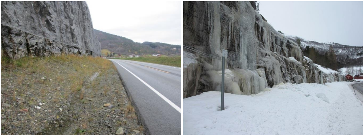
Figur V- 66a) Bred fanggrøft langs veien er gunstig for trafikksikkerhet. Foto: A Liereng (3.11.15). b) Fanggrøfta samler opp mindre isras, som ellers ville havnet i vegbanen. Foto: A. Liereng (9.3.16).
