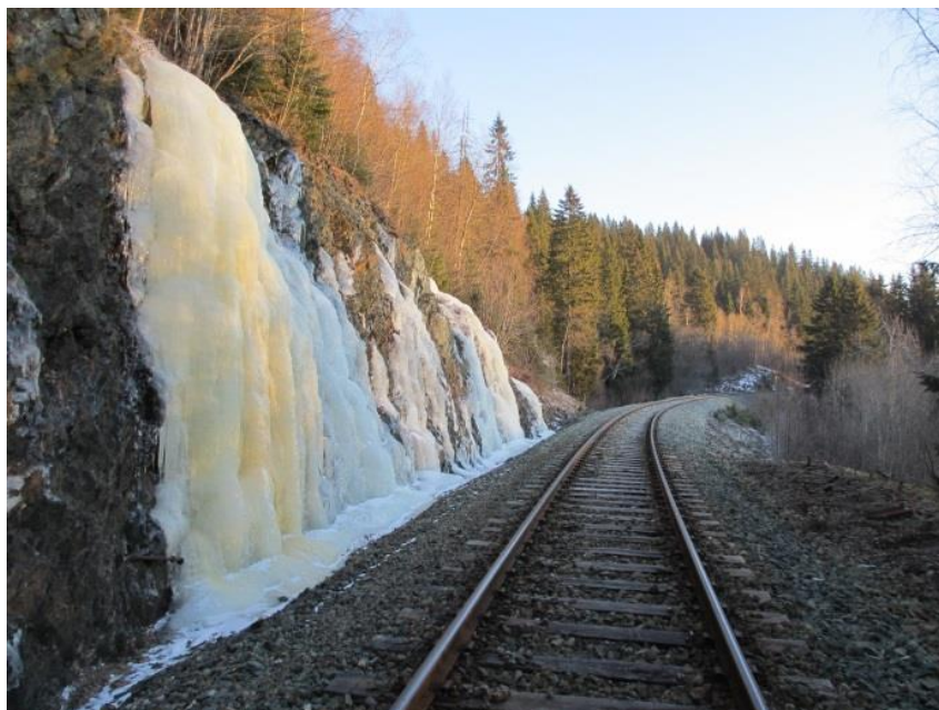
Figur V- 30) Iskjøving i skjæring og grøft. Foto: A. Liereng (15.1.16)
