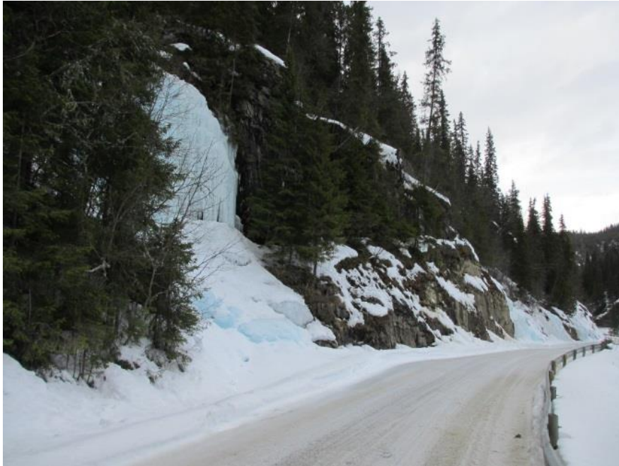
Figur V- 47) Det er god plass for iskjøvingen og isen utgjør ingen fare for vegen. Foto: A. Liereng (29.3.16).
