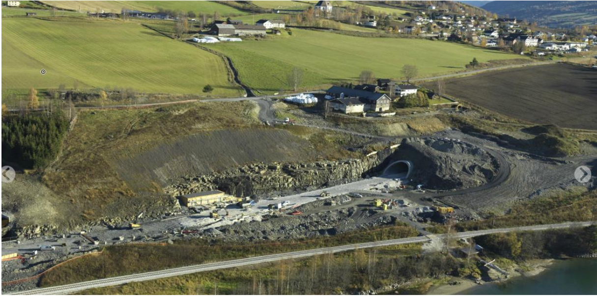
Figur V- 71) Oversiktsbilde av tunnelportalen ved Odenrud. Det er laget en jordskjæring med en fjellskjæring nederst langs vegen. Det tekniske bygget er plassert helt inntil skjæringen. Foto: Arild Solberg (Statens vegvesen, 2016a).
