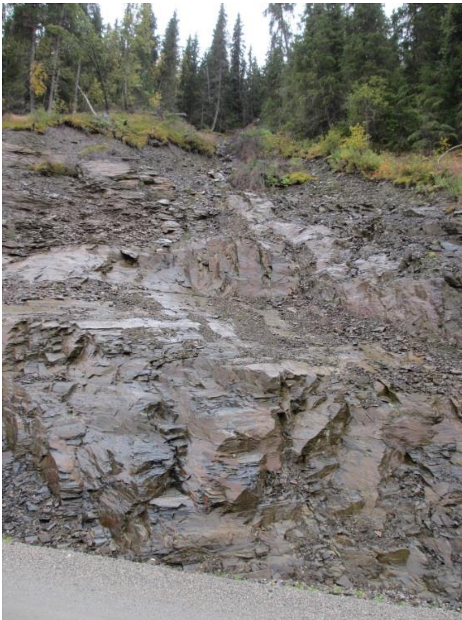
Figur V- 43) Fjellsiden ovenfor vegen er ryddet for løsmasser og vegetasjon etter et jordskred i august 2013. Foto: A. Liereng (20.9.15)
