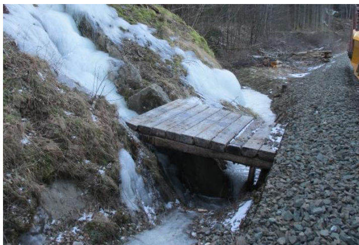
Figur 84) Svill-overbygg over innløp til stikkrenne langs Meråkerbanen. Foto: A. Liereng
