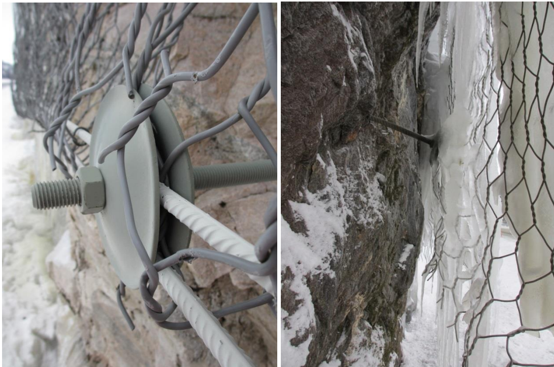
Figur 78a) Nettet avsluttes med en waier som tres gjennom nettmaskene og boltes fast i berget. Nettet brettes tilbake over waieren og festes. b) Isen vokser fra nettet, slik at vann kan renne på baksiden av isen. Begge foto: A. Liereng.
