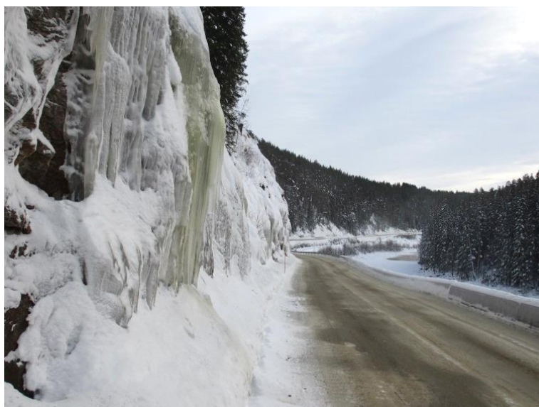
Figur V- 62) Siden avstanden mellom skjæringen og vegen er liten, kommer isen raskt i vegen for bilene. Isen kan også redusere sikten i kurven. Foto: A. Liereng (25.1.16).
