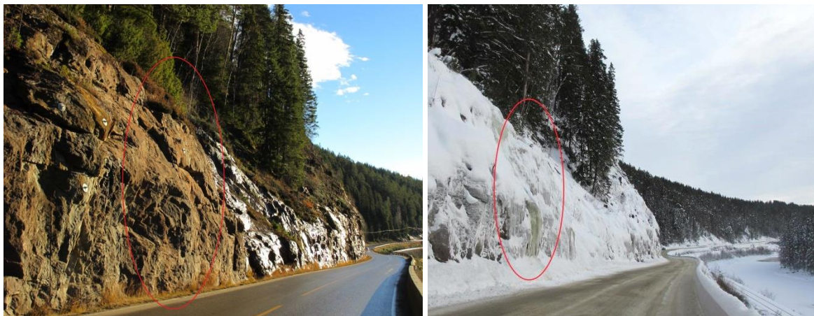
Figur V- 61a) Området markert med rød ring er tørt på høstbefaringen, men her dannes det ofte mye is om vinteren. Foto: A. Liereng (6.11.15). b) Iskjøving i samme område, markert med rød ring. Foto: A. Liereng (25.1.16).
