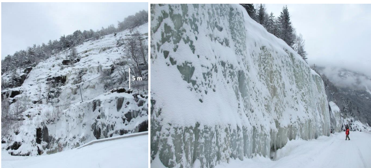
Figur V- 77a) Vegen er sikret med fanggjerder for å stanse isras som løsner høyere opp i terrenget. b) Skjæringene er sikret med isnett som armerer isen fast til berget. Foto: A. Liereng (3.3.16).
