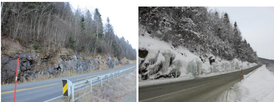
Figur 20a) Lav skjæring langs Fv 30. Berget er vått av grunnvann som renner ut i sjiktet mellom berg og løsmasser. b) Grunnvannet forårsaker iskjøving i hele skjæringen. Foto: A. Liereng
