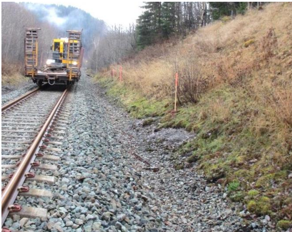
Figur V- 17) Nederste del av skråningen er våt og mosedekket. Det er satt ut stikker i de våteste punktene. Ovenfor stikkene, lenger opp i skråningen, er terrenget nokså tørt. Foto: A. Liereng (5.11.15).
