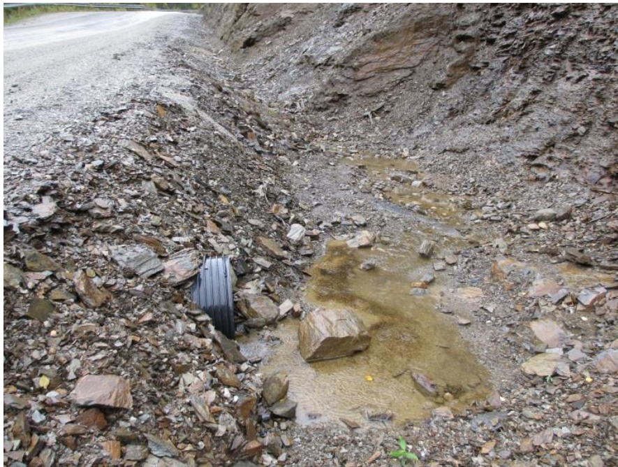
Figur V- 45) Stikkrenne under vegen nedenfor skredbanen. Grøfta er bred og dyp, og har god lagringskapasitet for is. Foto: A. Liereng (20.9.15)
