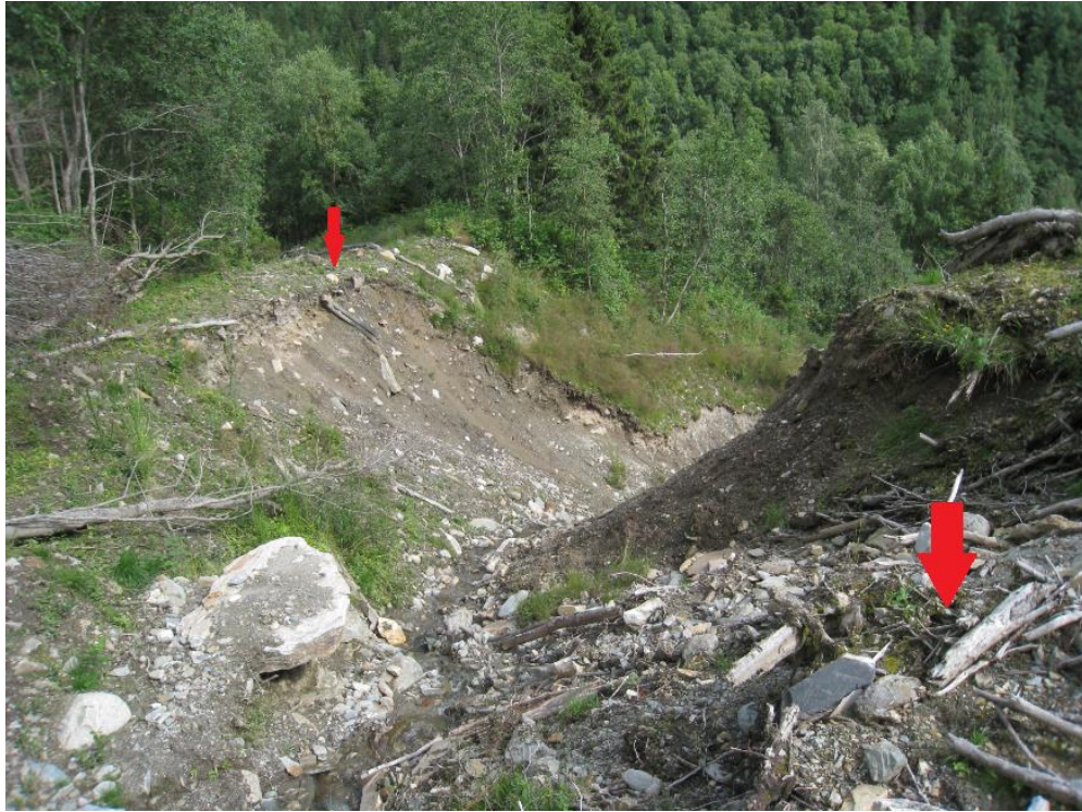
Figur 5.36 Bilde som viser dypt kutt i skogsbilvei. Skredet som gikk i skredløp 1-2 eroderte seg ca. 4 meter i skogsbilveien. Partiet mellom de to røde pilene markerer hvor veien opprinnelig lå før skredhendelsen. Foto: Daniel Haugen Edvardsen.
