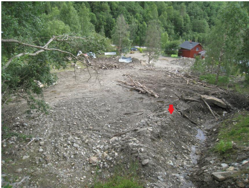
Figur 5.39 Utløpsområdet ca. 1 år etter skredhendelsen. Opprydningsarbeidet har fjernet, og planert ut store deler av skredavsetningene, men fremdeles besto lokaliteten av tydelige spor etter skredhendelsen. Rød pil markerer hvor det i etterkant var blitt bygget opp en ledevoll nedenfor skredløp 1-2, som i hovedsak var konstruert til å drenerer vekk rennende vann fra skredløpet. Foto: Daniel Haugen Edvardsen
