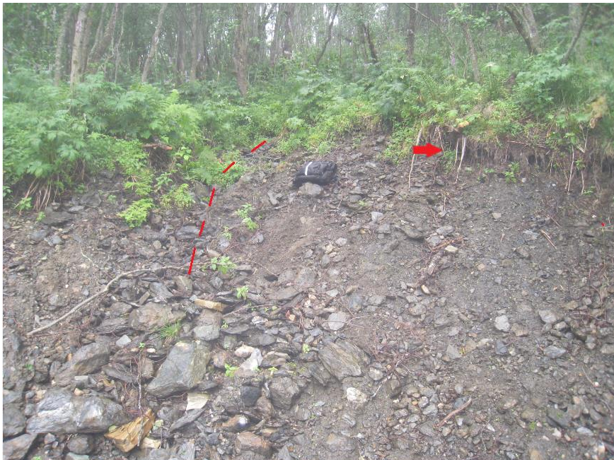
Figur 5.49 Utløsningsområdet til skred 5. Rød stippet linje markerer der det ble observert et dypere parti med spor etter rennende vann fra terrenget ovenfor. Legg også merke til større sedimentene med større kornstørrelser nedenfor dette partiet. Rød pil viser hvor det var hulrom mellom torva og løsmassene i utløsningsområdet, og man kan se røtter som henger igjen. Foto: Daniel Haugen Edvardsen.
