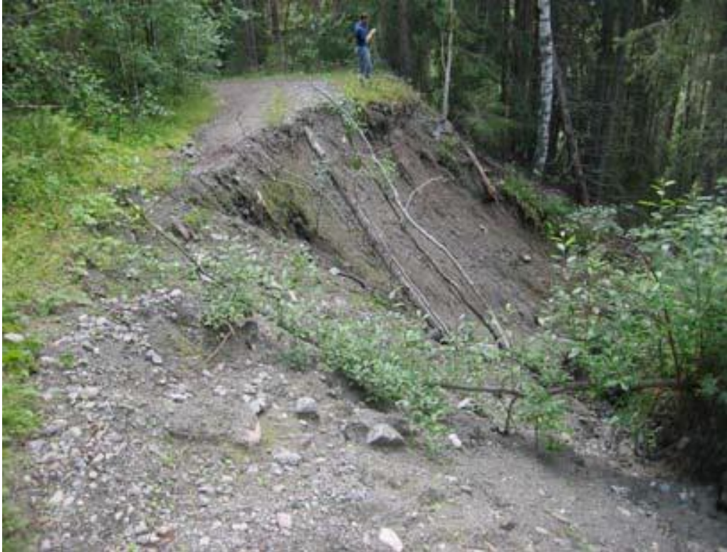
Figur 2.10 Eksempel på skred i et terreng med skogsbilvei. Fyllingen hvor personen står er betydelig brattere enn hva den naturlige skråningen er (Fergus et al., 2011).
