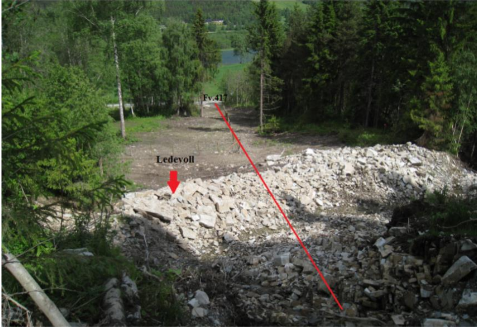
Figur 5.8 Utløpsområdet til skred 1. Rød strek markerer hvor skredet beveget seg nedover og over fylkesvei 417. Bredden på skredpartiet er ca. 30 meter. I etterkant har det blitt bygget en ledevoll som skal forhindre mer massetransport over veien (markert med rød pil). Foto: Daniel Haugen Edvardsen.
