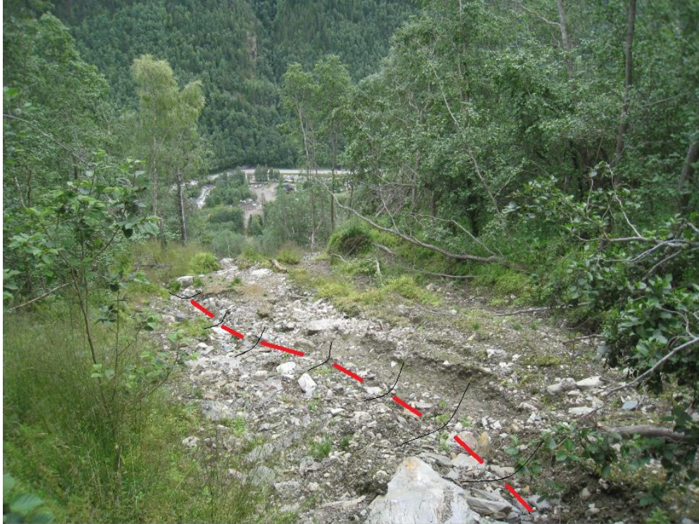
Figur 5.30 Skredløp 2 nedover dalsiden. Rød stiplet linje, og buete svarte streker markerer spor etter erosjon av rennende vann som har dannet en dypere kanal innad i løsmassene i skredløpet. Lokaltiteten ble målt til å være ca. 10 meter bred, og skredløpet hadde et dyp på ca. 40 cm. Det ble også observert store variasjoner i kornstørrelser, fra blokk til finkornet materiale. Foto: Daniel Haugen Edvardsen.
