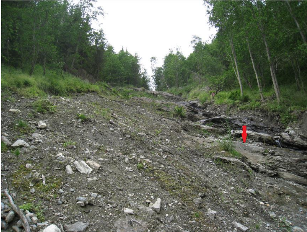
Figur 5.51 Skredløp ned mot utløpsområdet til skred 5. Partiet ble målt til å være ca. 25 meter bredt, og rød pil markerer hvor skredet eroderte seg ned til berggrunnen. Foto: Daniel Haugen Edvardsen.
