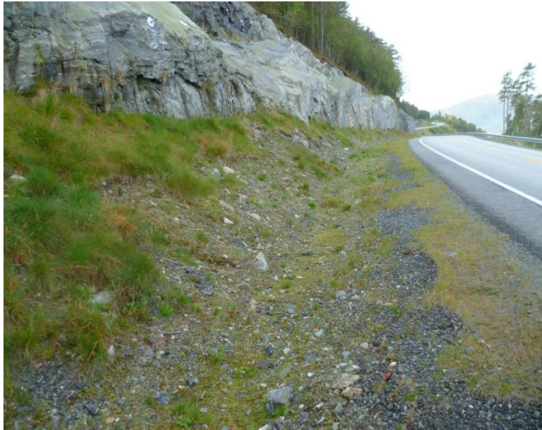
Figur 8. Grunn sidegrøft etter utbetring, E39 Staurset – Renndalen, Foto: Kvalsvik.
