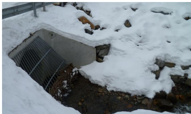
Figur 16. Tilpassa rist på vingemur, E6 Labbdalen - Skaberud, Foto: Kvalsvik, 2015.
