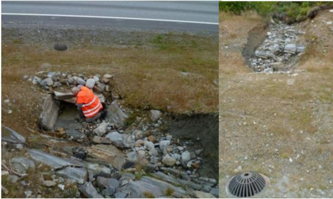
Figur 13. Frå bekkeinntak til kum, E39 Astad - Høgset, Foto: Kvalsvik.
