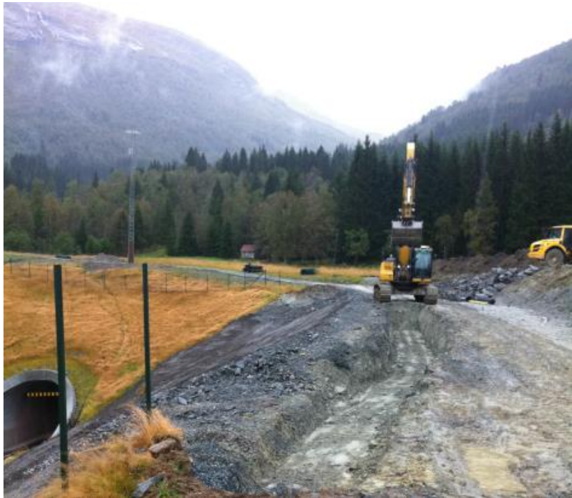
Figur 15. Drenering ved innløp til tunnel, Foto: Svein Skeide, Statens vegvesen
