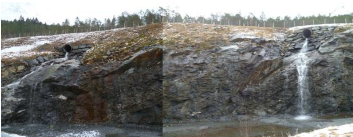
Figur 20. To av tre bekkeutløp som fører til fordrøyningsbasseng, Foto: Kvalsvik, 2015.
