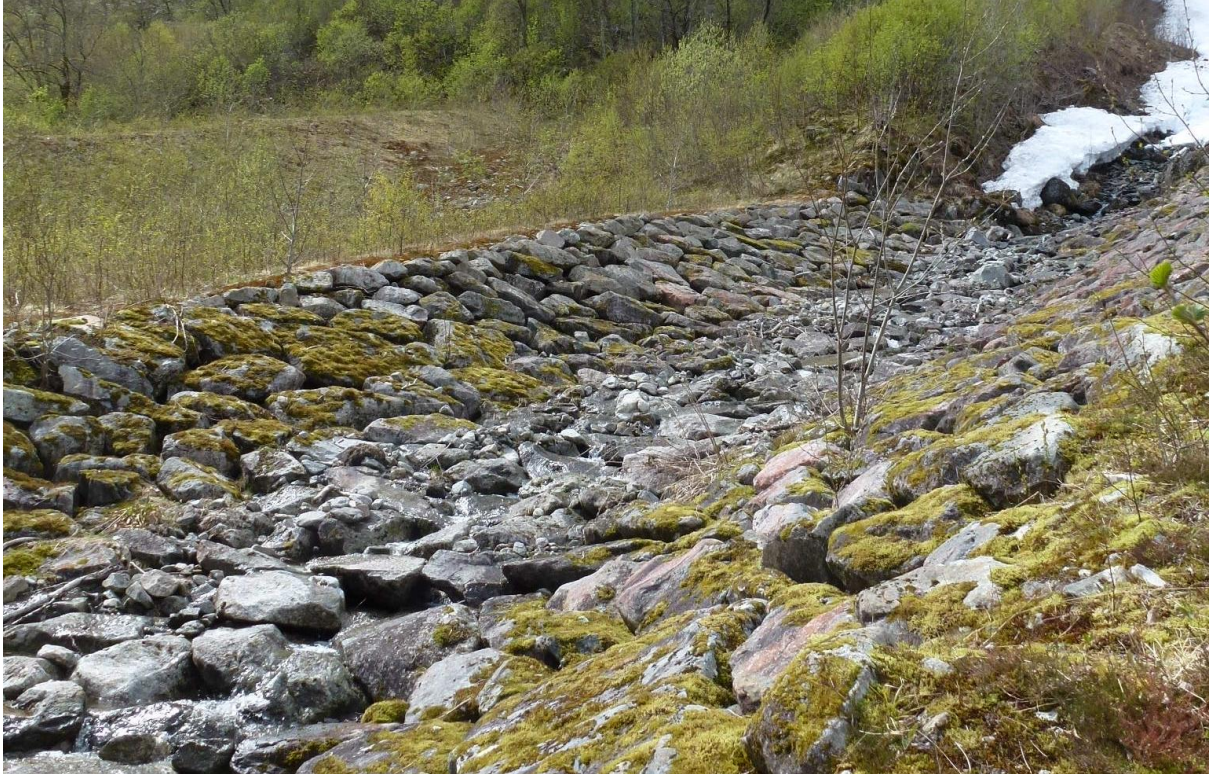
Figur 6-55 Breiskreda - steinplastret bekkeløp
