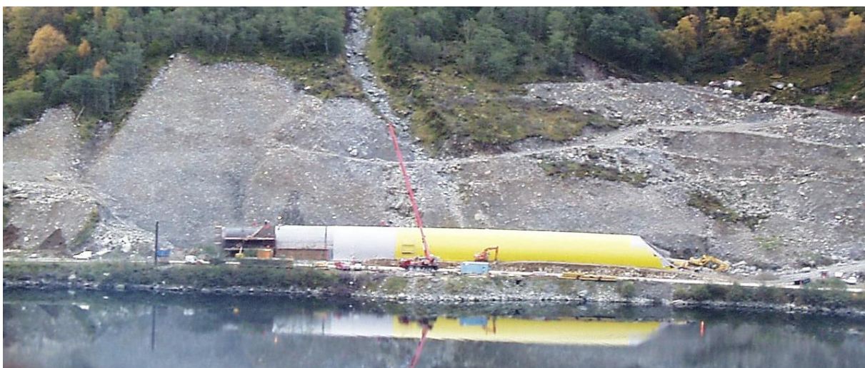
Figur 3-5 Bygging av betongrørtunnelen ved Skasvora ved Rv 615 Hyen – Sandane (foto: Frækaland)
