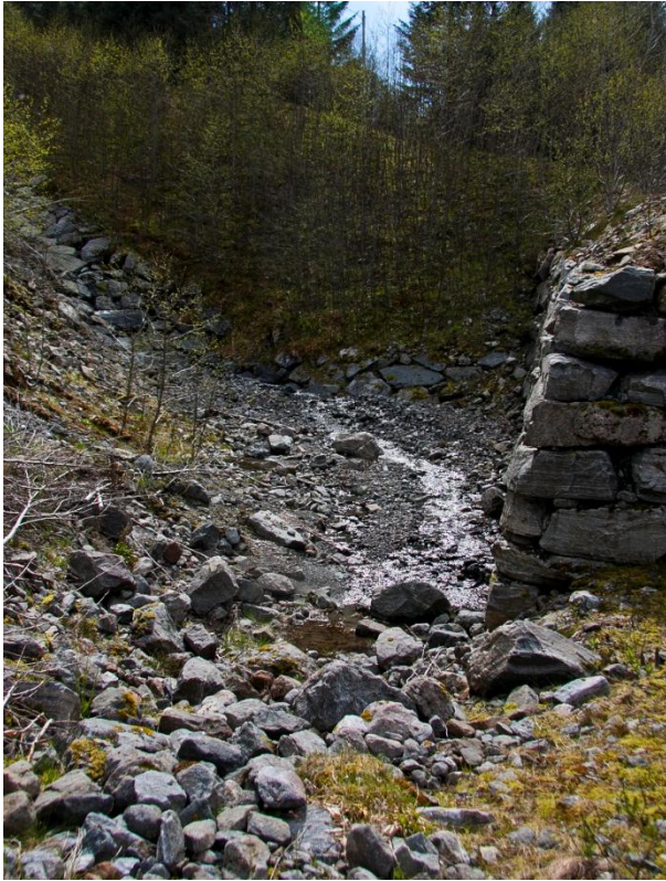
Figur 6-4 Saltrefonna - mye stein igjen etter sørpeskredet
