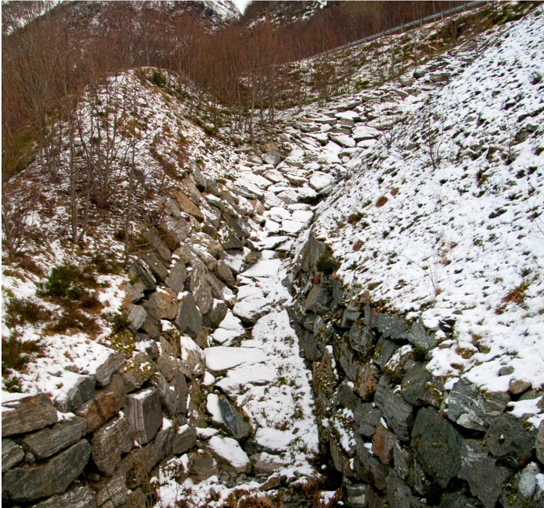
Figur 6-17 Storegjølet Sør – skredbanen på nedsiden av vegen
