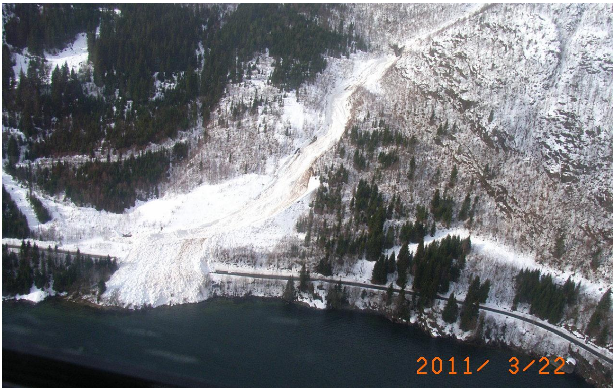
Figur 6-42 Sanskreda, snøskred sperrer vegen, (Frækaland)
