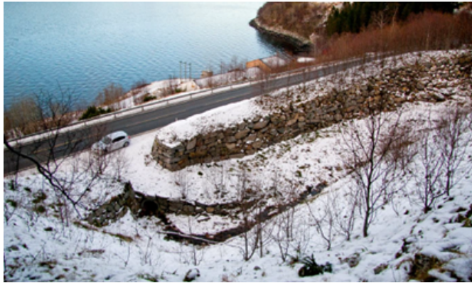
Figur 4.3: Storegjølet Sør-magasin og dagmagasin til stikkrenna (Aas, 2012)
