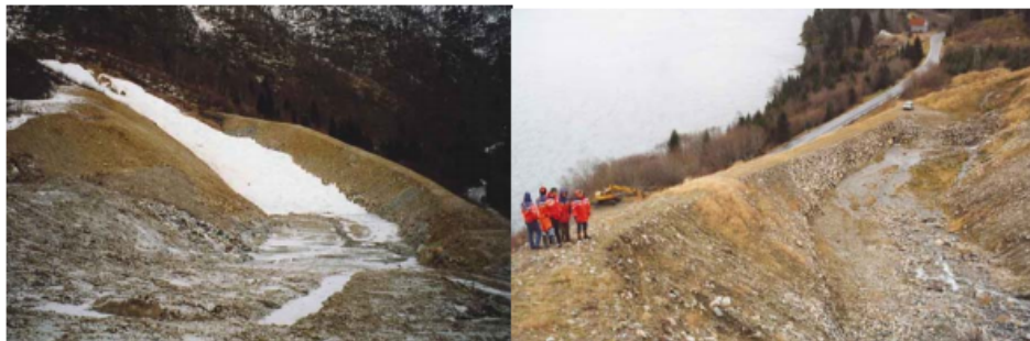
Figur 3.3: Eksempel på ledenvoll for sikring mot snøskred og sørpeskred. Vollkrona er dessverre ikke bygget med jamn stigning i øvre delen av vollen, og på dette partiet har skred gått over vollen, Sandvika, Sogn og Fjordane (Foto: Harald Norem) (Vegdirektoratet, 2011).
