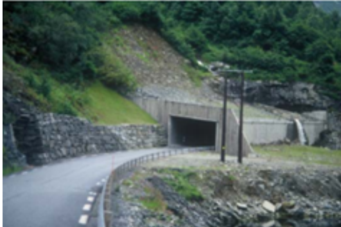
Figur 3.1: Eksempel på skredoverbygg som også fungerer som en tunnelportal. (Vegdirektoratet, 2011).
