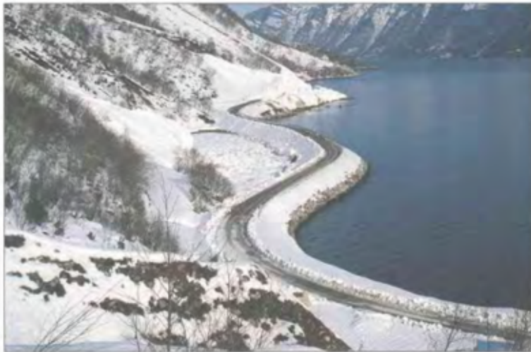
Figur 3.6: Når vegen flyttes mer enn 30 m fra fjellsiden har en sikret vegen mot de fleste skred av normal størrelse. (Foto: H. Norem) (Vegdirektoratet, 1993)
