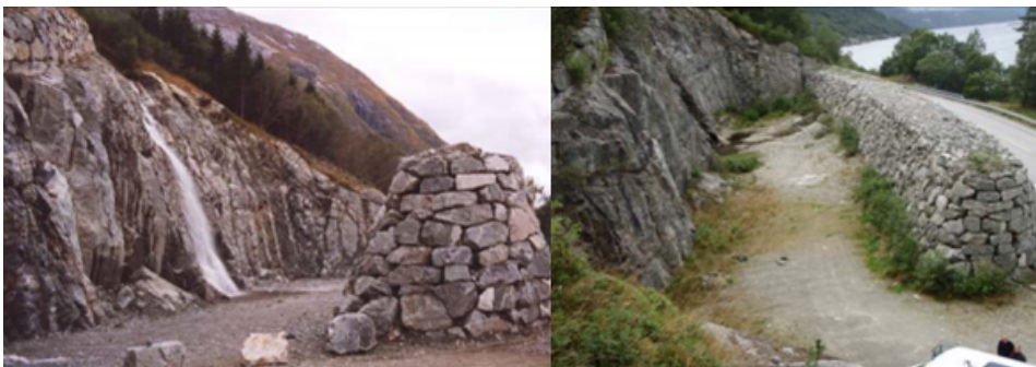
Figur 3.4: Foto av fangvoll med bratt tørrmur på begge sider, Rv 7, Indre Rotagjelet, Hordaland. (Foto: H. Norem) (Vegdirektoratet, 2011).
