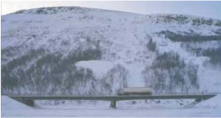
Figur 3.2: Eksempel på bru bygd som sikringstiltak mot skred. (Vegdirektoratet, 2011).
