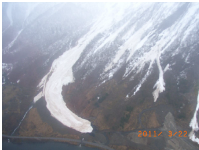
Figur 4.7: Storesvora-skredmasser har fylt opp tiltaket (Aas, 2012)
