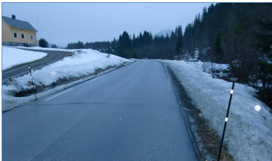
Figur 11.9 Fra fv. 610 i Sogn og Fjordane, den nordlige enden av EPS-myrbroen. Myrbroen går innover i bildet (S. Hermansen, 2012).
