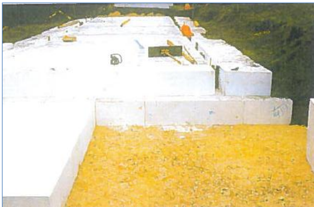
Figur 11.6 Utlegging av EPS, legg merke til mellomrommet mellom blokkene hvor betongbjelka skal støpes (Ref.9).
