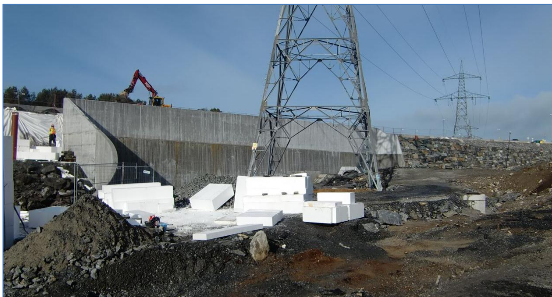
Figur 9.5 Mur med EPS-oppfylling bak (S. Hermansen, 2012).
