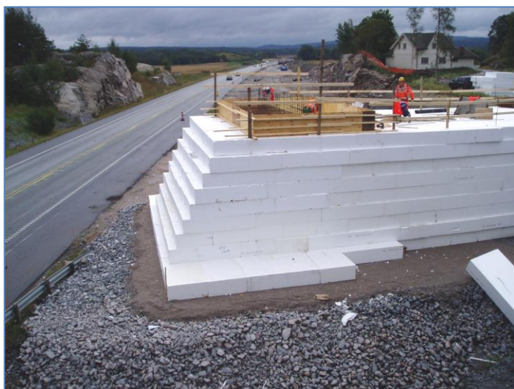
Figur 10.14 Gimsøyveien bro, en midlertidig bro fundamentert direkte på EPS, stod over E6 i Halden kommune (Ref.33).
