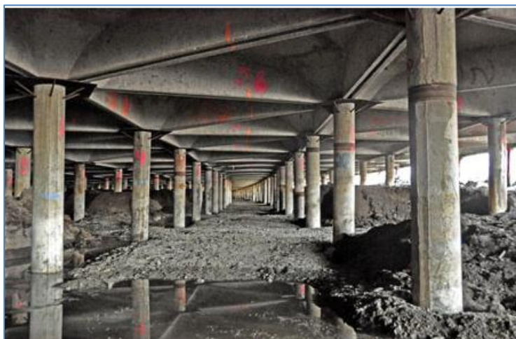
Figur 7.1 Legg merke til karakteristiske skallene i Stubberudmyra bro på E6 nord for Oslo (A. Håkonsen, 2011).
