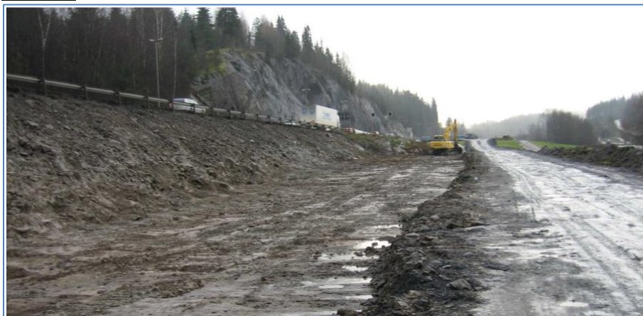
Figur 4.1 Forberede utleggingsstedet maskinelt, slik at det blir en relativ jevn overflate (Ref. 20).
