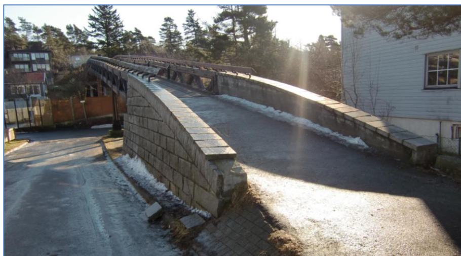
Figur 10.11 Ferdig fundament med kledning, fra G/S-broer i Fredrikstad (S. Hermansen, 2012).
