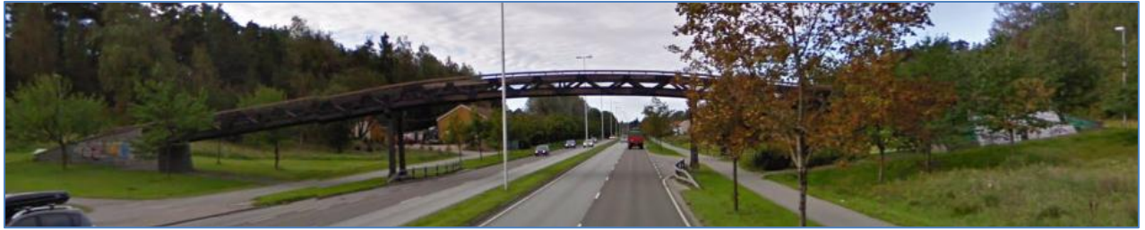
Figur 10.6 Leie gang- og sykkelveibro over fv.109 i Fredrikstad (Google street view, 2012).
