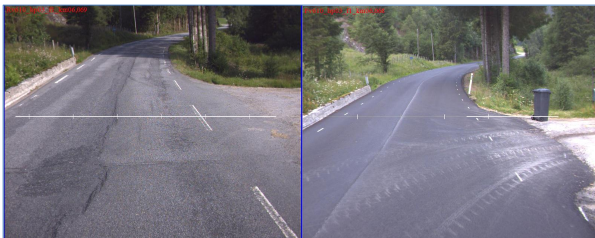
Figur 11.14 T.v.: Fra 2008 med et 12 år gammelt dekke. T.h.: Fra 2009 med nylagt dekke (ViaPhoto).
