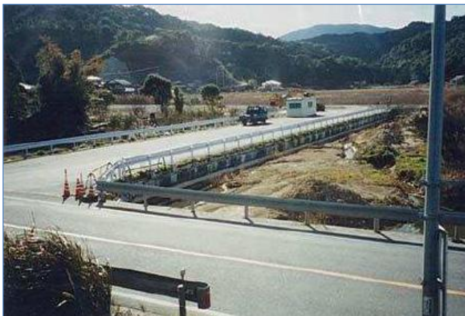
Figur 6.7 Ferdig veg på fylling med OM EPS-blokker i Japan (Ref. 38).
