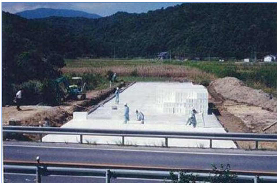
Figur 6.6 Fylling med oppdrifts-motstandsdyktig EPS i en myr i Japan (Ref. 38).
