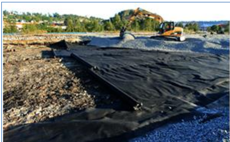
Figur 3.2 Utlegging av skumglass over dårlig grunn over jernbanens nye driftsgård i Halden. (Ref. 43).
