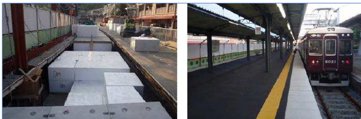
Figur 6.3 T.v.: Jernbaneplattform i Japan, under bygging (ref.39). T.h.: Ferdig plattform (ref.39).
