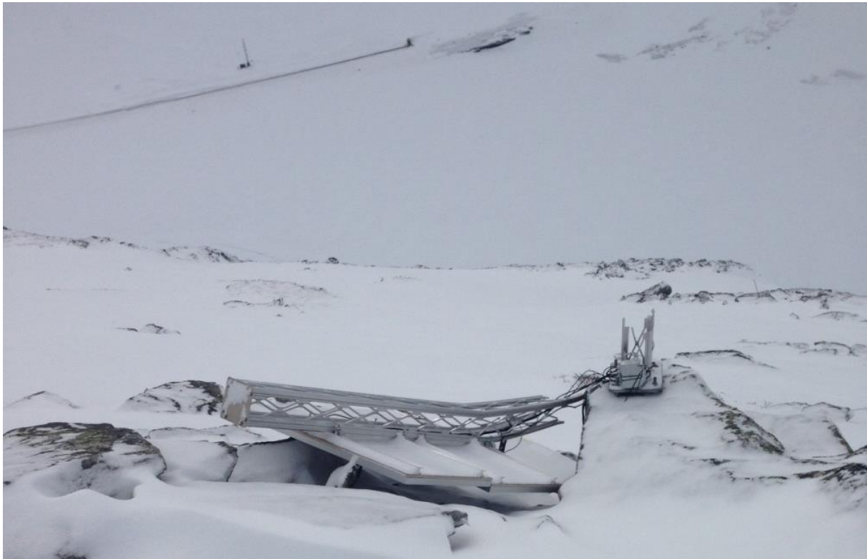
Figur 5.27 - Ødelagt mast med solcellepanel, kommunikasjonsenhet og vindturbin oppdaget under feltbefaring den 25. februar 2015 (foto: Tore Humstad, SVV, 25. februar 2015).
