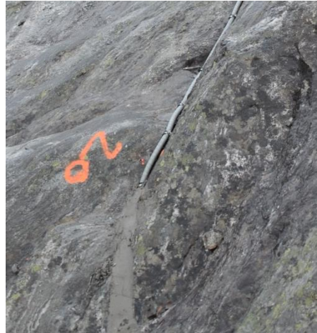
Figur 4.6 - Plassering av kabel bak formasjoner (t.v.) og frest ned og dekt til med mørtel (t.h.) (foto: Tore Humstad, SVV, 23. oktober 2014).
