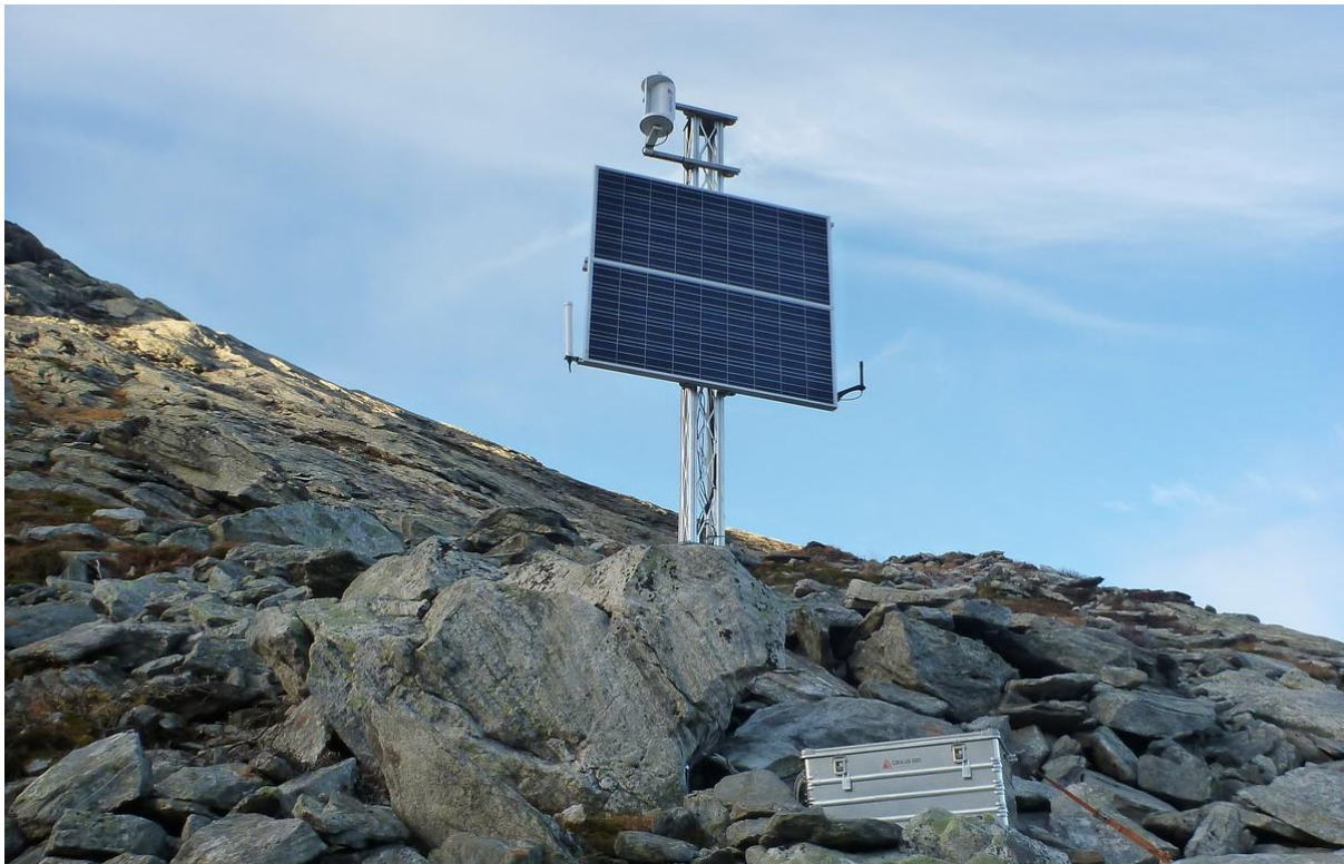
Figur 4.7 - Solcellepanel og vindturbin som driver datalogger som er plassert i aluminiumskasse. Utstyret er plassert like utenfor glidesonen til startsonen på Stavbrekka for å unngå påkjenning fra snødekket (foto: Tore Humstad, SVV, 15. oktober 2013).
