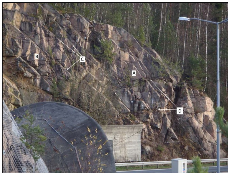
Figur 6.4: Oversikt over sprekkesett i bergmassen ved krabbetunnelens søndre portal. Bildet er tatt fra sør-øst (Multiconsult, 2015).
