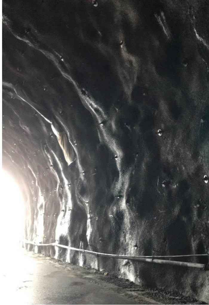
Figur 5.5: Sprøytebetongbuer i inngangspartiet til sidetunnelen på Mekjarvik.
