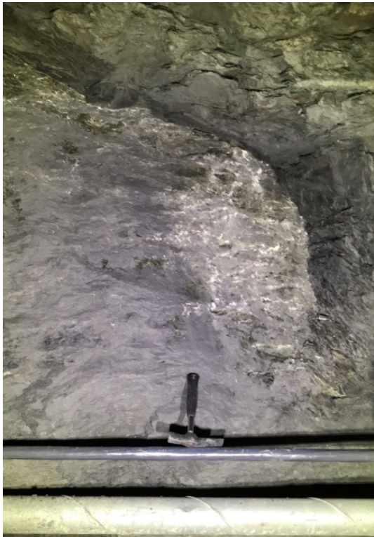
(a) Profil 513 i sidetunnelen på Mekjarvik.
