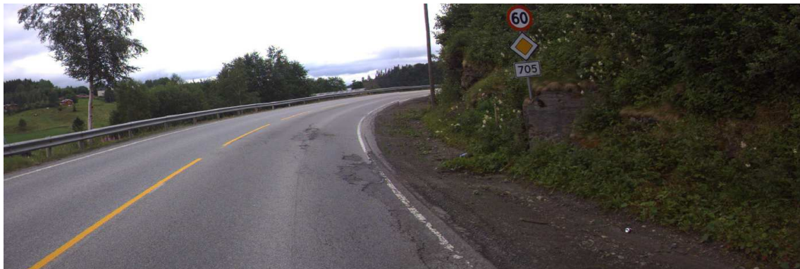
Bilde 31: Slaghull og nedkjørt vegskulder
