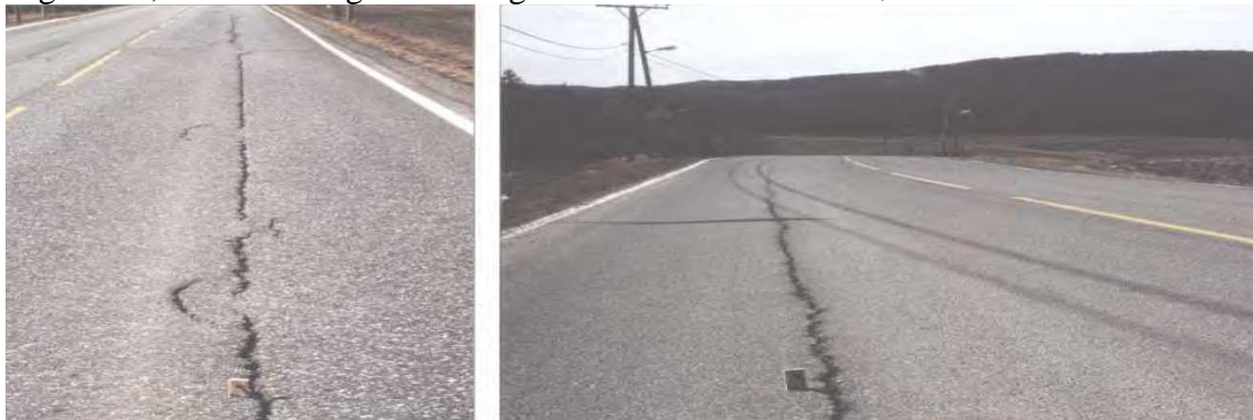
Bilde 7: Midtsprekker ved breddeutvidelse
