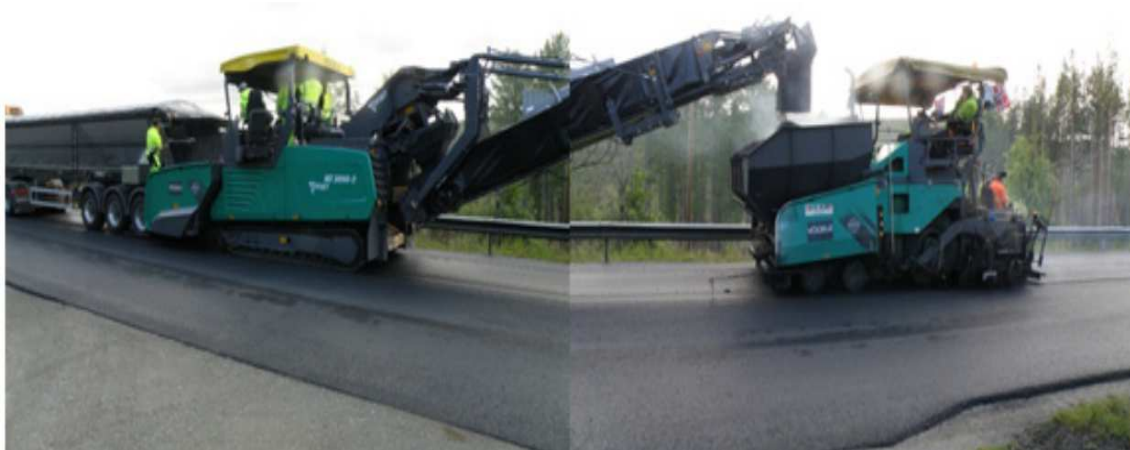
Bilde 42: Bruk av feeder som tiltak for å begrense varmetap under asfaltutlegging
