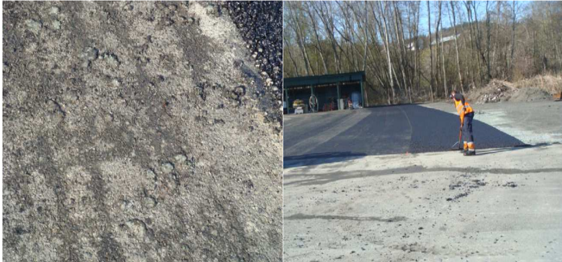
Bilde 49: Kald asfalt er ikke fjernet fra det gamle dekket
