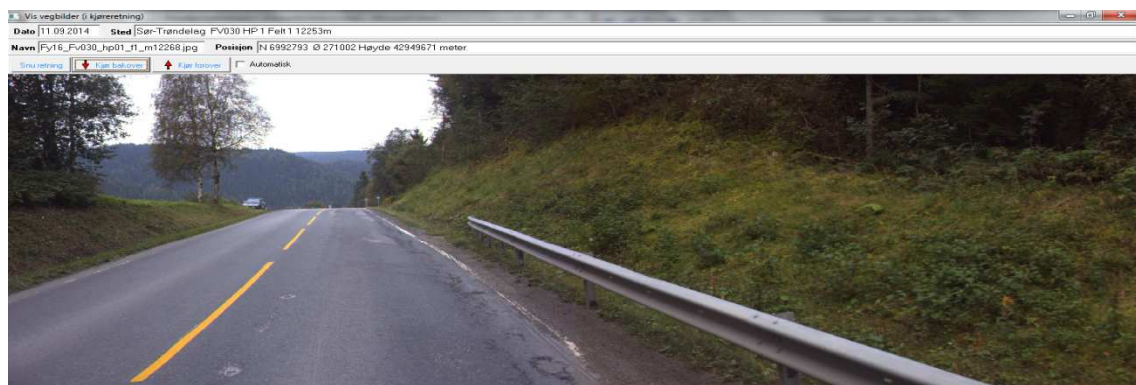
Bilde 33: Slaghull, mangel på drenering og dårlig fundament
