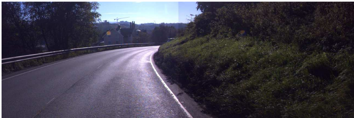
Bilde 27: Mangel på drenering og dype spore på dekke
