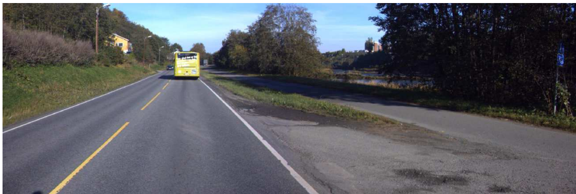
Bilde 25: Synlige spor på dekke og kantskader
