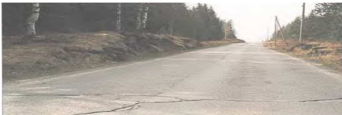
Bilde 10: Tversgående telesprekker
