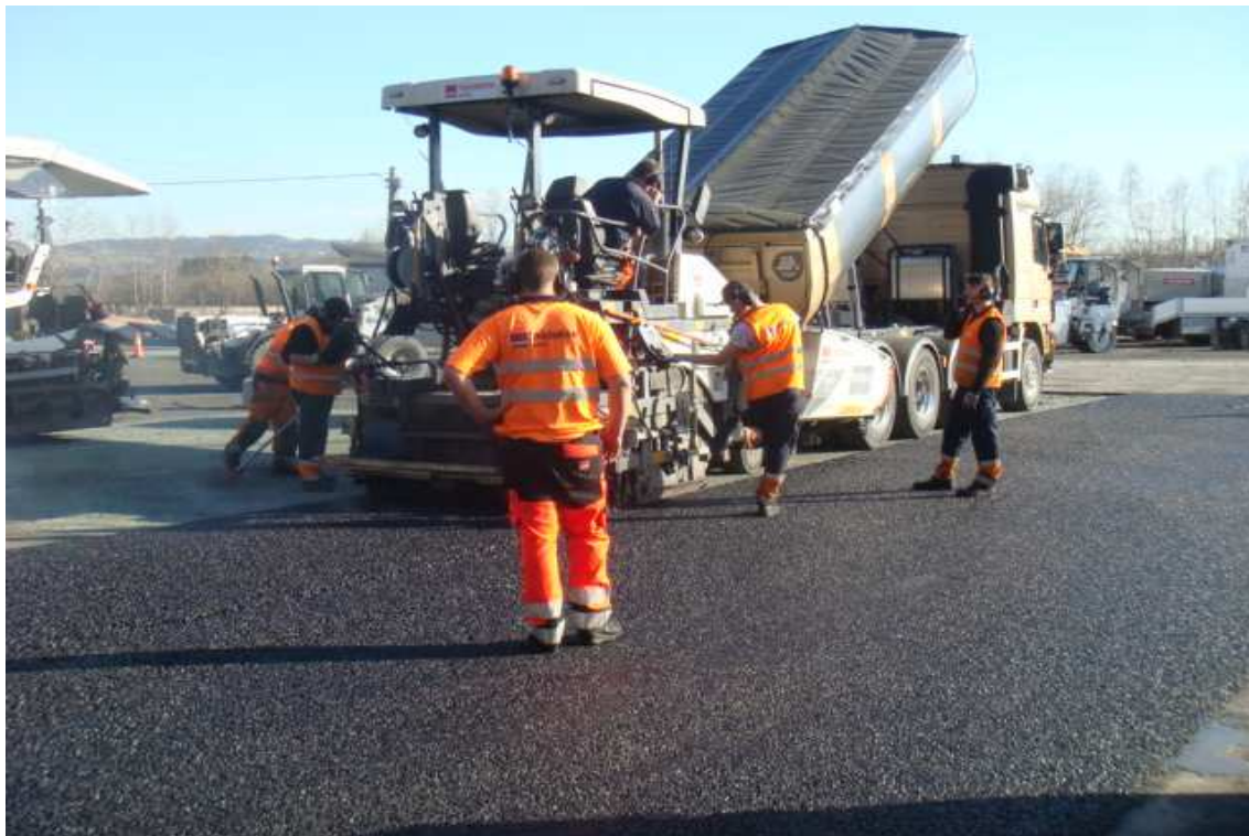
Bilde 44: Utlegging av asfalt på prøvefelt i Melhus
