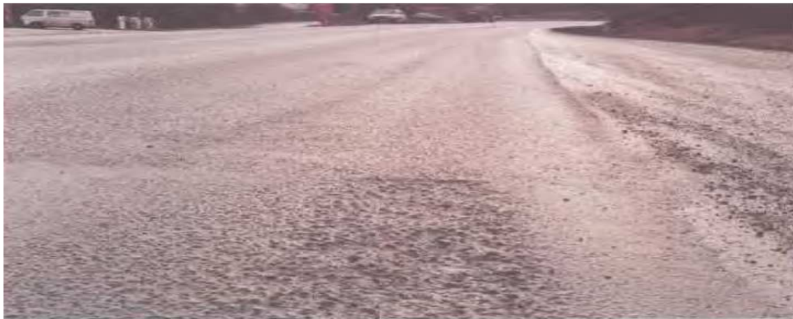
Bilde 15: Steinslipp på vegdekke
