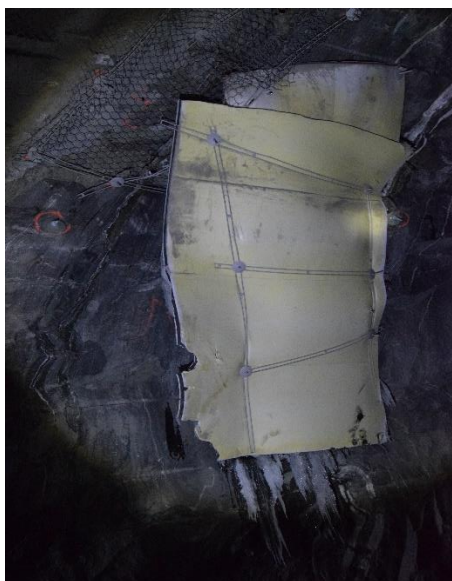
Figur 18 PE-skum, midlertidig vann og frostsikring under pågående arbeid.
