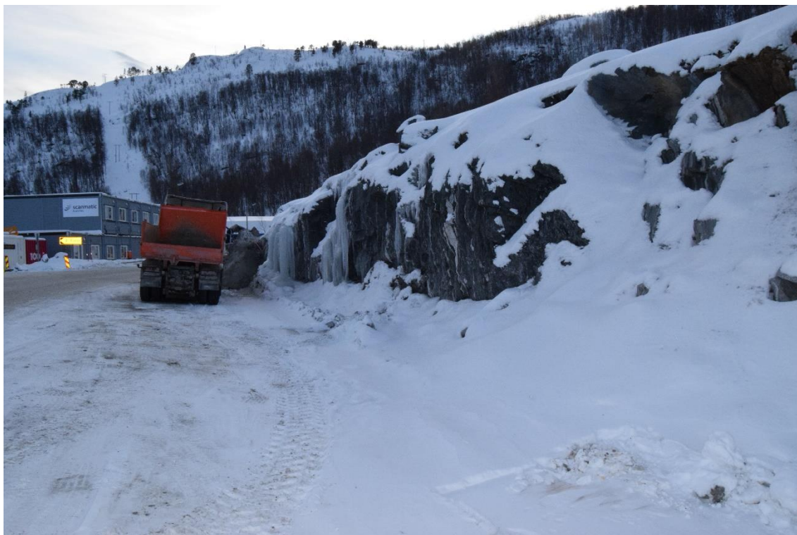
Figur 10, Brakkerigg og skjæring øst for tunnelen.
