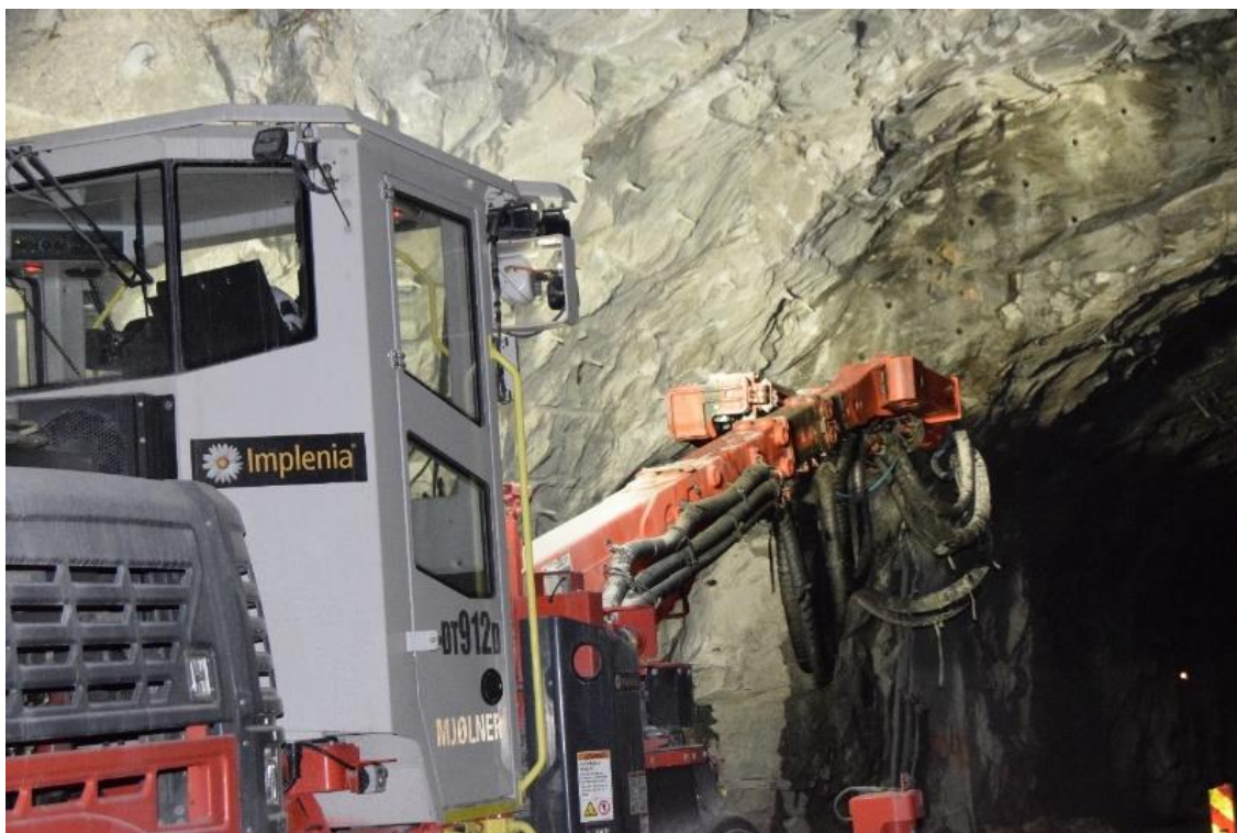
Figur 3 Boreriggen som ble benyttet, Sandvik DT912D
