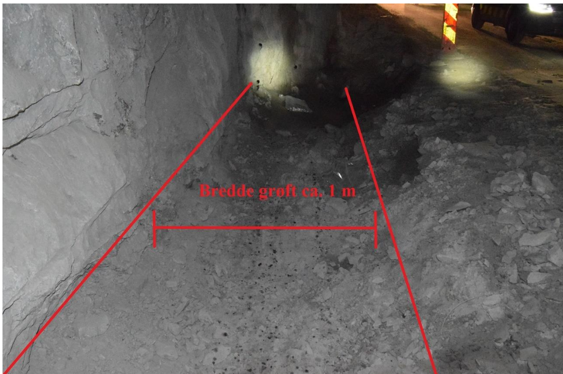
Figur 8 Gjenfylt dreneringsgrøft, bredde ca. 1 meter.
