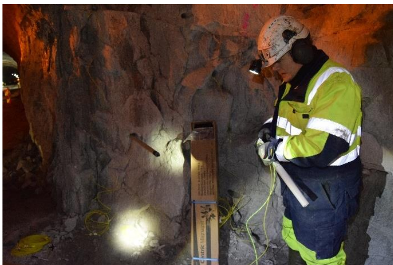
Figur 4, Bergsprenger lader salve nummer 175, 4/3-20, kl. 22:45
