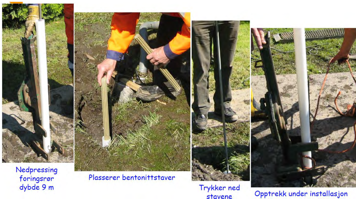
Figur 14–36 Tetting av lekkasje ved bruk av bentonittstaver (Foto: Knut Hagberg)
