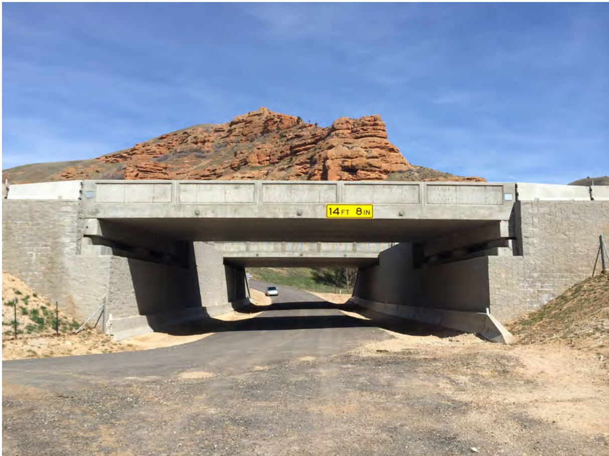
Figur 16–16 Jordarmert landkar fra Interstate 115, Echo Bridge, Utah (Foto: J. Vaslestad, Statens vegvesen)
