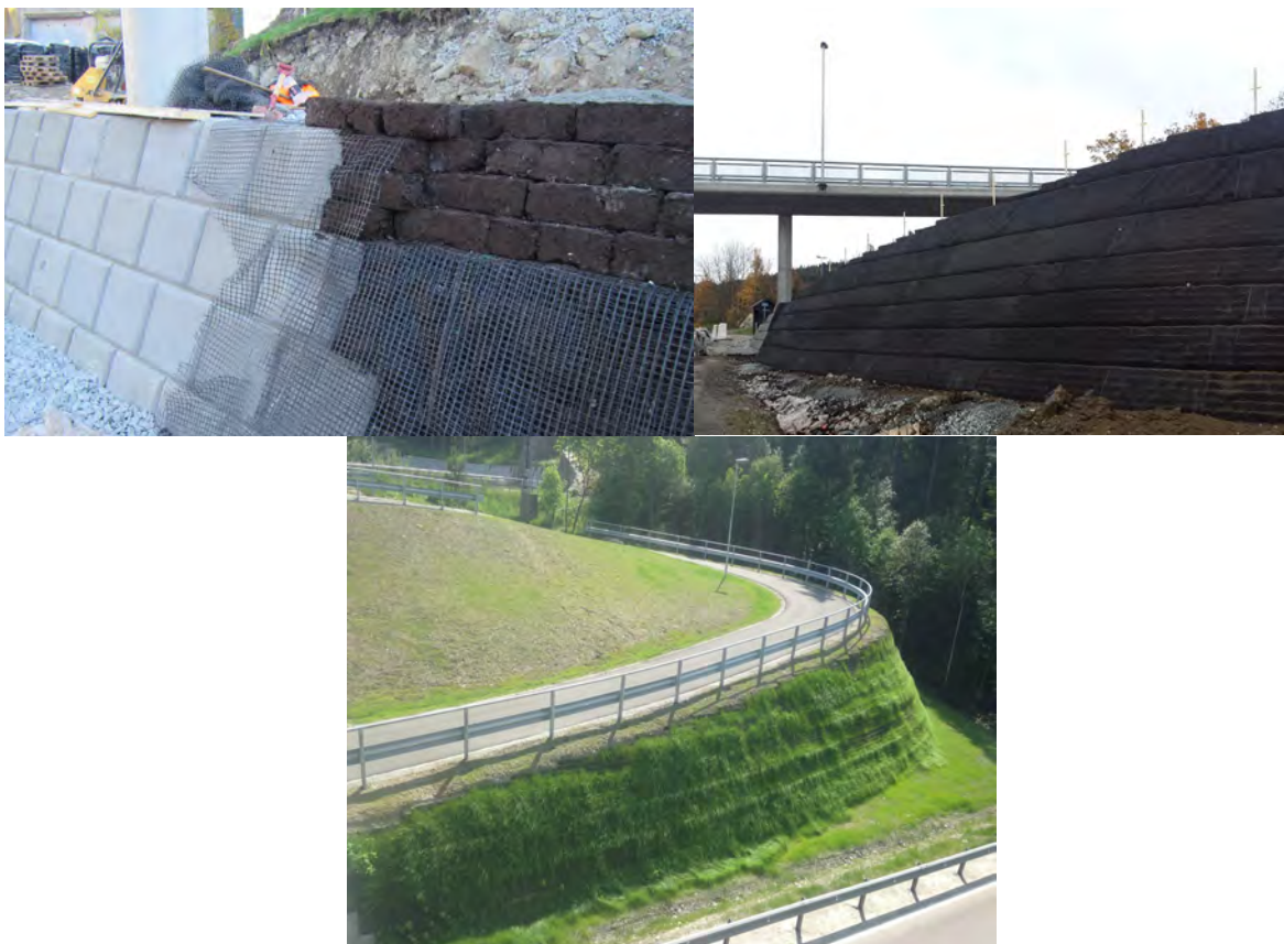
Figur 16–21 Bilder fra prosjektet E18 gang |– og sykkelveg ved Nygårdskrysset (Kilde: Statens Vegvesen, 2016)
