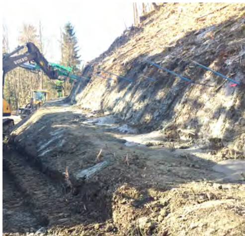
Figur 16–30 Montering av jordnagler ved Bårlidalen, Eidsvoll (Foto: J. Vaslestad, 2017)
