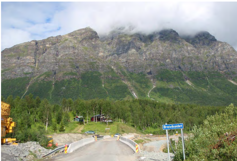
Figur 14–27 Breivikeidet Foto: Frode Oset, Statens vegvesen
