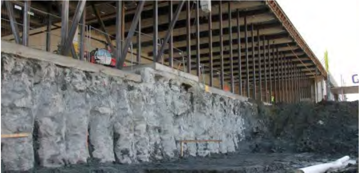
Figur 10-11 Eksempel på bruk av jetpeler til etablering av støttevegg og fundament. Foto: Jetgrunn
