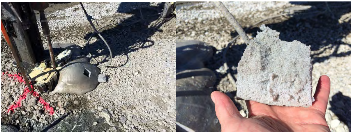
Figur 14-38 Injisering med polyuretan
