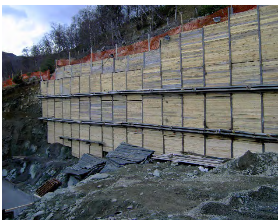
Figur 10-7 Bjelkestengsel (Berlinervegg). Venstre foto: Fundamentering AS Høyre foto: Arne Kavli, Statens vegvesen (E16 Sandvika-Wøyen)
