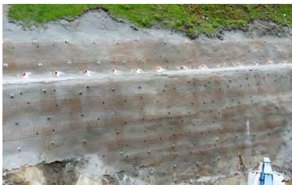
Figur 16–31 Permanent jordnagling ved Tysse, Samnanger. (Foto: FAS, 2014)
