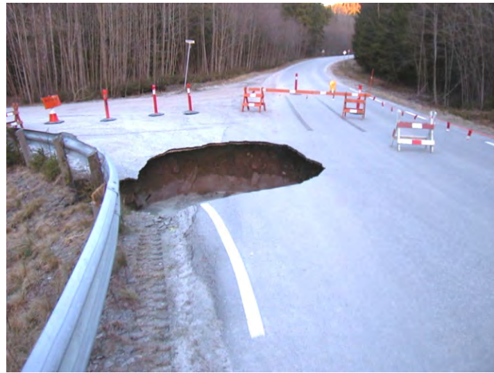
Figur 14–22 Bilde til venstre viser en sprekk i terrenget ovenfor en punktering med utvasking på Breivikeidet. Bilde til høyre viser utvasket vegbane etter endret artesiske trykk på Valebø, i Telemark (Foto: Elisabeth Gundersen og Bjørn K. Dolva, Statens vegvesen)
