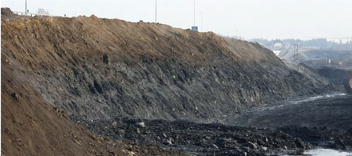
Figur 3–10 Bilde fra Løten som viser syredannende Mjøsmorene i en skjæring (Foto: Siri Guldseth, SVV)
