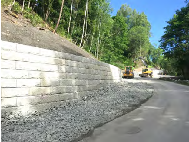
Figur 16–18 Ferdig frontkledning med betongblokker ved Bårlidalen, Eidsvoll (Foto: J. Vaslestad, Statens vegvesen)
