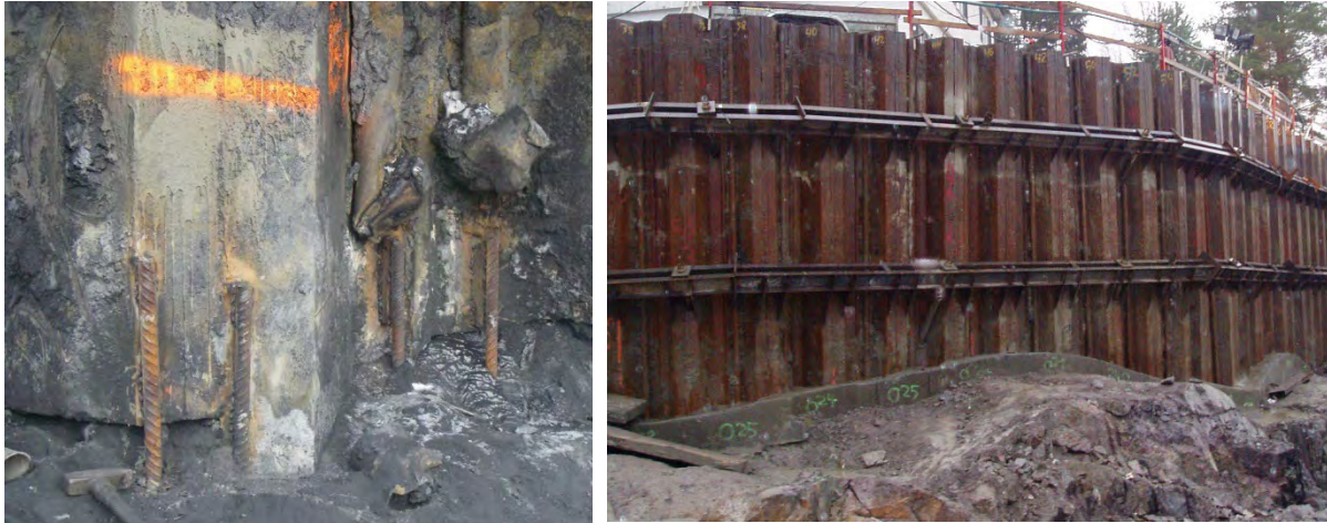
Figur 10–31 Eksempel på bruk av skråningsbolter (foringsrør for fotbolter ødelagte) og fotdrager (Foto venstre: Veslemøy Gardå, Statens vegvesen Foto høyre: Frode Oset, Statens vegvesen)
