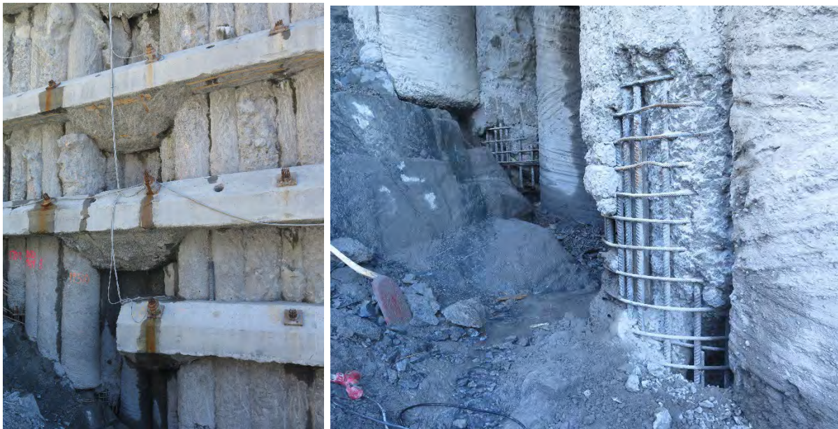
Figur 10–9 Eksempler på ulike utfordringer med sekantpeler. (Foto: Arne Kavli, Statens vegvesen)
