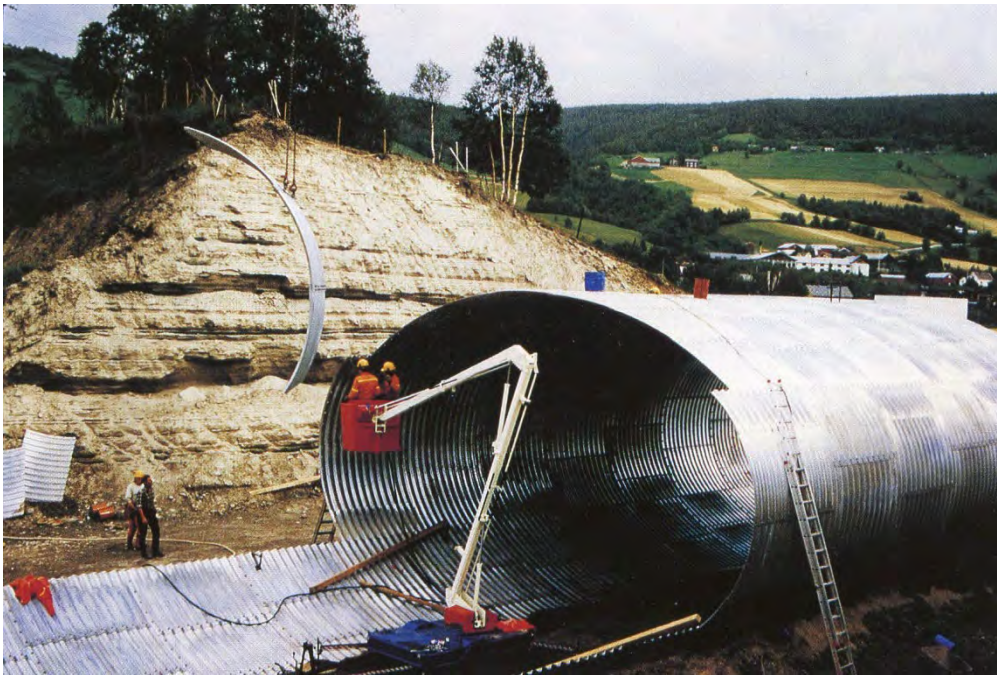
Figur 12-22 Formonterte plater heises på plass (Foto: Statens vegvesen)
