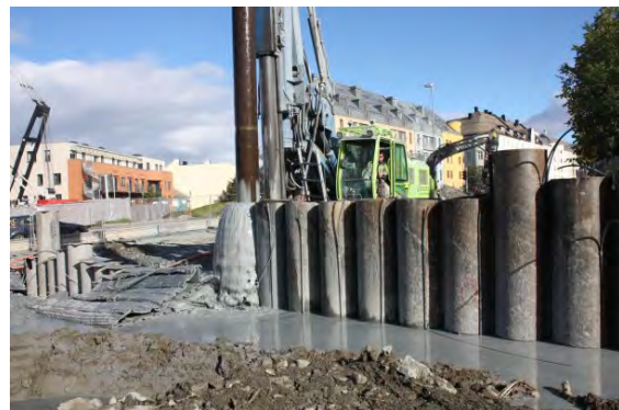
Figur 10-5 Rørspunt med låser. Figur: SSAB / Foto: Ellinor Hansen, Statens vegvesen
