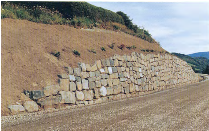
Figur 16–17 Ferdig frontkledning med naturstein, Vingrom kirke (Foto: J. Vaslestad, Statens vegvesen)
