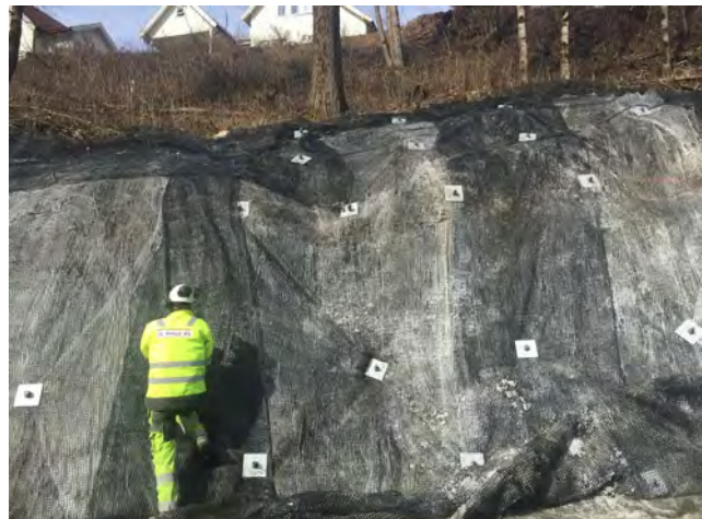
Figur 16–30 Montering av jordnagler ved Bårlidalen, Eidsvoll (Foto: J. Vaslestad, 2017)
