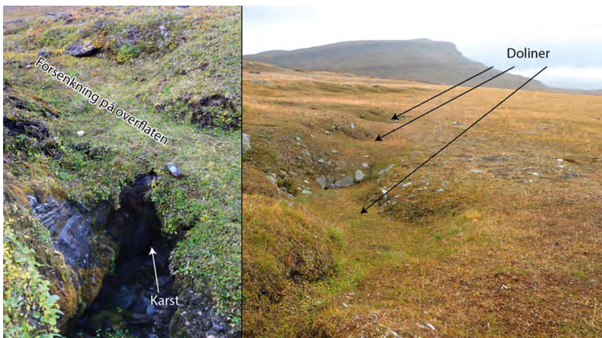
Figur 3–14 Venstre: karstberggrunn der terrenget over har sunket. Høyre: Løsmassedoliner er typiske tegn i overflaten på karstberggrunn. Foto venstre og høyre: Rannveig Ø. Skoglund, UiB.
