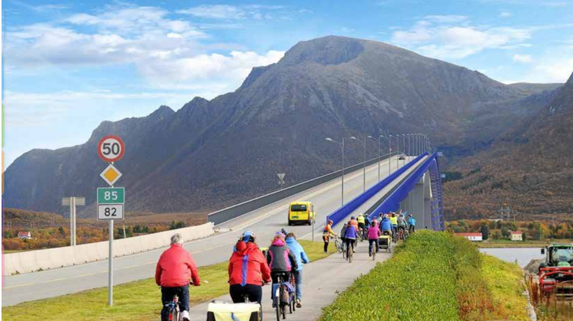
Figur 44 Sortlandsbrua. Nytt gang-sykkelfelt er manipulert inn på brua
