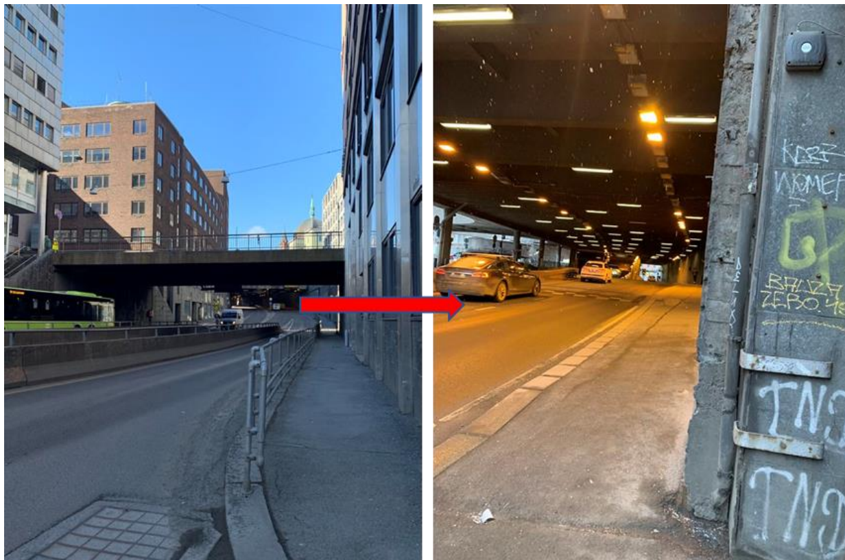
Figur 13. Hammersborgtunnelen på Ring 1 i Oslo har eit høgbrekk. Tunnelen skal difor senkast ned 7–8 meter i alunskifer i forhold til dagens nivå. Foto: Cecilie Hallingstad.
