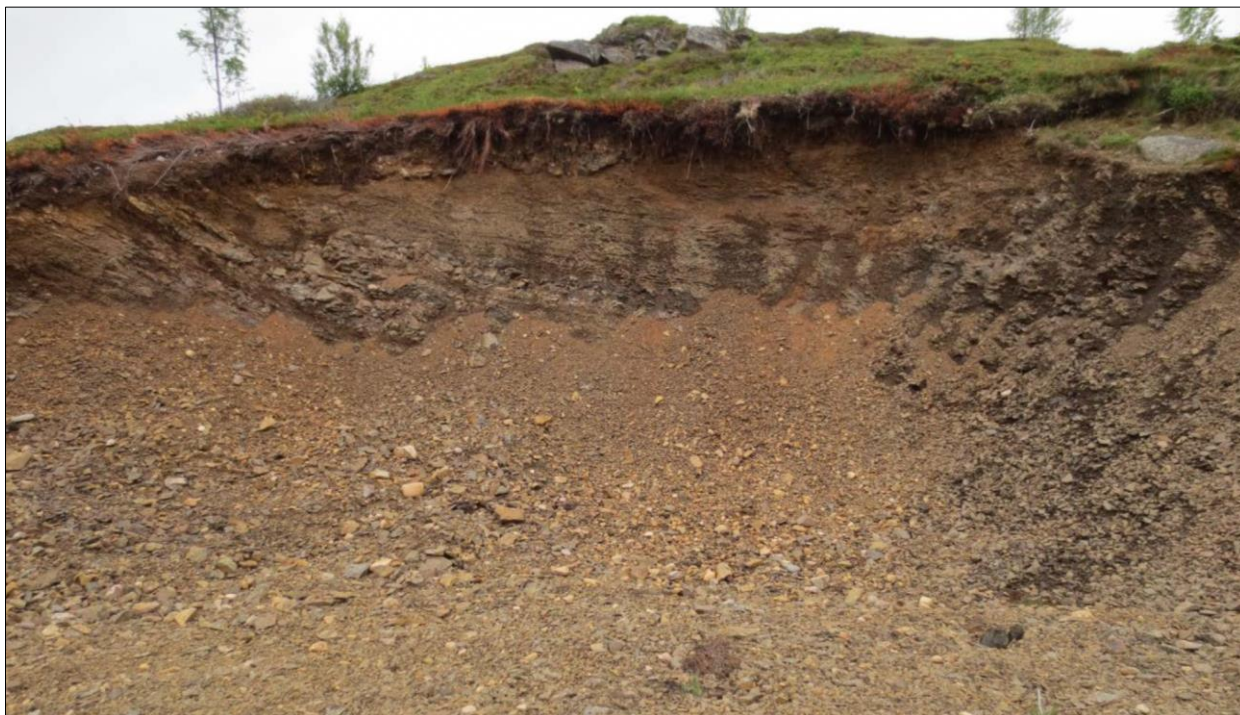
Figur 18. Lokalitet med djupforvittra berg på Bjarkøya. Grunneigaren har tatt ut grus til lokal vegbygging. Lokaliteten er mellom Bh5 og Bh6 på figur 19.
