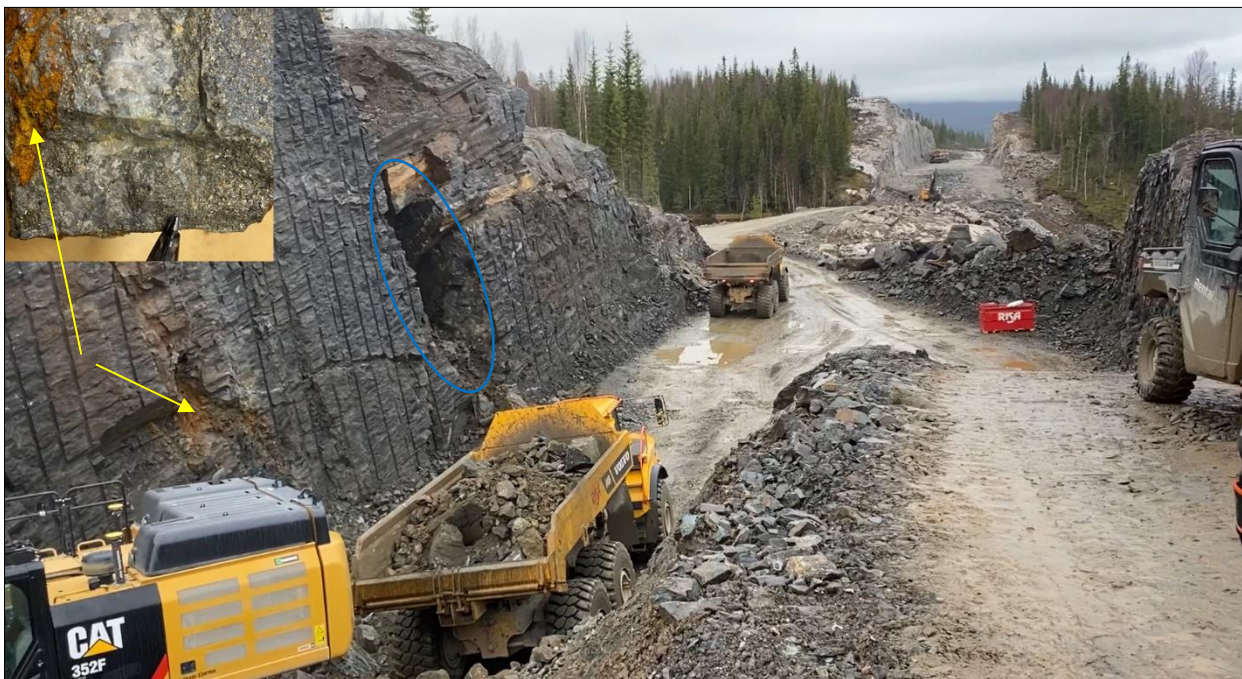
Figur 10: Bergskjering 2 sett nordover. Gruvegang i blå ellipse. Innfelt bilete vis handstuff med kvartsåre og sølvmalmar. NB raudoransje forvittringsmateriale i bergvegg og stuff. Foto Statens vegvesen.
