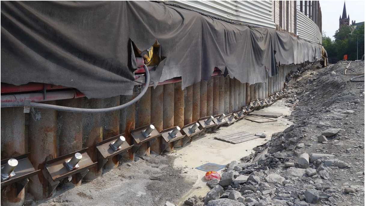
Figur 24: Permanente stag i fot
