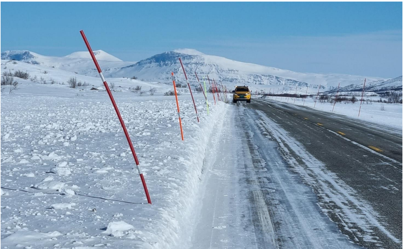
Figur 15: Fluoriserende stikk sammen med ordinære på Saltfjellet. Bildet tatt først i april 2022.
