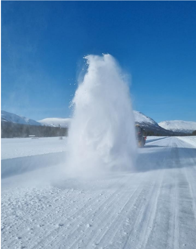
Figur 43: Fresing av snø fra kant og inn på flystripa.
