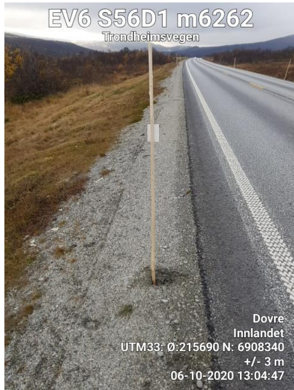
Figur 15: Refleks som har løsnet
