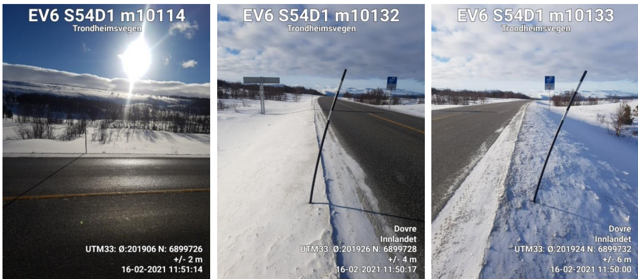
Figur 78: E6 Dovrefjell ved Fokstua i februar 2021. Stikker som krummer kraftig som følge av solinnstrålingen.
