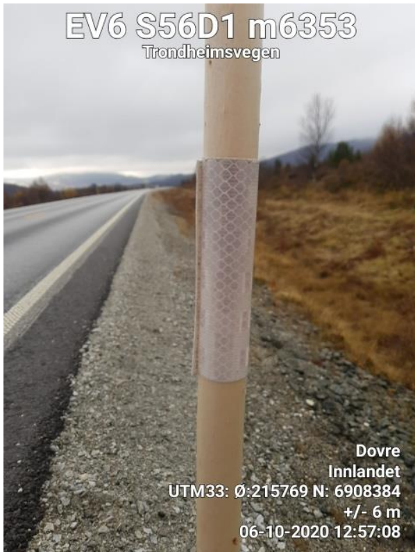
Figur 14: Refleks på tur til å løsne
