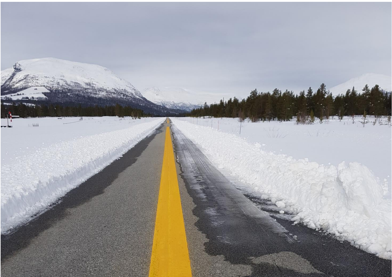
Figur 65: Snøforhold/situasjon ved oppstart/første belastning brøyting (1. brøyting) belastningstest 2.
