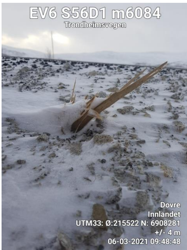
Figur 57: Rest i vegskulder av knekt pil (t.v.) og resirkulert plast (t.h.) E6 Dovrefjell
