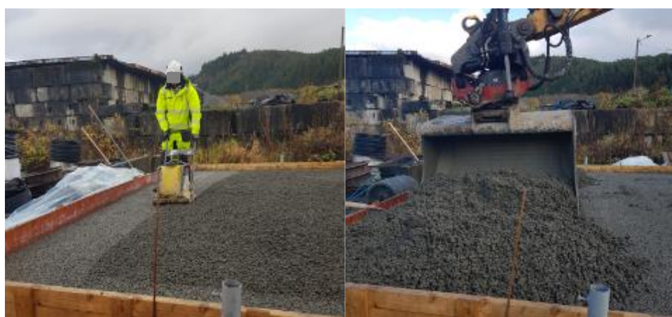
Figur 4-5: Viser komprimeringsoverført med vibrasjonsplate 70 kg og utlegging med gravemaskin.
