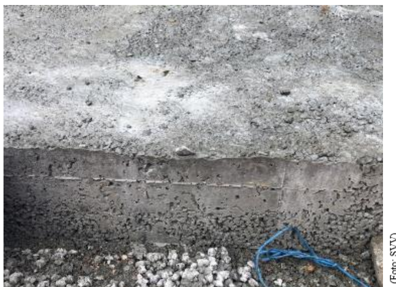
Figur 5-6: Bildet av drensbetong utsatt for mye regn ved utlegging og komprimering.
