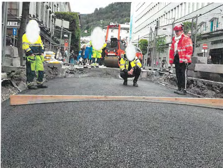
Figur 2.6 Bilde fra ferdig komprimert drensasfalt bærelag i Felt i ved testfelt Olav Kyrres gate. Foto: SVV.
