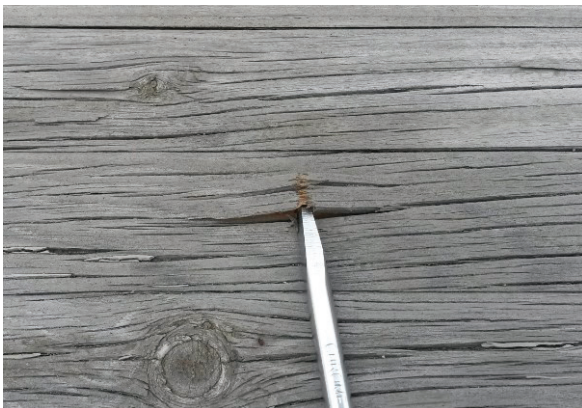
Figur V1-17 Brudd over sylen som antyder nedbrutt tre
