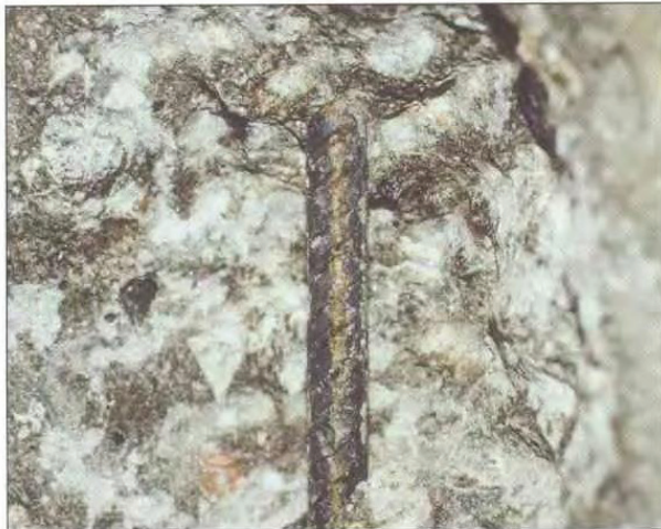
Figur V1-10 Eksempel på rustgrad B
