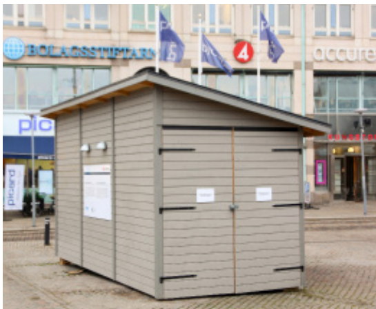
Bilde 9: Mikroterminal i kamouflert container, Gøteborg. Foto: Norconsult
