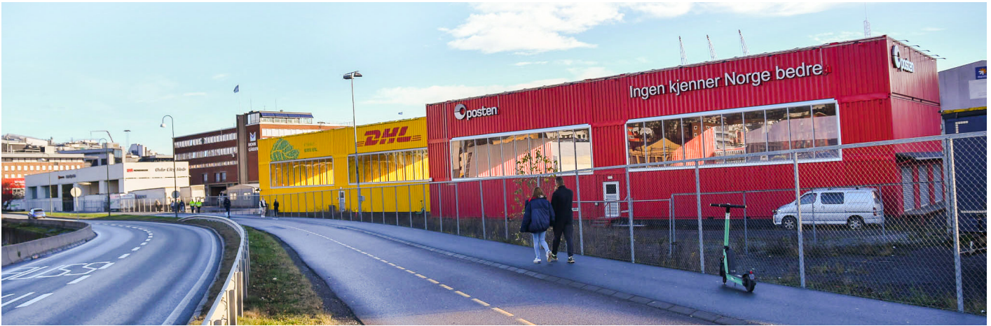
Bilde 15: Bildet viser de tre terminalene på Filipstad, sett fra sykkelveien langs E 18 mot sentrum. Schenker sitt terminalbygg er hvitt, DHL sitt er gult og Posten sitt er rødt. Foto: Helge Høifødt
