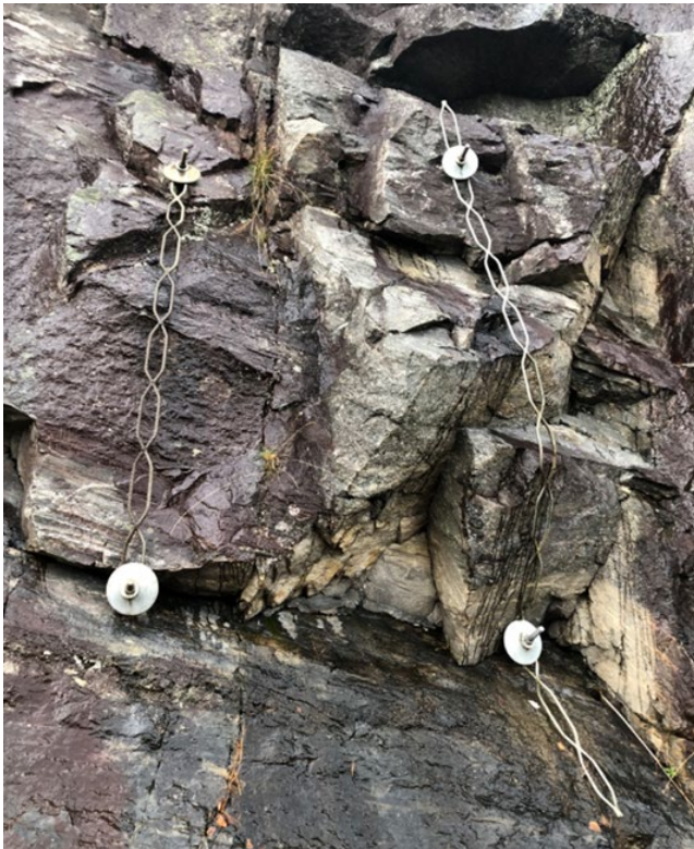
Figur 5.5 Sikring av ustabile blokker med bergbånd. Foto: T. Kirkeby.
