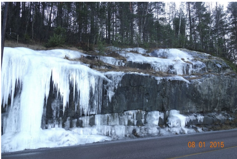
Figur 3.6 Langs gamle Fv 87 ved Kongsberg. Iskjøving grunnet vann både fra overliggende terreng og fra bergsprekker. Foto: T. Kirkeby.
