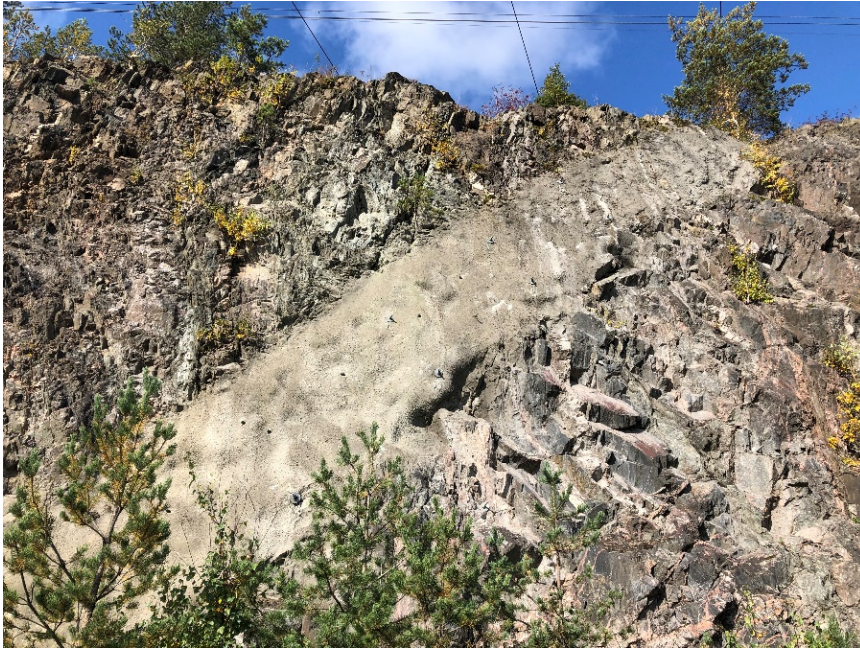
Figur 5.6 E6 i Oslo. Bergskjæring med halvmeter tykk svakhetszone skjult bak sprøytebetong. Betongen har holdt i over 25 år og effektivt stanset erosjon og utvasking langs sonen. Foto: T. Kirkeby.
