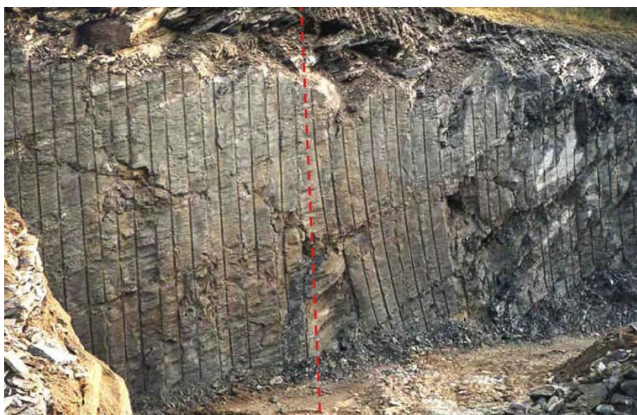
Figur 6.5 Eksempel på boravvik. Forskjell på boring med og uten styrestang. Avbøyningen mot høyre skyldes sannsynligvis gneisfoliasjonens slake fall mot venstre. Kilde: Sandvik.
