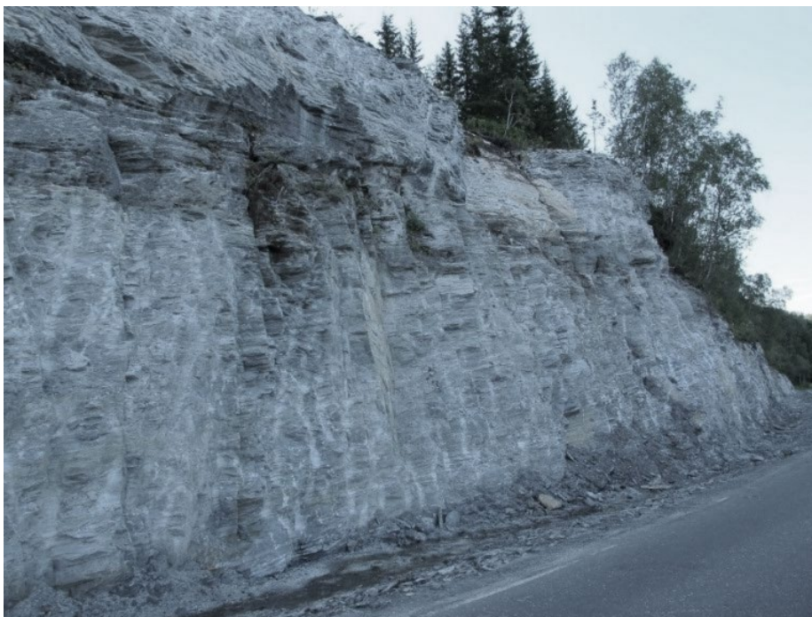
Figur 4.13 Fv. 826 i Nordland. Breddeutvidelse av bergskjæring er utført med hydraulisk hammer. Bergart er marmor. Foto: V. Aronsen.
