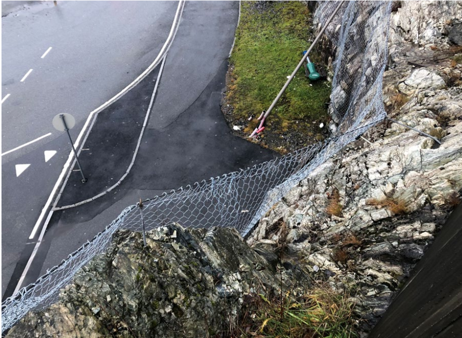
Figur 5.4 Steinsprangnett i Fanavegen i Bergen. Her er øverste kant av nettet hevet for å kunne fange opp stein som kan rulle ned fra terrenget ovenfor. Foto: T. Kirkeby.
