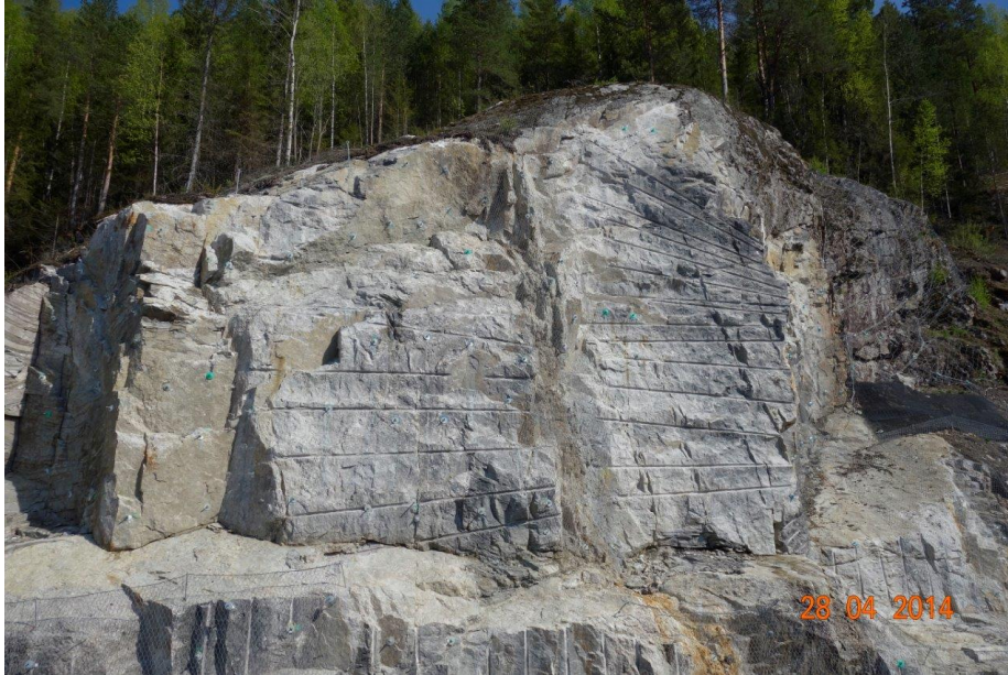
Figur 4.12 Rv. 7 Ørgenvika. Vifteboring på øverste pall. Foto: T. Kirkeby.
