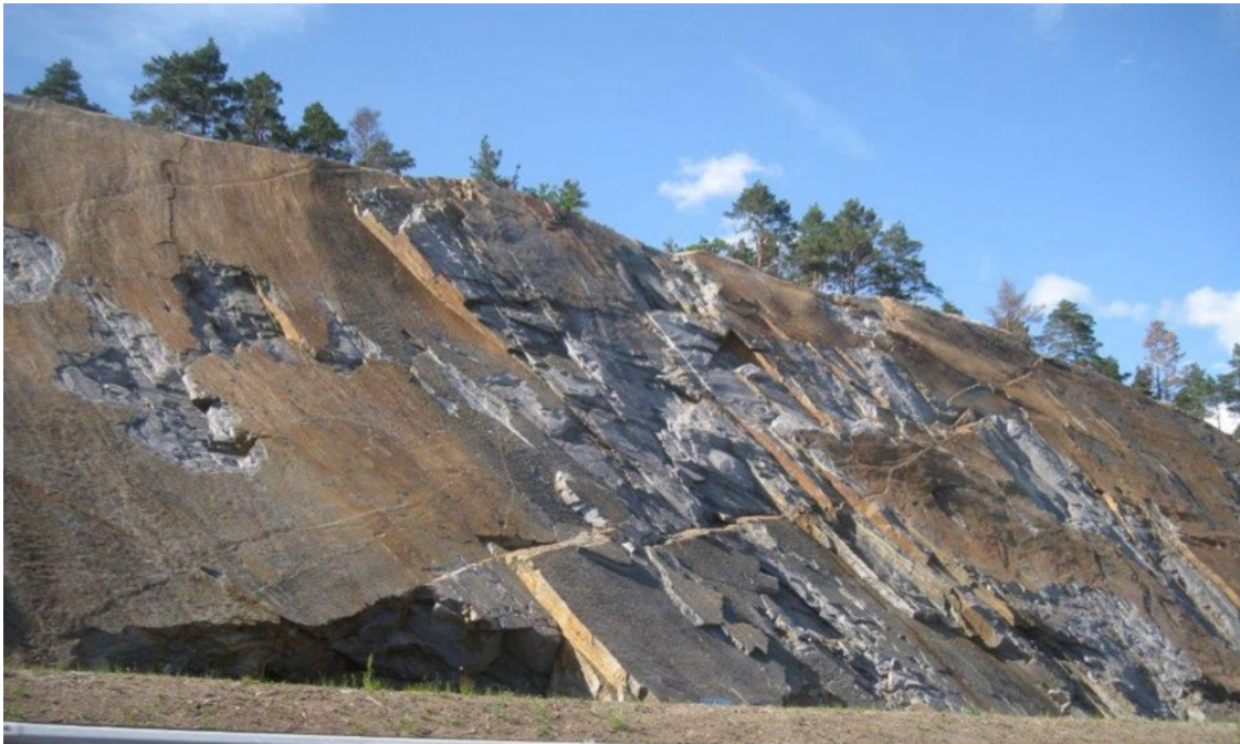
Figur 3.1 E18 ved Lillesand. Skjæringsvegg langs geologiske strukturer og bruddplan gir bedre stabilitet. Bergskjæringen er her permanent stabilisert ved å legge skjæringsvinkelen etter de dominerende sprekkene. Eventuell bergsikring blir minimal. Foto: T. Kirkeby.
