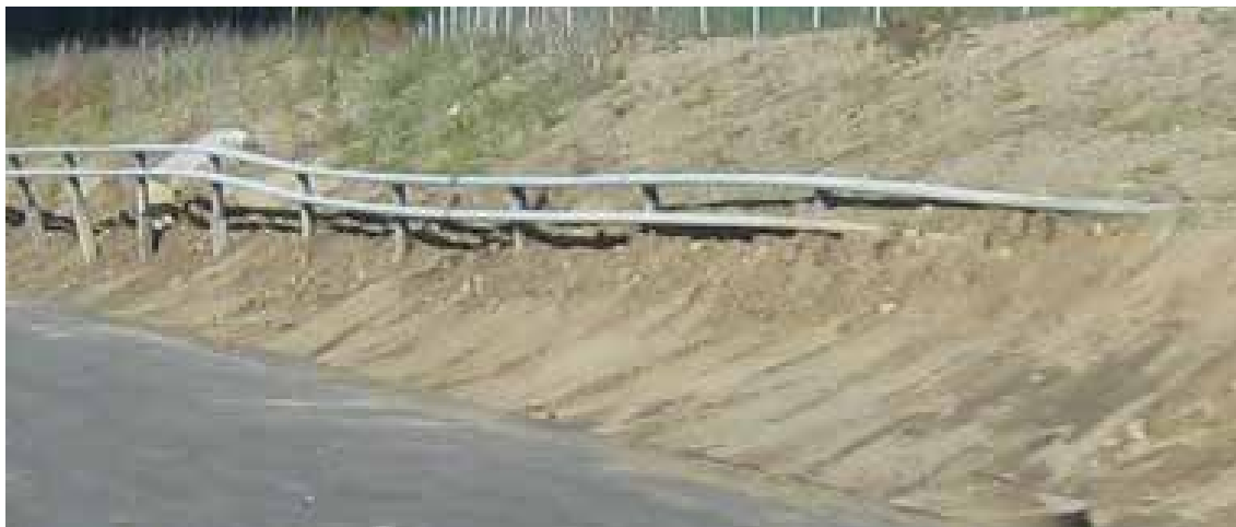
Figur 3.3: Eksempel på dårlig vertikal linjeføring
