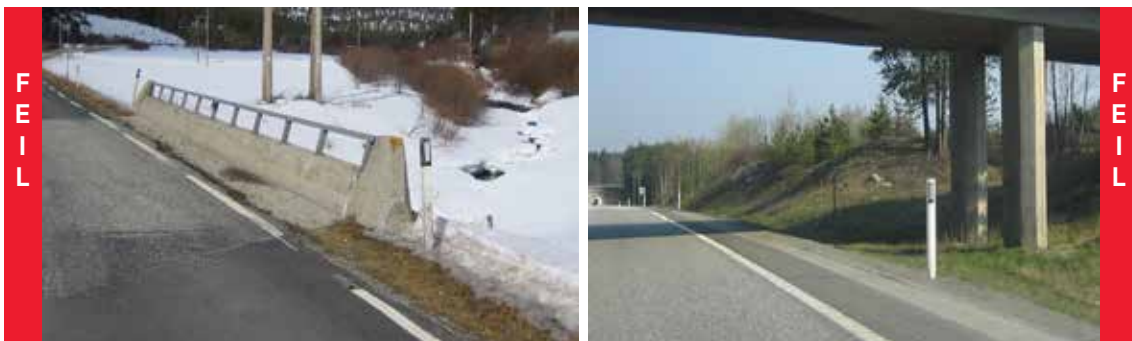
Figur 2.21: Eksempler på påkjørselsfarlige faste sidehindre med rekkverksbehov
