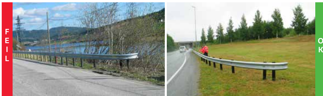
Figur 4.7: Eksempel på feil (venstre) og riktig (høyre) montering av ikke-energiabsorberende rekkverksende. Venstre foto viser en rekkverksende som slipper kjøretøyet forbi til et sideterreng som utgjør en sikkerhetsrisiko.
