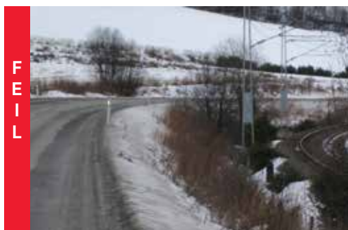
Figur 2.35: Eksempel på rekkverksbehov ved jernbane. Kontaktledningsmastene er innenfor sikkerhetssonen.
