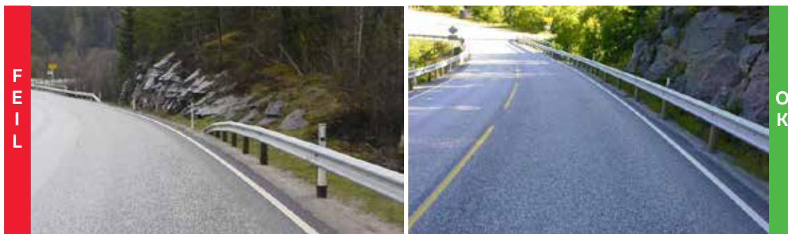
Figur 3.26: Eksempel på utbedring til sammenhengende rekkverk. Rekkverket på foto til venstre har avslutninger med nedføring med mindre innbyrdes avstand enn 100 meter og farlige sidehindre.
