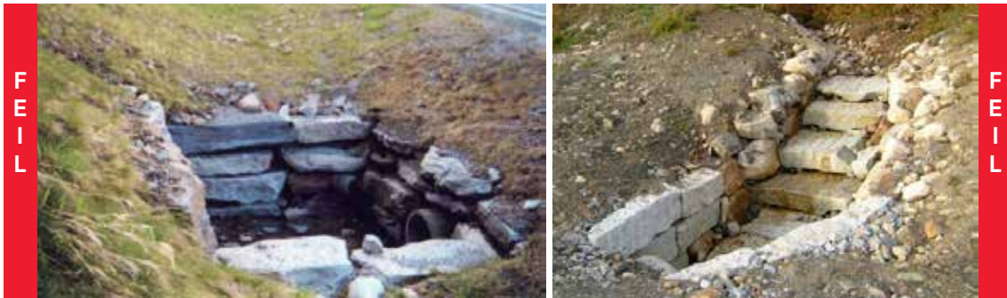
Figur 2.23: Eksempler på påkjørselsfarlige stikkrenneinnløp med rekkverksbehov
