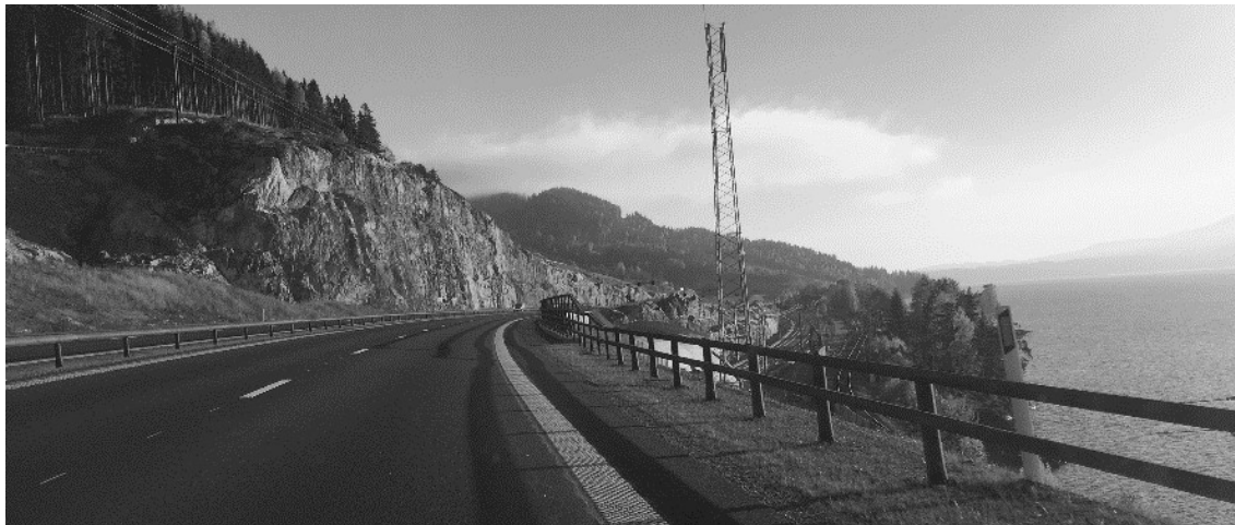
Figur 3.2: Eksempel på rekkverk som er relativt transparent
