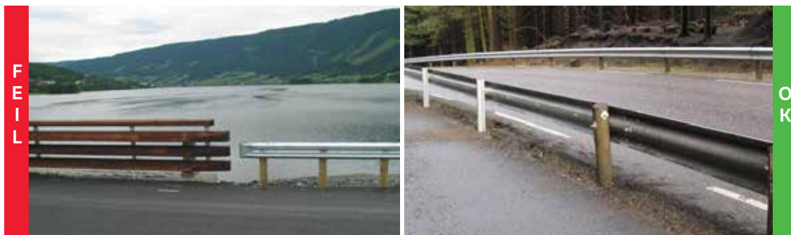
Figur 5.4: Eksempel på endring i rekkverkstype uten og med overgang 1
