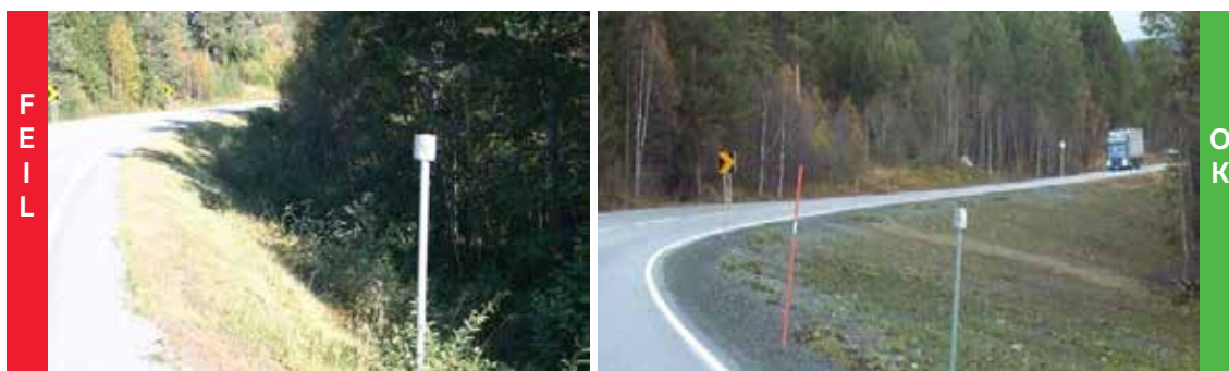
Figur 2.19: Eksempel på vegetasjonsrydding og utslaking av sideterreng
