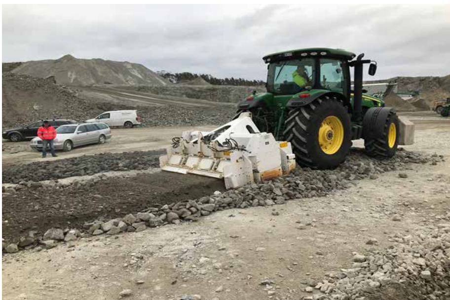
Figur B8.1 Knusefresing av sprengt stein. (Foto: Per Otto Aursand, Statens vegvesen).
