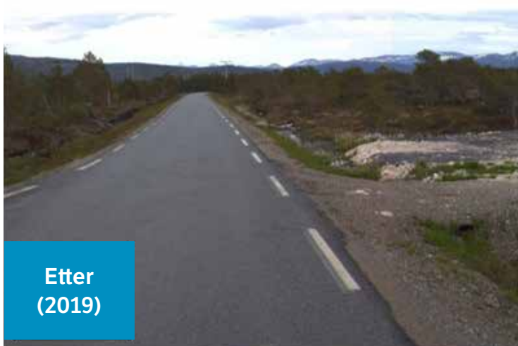
Figur B17.3 Veg over myr kantforsterket med geonett i to lag etter prinsippet vist i figur B14.2 før og etter forsterkning. (Foto: Statens vegvesen).
