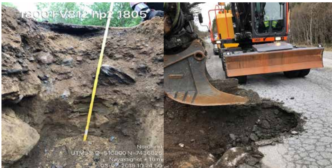
Figur A3.16 Oppgraving, prøvetaking og registrering av lagtykkelser. (Foto: Per Otto Aursand, Statens vegvesen)
