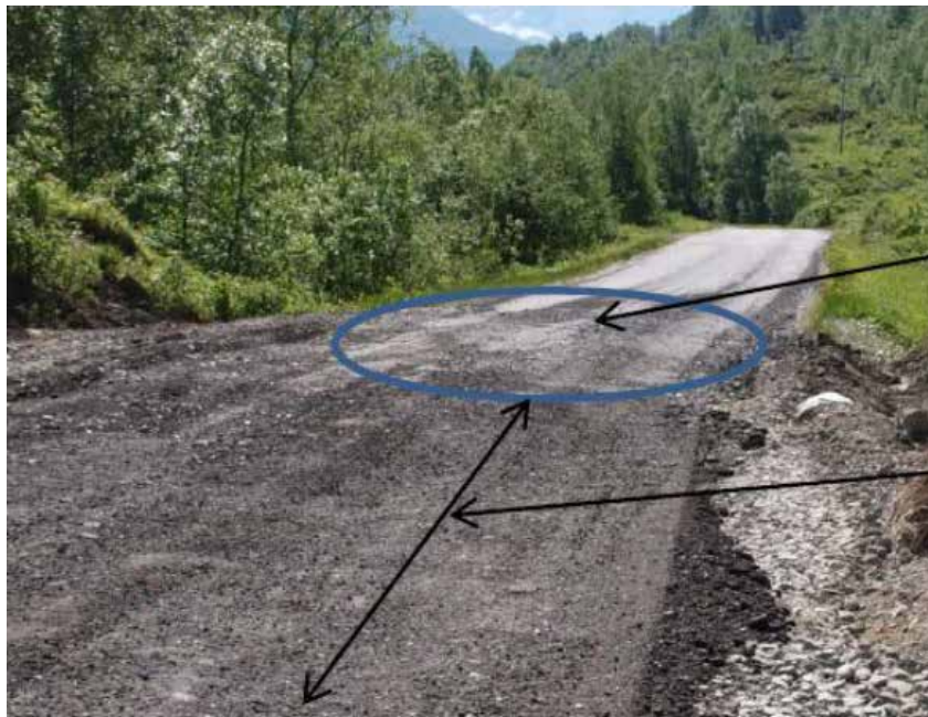
Figur B12.5 Utkiling med mulig problemområde. (Foto: Per Otto Aursand, Statens vegvesen).
