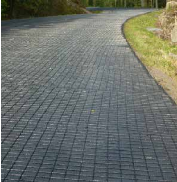
Figur B15.2 Eksempel på riktig legging av armeringsnett. (Foto: Statens vegvesen)
