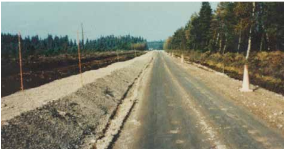
Figur A6.7 Forbelastning ved breddeutvidelse over myr. [19]
