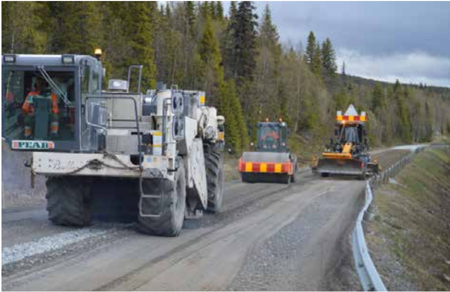
Figur B11.1 Tørrstabilisering. (Foto: Statens vegvesen)
