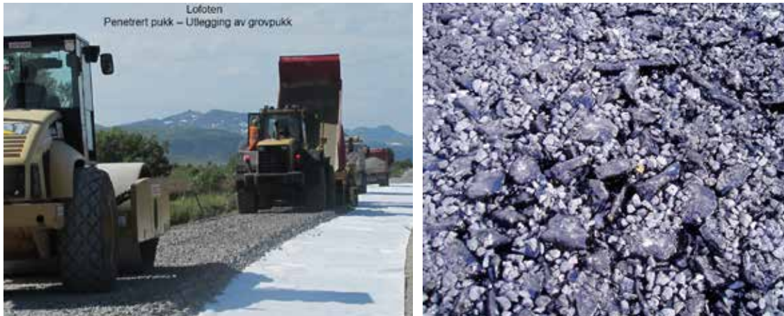
Figur B9.1 Utlegging av grovpukkk med pukkkutlegger. Riktig mengde forkilingsmateriale er viktig, ikke for mye og ikke for lite. (Foto: Kai Frode Solbakk, Statens vegvesen).
