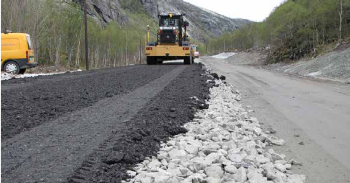
Figur B10.1 Utlegging av pukkk forkilt med knust asfalt. (Foto: Per Otto Aursand, Statens vegvesen).
