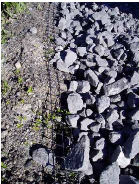
Figur B17.2 Geonett i samvirke med penetrert pukk. (Foto: Per Otto Aursand, Statens vegvesen)
