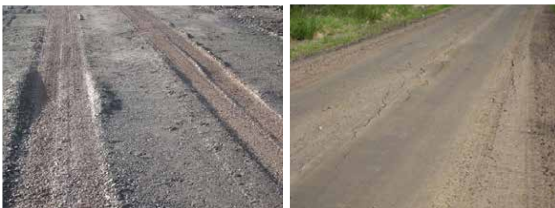
Figur A4.4 På en grusveg vil forskjellene på sportypene komme tydelig frem. Til venstre sportype 1 og til høyre sportype 2. [31]
