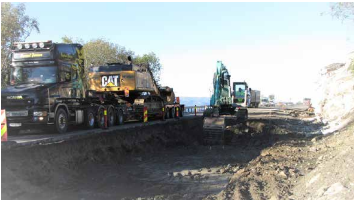
Figur B18.1 Masseutskifting på eksisterende veg. (foto: Statens vegvesen).
