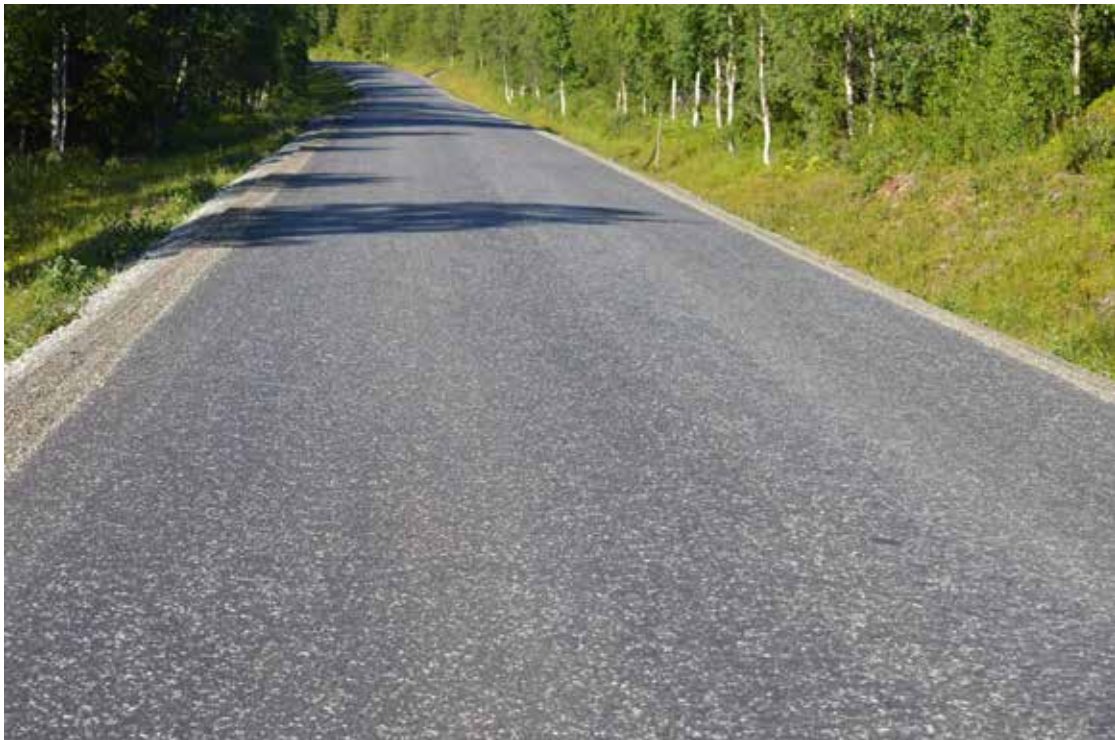
Figur B6.1 Vegdekke av gjenbruksasfalt, med 70 % fresemasse. (Foto: Statens vegvesen).
