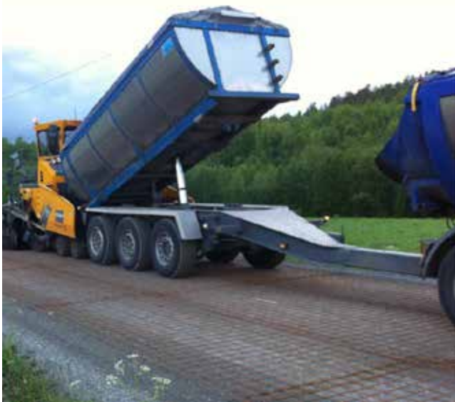
Figur B17.1 Legging av stålnett over bitumenstabilisert bærelag. (Foto: Statens vegvesen)
