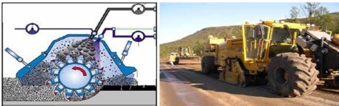
Figur B7.1 Ved stabilisering freses øvre del av eksisterende veg opp og homogeniseres med samtidig innsprøyting av nytt bindemiddel. (Illustrasjon: Wirtgen, foto: Statens vegvesen) [8]
