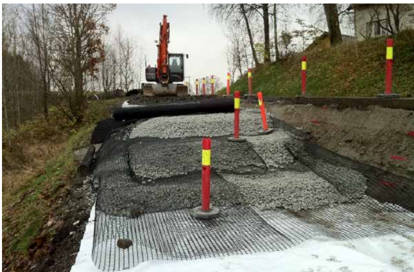
Figur B13.4 Utlagt skumglass med fiberduk og armeringsnett. (Foto: Jan Vaslestad) [12].
