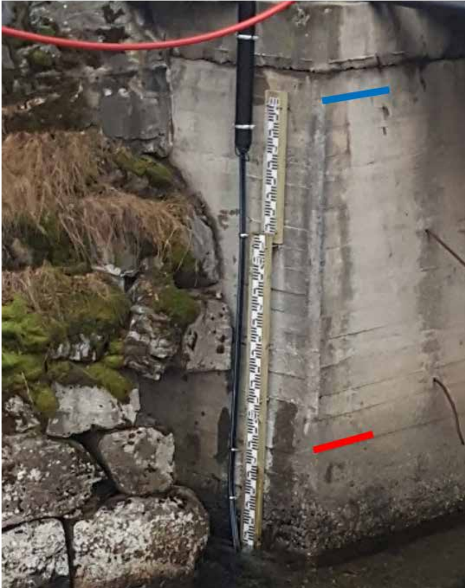
Figur 5.3.1.1: Målestav og avmerking ved innløp for avlesning av vanndybde (foto: NVE).
