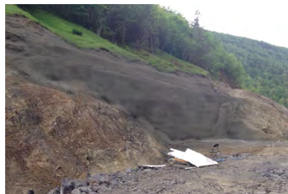
Figur 16–31 Permanent jordnagling ved Tysse, Samnanger. (Foto: FAS, 2014)
