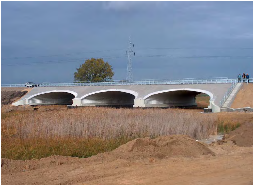
Figur 12-7 Konstruksjon med korrugeringsprofil 380 x 140 mm i stål med platetykkelse 7 mm, overdekning 1,2 m, byggeår 2005 (Polen). Foto: Jan Vaslestad, Statens vegvesen
