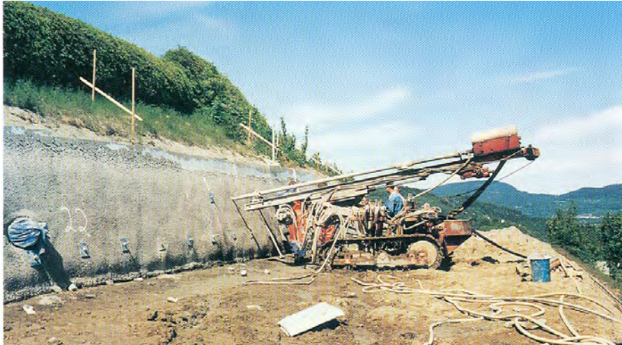
Figur 16–29 Montering av jordnagler ved Vingrom kirke i Oppland (SVV publikasjon nr. 99) [30]
