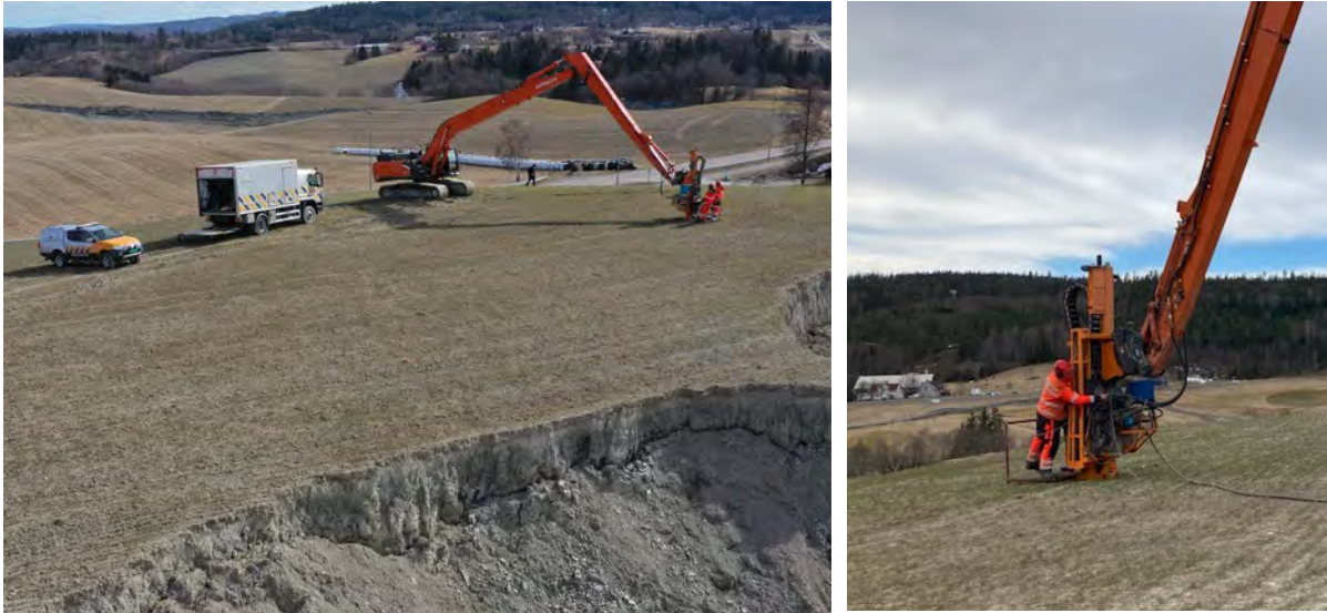
Figur 1–2 SVVs løse bortårn montert på gravemaskinen «Langemann» Foto: NVE
