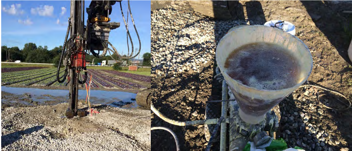
Figur 14-37 Injisering med polyuretan
