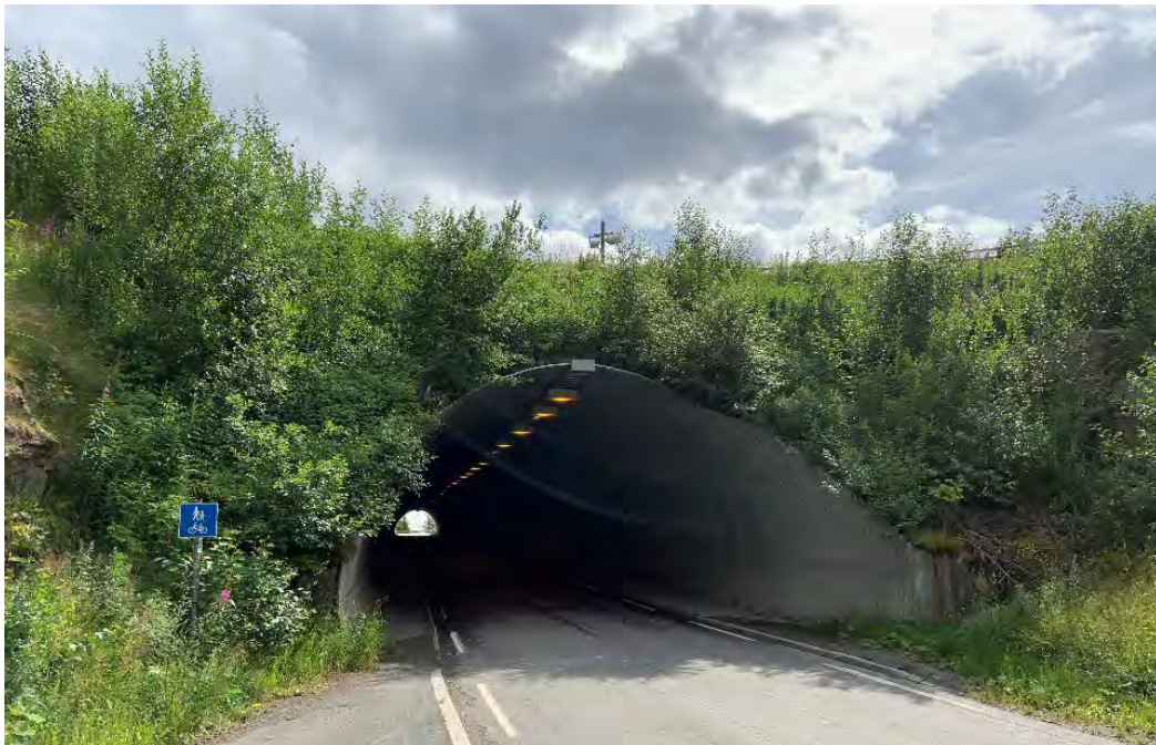
Figur 12-6 Stort korrugert stålrør brukt som veg-gjennomføring for Fv. 2560 under Hafjell alpínsenter (Foto: Veslemøy Gardå, Statens vegvesen)
