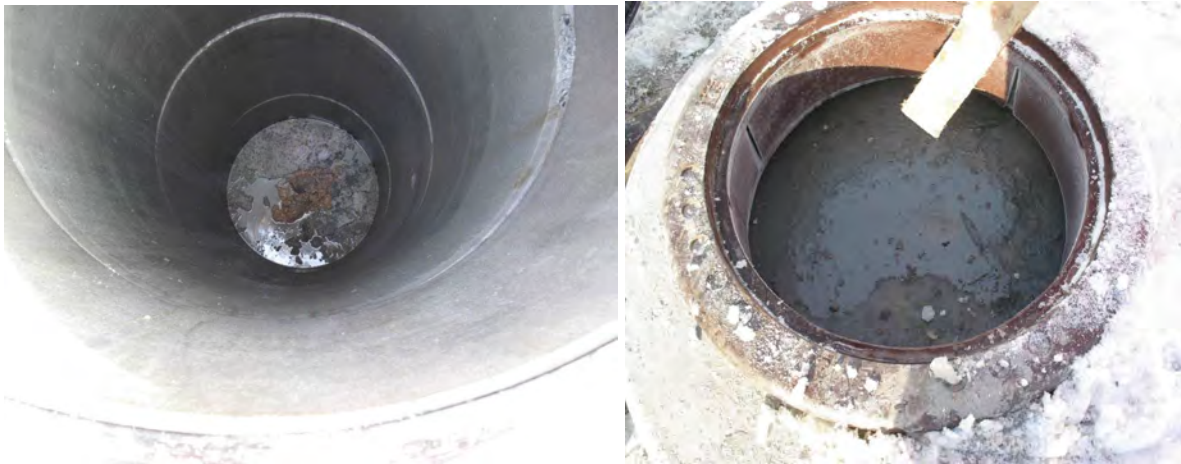
Figur 14–26 Oppfylling av kumringer på Breivikeidet. Foto: Knut Hagberg
