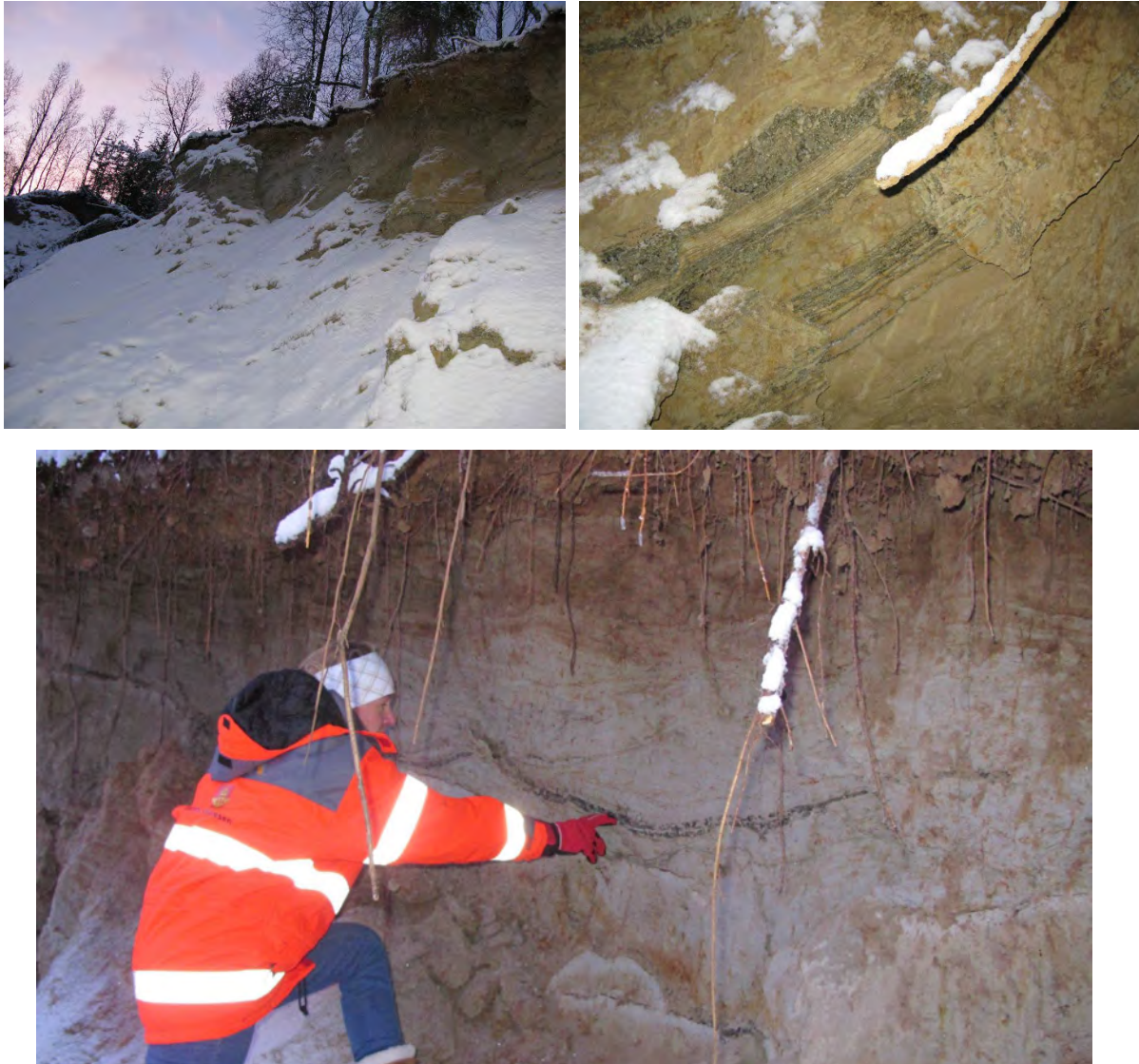
Figur 14–28 Skredkant ved elva Russevanka i Troms, ca. en km fra Breivikeidet. (Foto: Knut Hagberg)
