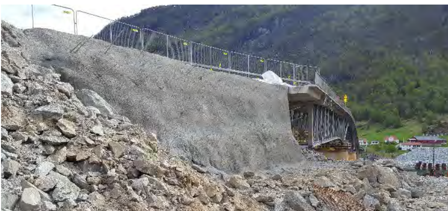
Figur 10–14 Skjæring inn i eksisterende trafikkert tilløpsfylling og landkar, Rv. 5 Loftesnes bru. (Foto: Arne Kavli, Statens vegvesen)
