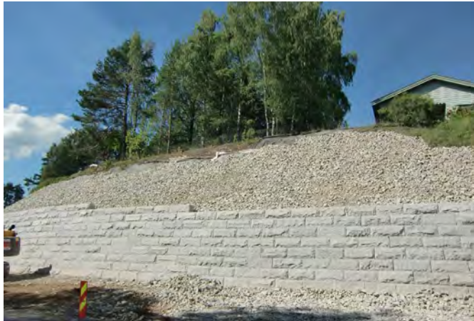
Figur 16–20 Bilde fra prosjektet FV 47 Byflaten–Børkevegen, Innlandet (Kilde: Statens Vegvesen, 2017)
