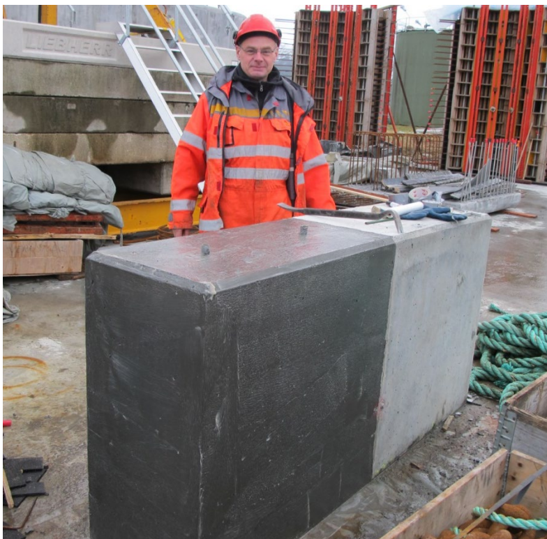
Figur 1 Stort element etter påføring av Stocryl HG 200 på halve elementet (foto: Eva Rodum, Statens vegvesen).
