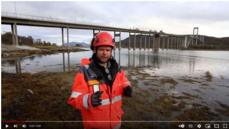
FIGUR 25 STILLBILDE FRA VIDEOEN OM REHABILITERINGSARBEIDENE PÅ TJELDSUNDBRUA I 2018. FOTO: TOMAS ROLLAND/GØRAN SOFIENLUND, STATENS VEGVESEN ( HTTPS://WWW.YOUTUBE.COM/WATCH?V=VOFmBRhtKCI )
