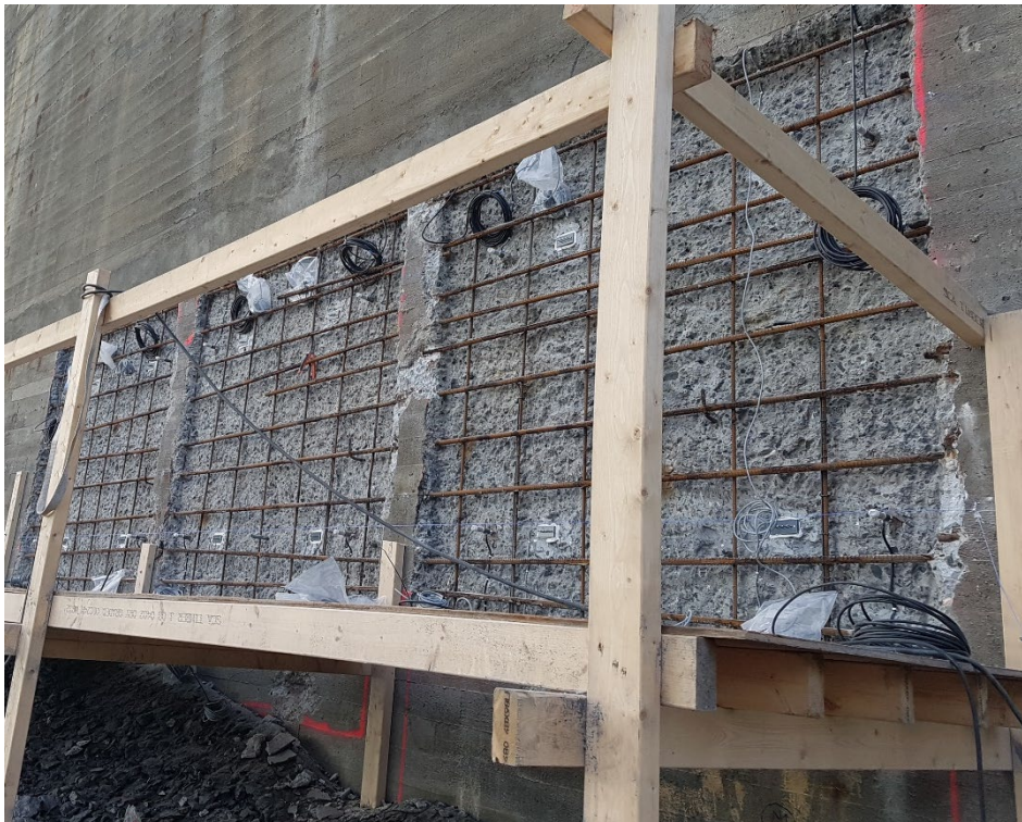
FIGUR 7 - ETABLERING AV PRØVEFELTENE VED TJELDSUNDBRUA. FOTO: KARLA HORNBOSTEL, STATENS VEGVESEN.
