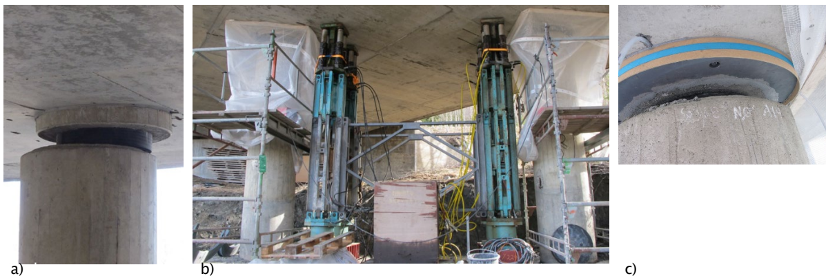
FIGUR 26. FIBORG BRU UNDER REHABILITERING. A) EKSPANSJON AV OVERBYGNINGEN HAR FØRT TIL FORSKYVNING AV SØYLEOPPLEGG. B) OPPJEKKING AV PLATE FOR FORSTERKNING AV SØYLEOPPLEGG OG MONTERING AV NY NEOPRENPLATE C) STØPING AV NYE, UTVIDEDE OPPLEGG FOR SØYLENE PÅ UNDERSIDE PLATE. FOTO: EVA RODUM, STATENS VEGVESEN
