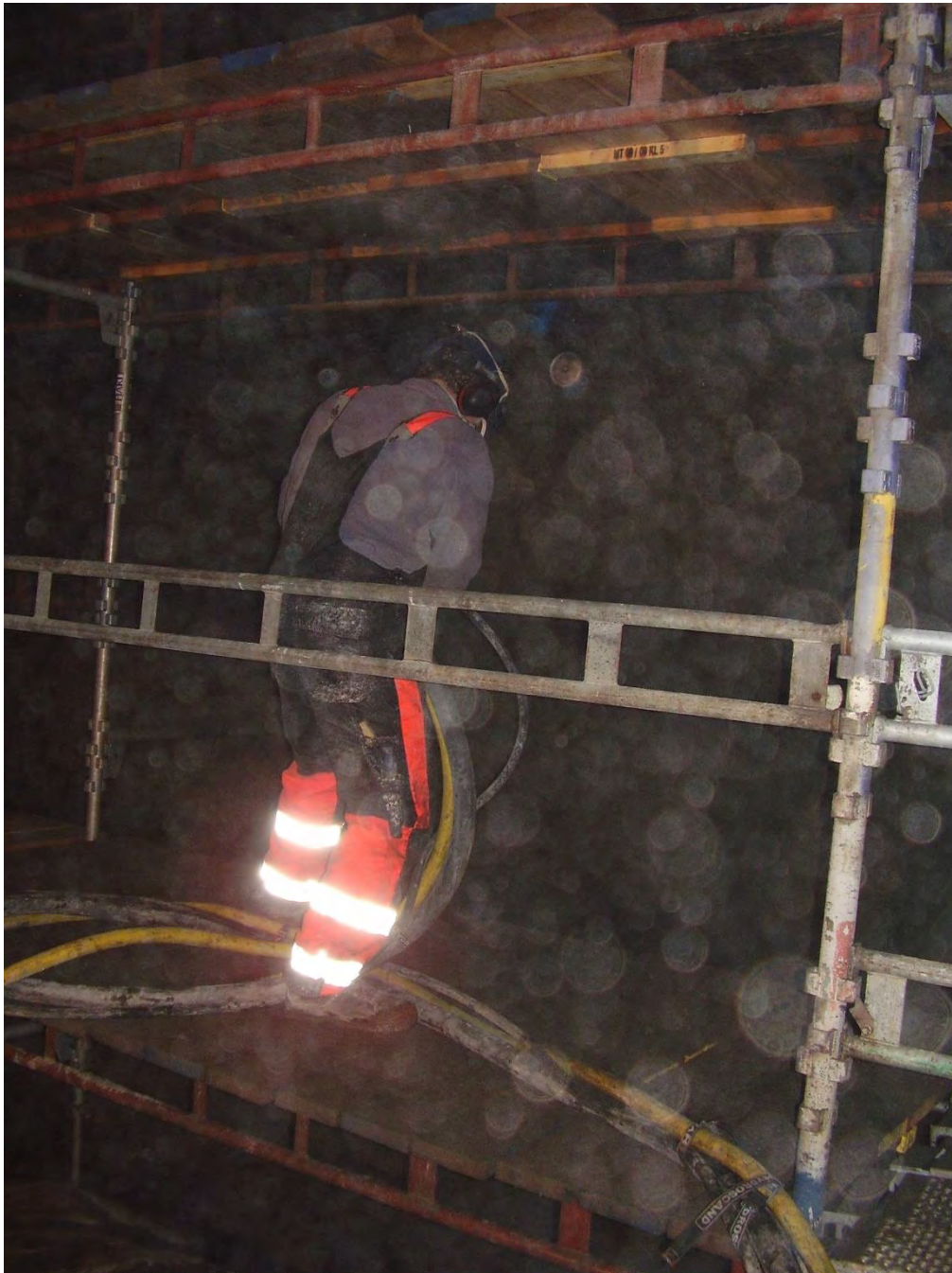
V4.1. Sprøyting av Felt 1, Felt 2 og Felt 3. Testfeltet blei etablert ved handsprøyting fordi det ikkje var plass til sprøyterobot. Foto: Reidar Kompen.
