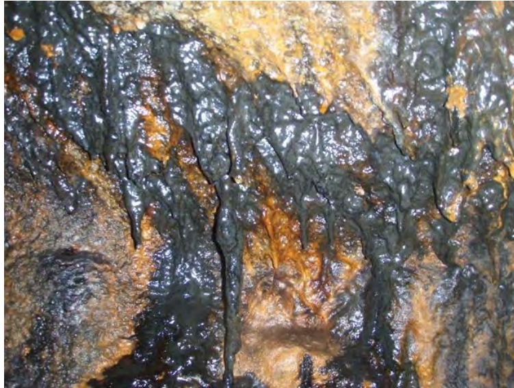
Figur 3: Tilstanden før etableringa av testfeltet (detalj). Sterk nedbryting av opphavleg sprøytebetong (M45, B45) med manganrik (mørk) og jernrik (brun) biofilm utanpå kalkstalaktittar. Betongalder 11 år. Foto: Per Hagelia.
