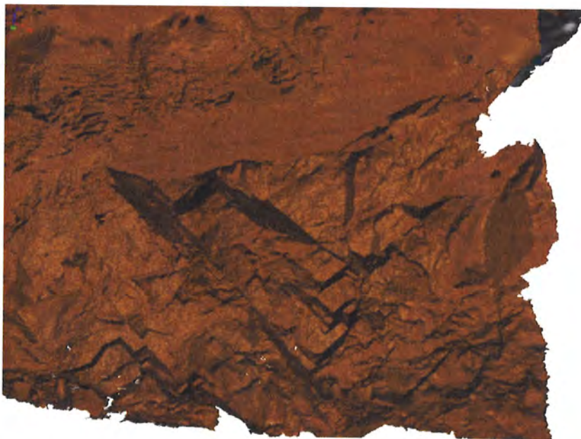
Figur 2.3: Forstørret utsnitt av seksjonen av sideveggen til venstre i figur 2.2, sett fra utsiden (speilvendt i forholdt til utsnittet i figur 2.1). Sprekkeplan og bergets karakter kommer godt frem.
