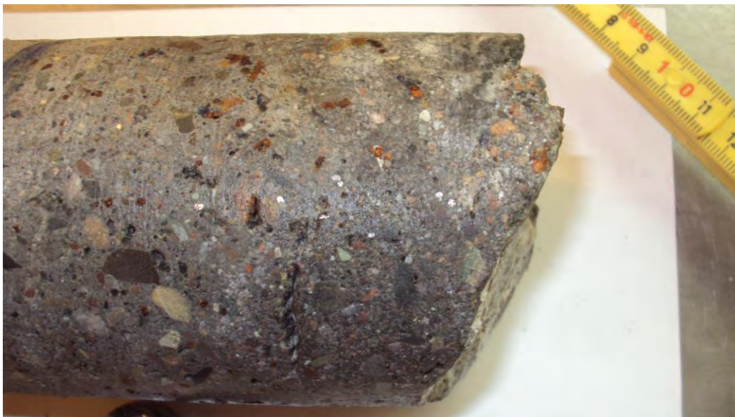
Figur 50: Felt 1, kjerne FB1-2 etter 5,5 års eksponering. Stålfiberen er intakt mot heftsona som har lys utfelling av Mg(OH)_2 og CaCO_3 . Fiberen begynner å korrodere etter eksponering i luft etter utboring og kjem til uttrykk som spreidde ytre rustutfellingar på overflata.
