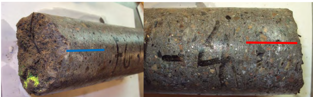
Figur 54: Felt 1 2015, kjerne FG1-4 (Lab nr 7A og 7B) viser svært lite fiberkorrosjon nær overflata (venstre bilde viser svart PP-fiber). Alle stålfibrar er intakte mot heftsona (høgre), trass i svært høgt kloridinnhald (> 1 %). Omtrentleg plassering av kloridprofilar er vist med same farge som i Figur 55.
