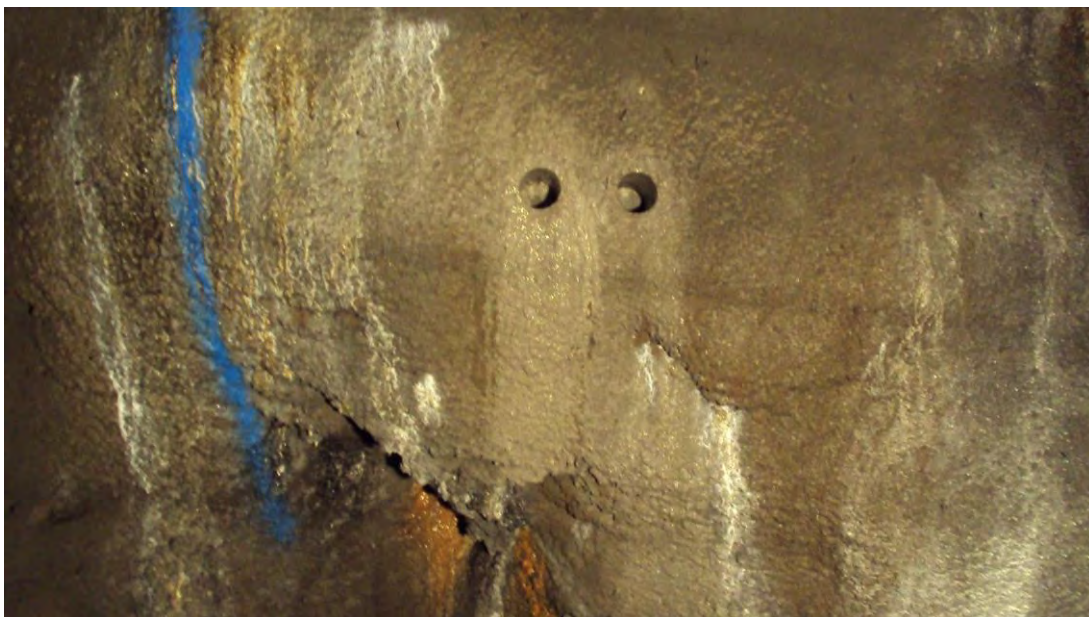
V6.2. Felt 2. Borepunkt for sprøytebetongsylindrar, prøve 2.1 (venstre) og 2.2 (høgre). Betongalder 40 dagar. Foto: Per Hagelia.
