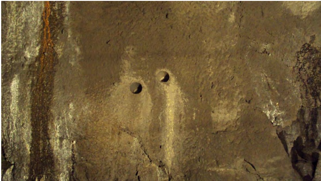
V6.1. Felt 1. Borepunkt for sprøytebetongsylindrar, prøve 1.1 (høgre) og 1.2 (venstre). Betongalder 40 dagar. Foto: Per Hagelia.
