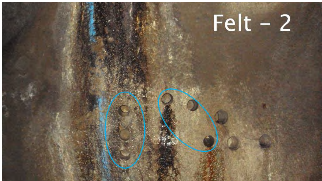
V13.2. Felt 2. Lokalisering kjerner bora ut i september 2015, til venstre for borepunkta frå 2010. Prøver frå grå overflatefuktig sprøytebetong (høgre) og prøver under biofilm (venstre). Merk at ein del av biofilmen blei vasa vekk under utboring. Foto: Per Hagelia.
