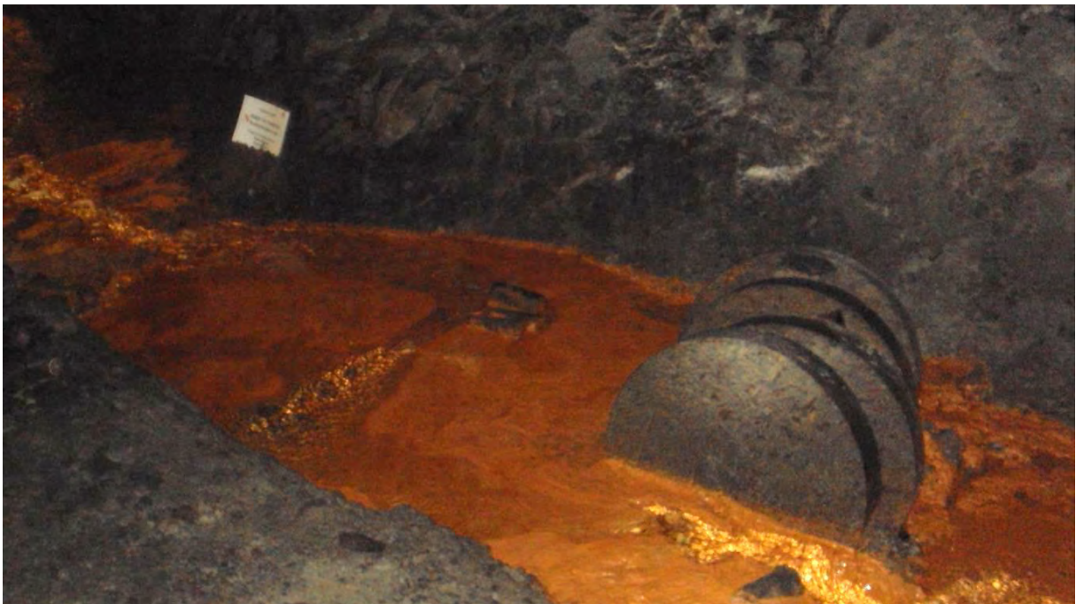
V12.14. Grøft A i mars 2017 med høgt vassnivå. Karprøvene var skjult i gjørma og A4 plateprøvene var stakk så vist opp (midt på bildet).. Foto: Per Hagelia.
