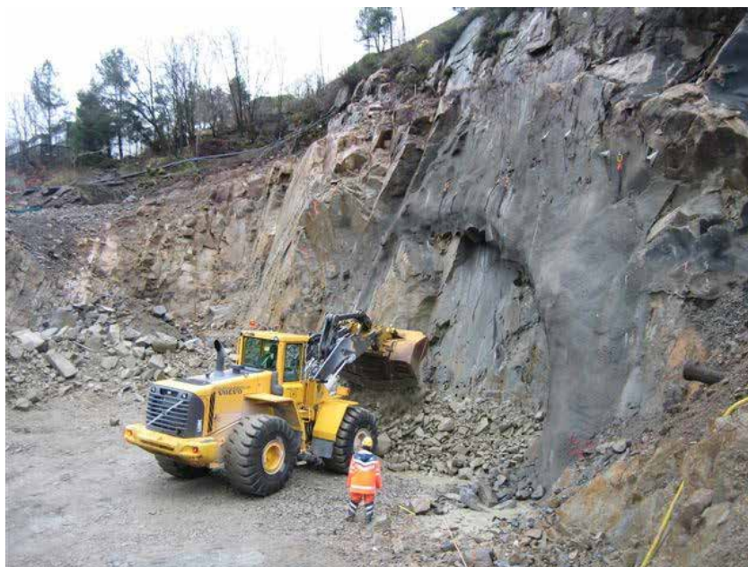
Figur 6.4 Skrått påhugg, flaten står omtrent 45° på tunnelens retning. Påhuggsflaten er også tilpasset markerte sprekkeplan (steilt fall mot venstre). Det er satt en bue med kamstål på forbolter rundt åpningen. Ringveg Vest Bergen, 1.bygetrinn (Foto: T. Kirkeby).
