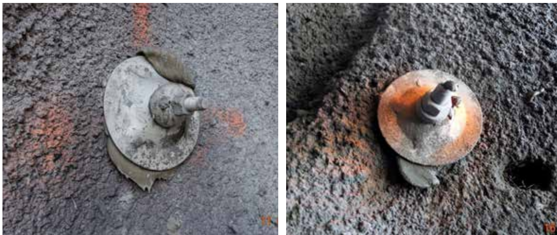
Figur 6.2 Mørtel ut bak plata er en god indikasjon på full oppfylling av bolt og hull (Foto: T. Kirkeby)
