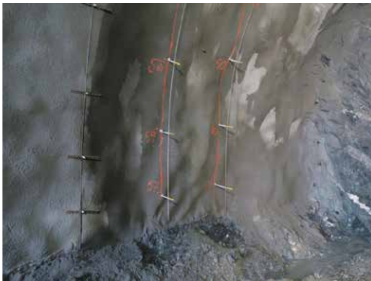
Figur 6.29 For å lette arbeidet for sprøyteoperatøren kan det monteres armering (f.eks. \varnothing 10 mm) som sprøytemål i riktig avstand fra boltespissen. Lyshorntunnelen. (Foto: J. Volden)
