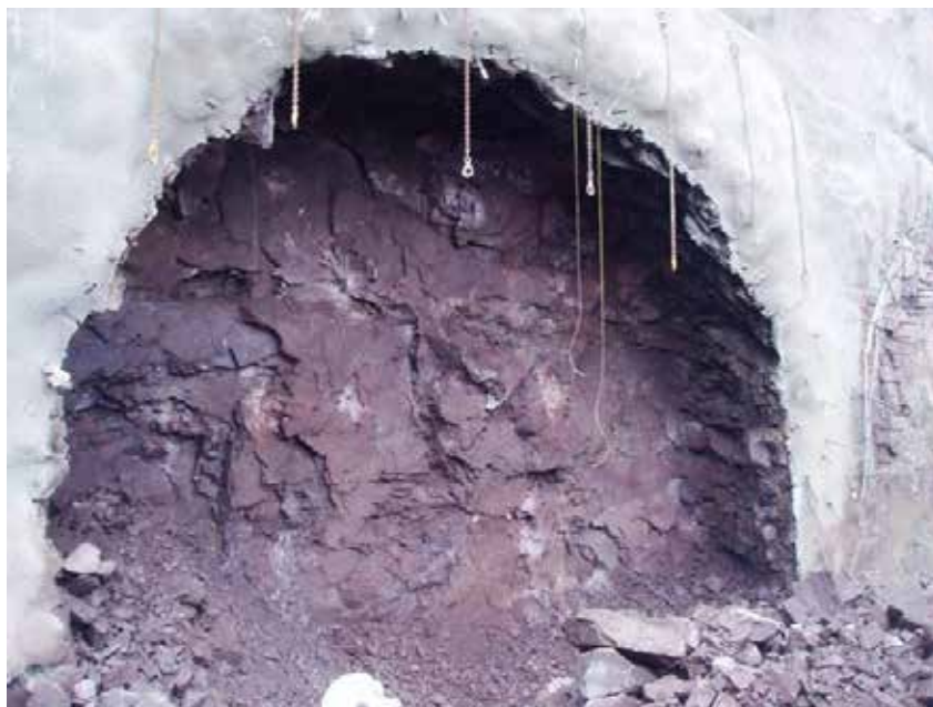
Figur 6.5 Med god forhåndssikring og skånsom sprengning kan påhuggsprofilen stå selv i meget oppsprukket berg. Frodeåstunnelen, Tønsberg. (Foto: T. Kirkeby)
