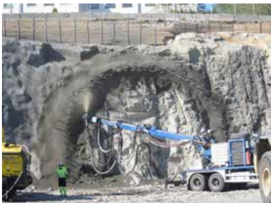
Figur 6.6 To raster med forbolter med 6 m \varnothing 32 mm, bundet sammen med \varnothing 16 mm kamstål, innerste rast helt ned mot sålen. Illustrert i skisse til høyre: innerste rast 60-70 cm fra teoretisk sprengningsprofil med innbyrdes bolteavstand c/c 60-70 cm, og en ytre rast 60-70 cm utenfor denne igjen, satt slik at boltene i ytre rast plasseres midt mellom to bolter i indre rast (såkalt W-mønster). Ringveg Vest Bergen, 2. byggetrinn. (Foto: T. Kirkeby)
