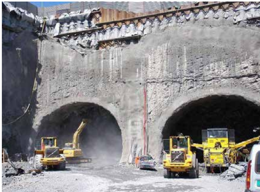
Figur 6.3 Jevn kontur i påhuggsflate. Lørentunnelen (Foto: A. Neby)
