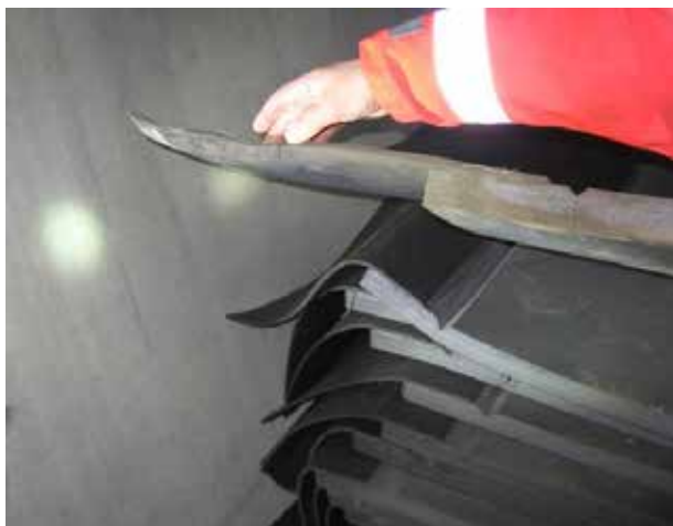
Figur 7.13 Eksempel på PE-skjørt sveiset til PE-plater, for montering kant mot kant. (Foto: M. Lindstrøm).
