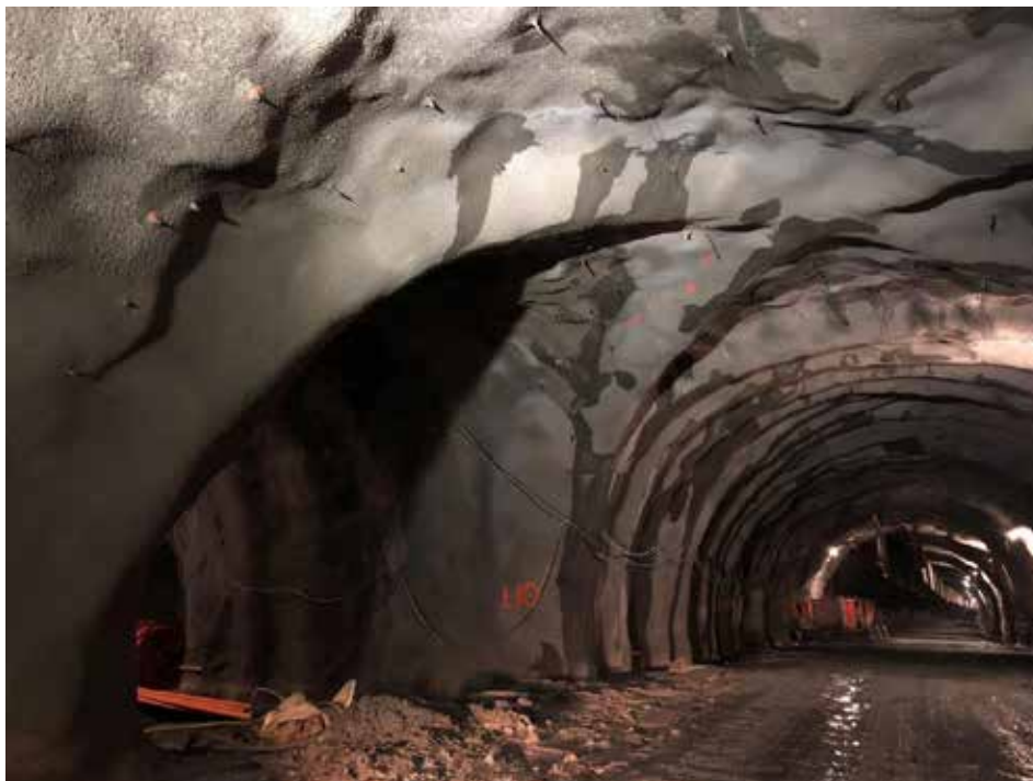
Figur 6.38 Kryssbuene fotografert fra pel 5770 i figur 6.37. (Foto: T. Kirkeby).
