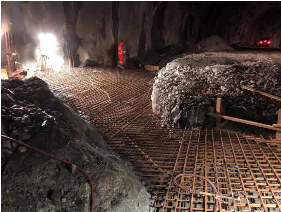
Figur 6.33 Relativt tett armering i bueformet sålestøp avsluttet mot berget utenom sonen. Åpen buearmering kan skimtes i vegg til venstre. Eksempel fra Rv. 580 Søråstunnelen i Bergen 2018. (Foto: T. Kirkeby)
