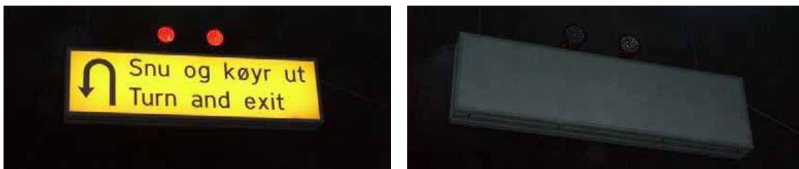
Figur 5.1 Eksempel på skilt og signal for snunisje i tunnel. To-posisjonsskilt vist i aktiv og passiv stilling. [64]
