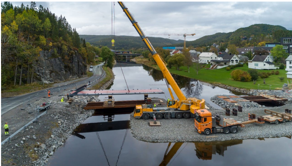
Figur 40 Løft av stålkasse over elva
