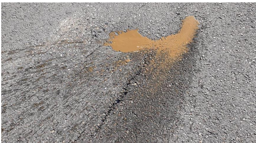
Figur 7 Vann pumpet opp til vegoverflaten
