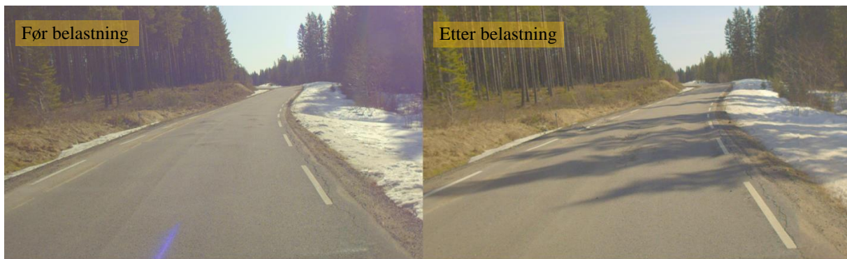
Figur 54 Skader i området 1000-1100
