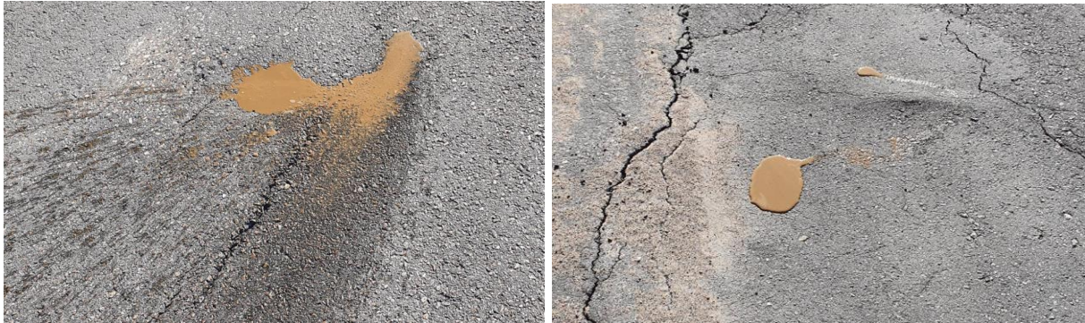
Figur 57 Vann pumpet opp på overflaten
