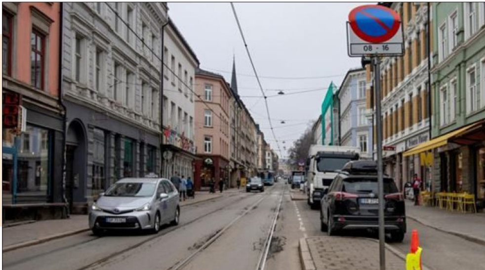
Figur 25: TMG før oppgraderingen. Oslo kommune, 2019.
