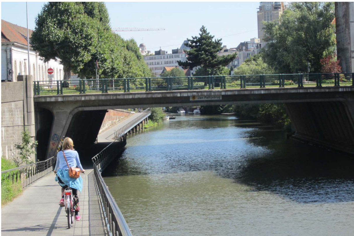
For å lette kryssingen er det under mange bruer laget underganger for gående og syklende. Disse står på pæler i vannet.
