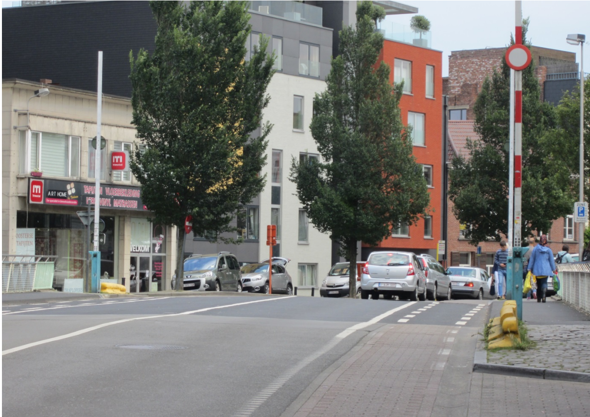
På de store veiene har sykkelfeltet fått en «buffersone» ut mot kjørebanelen.
