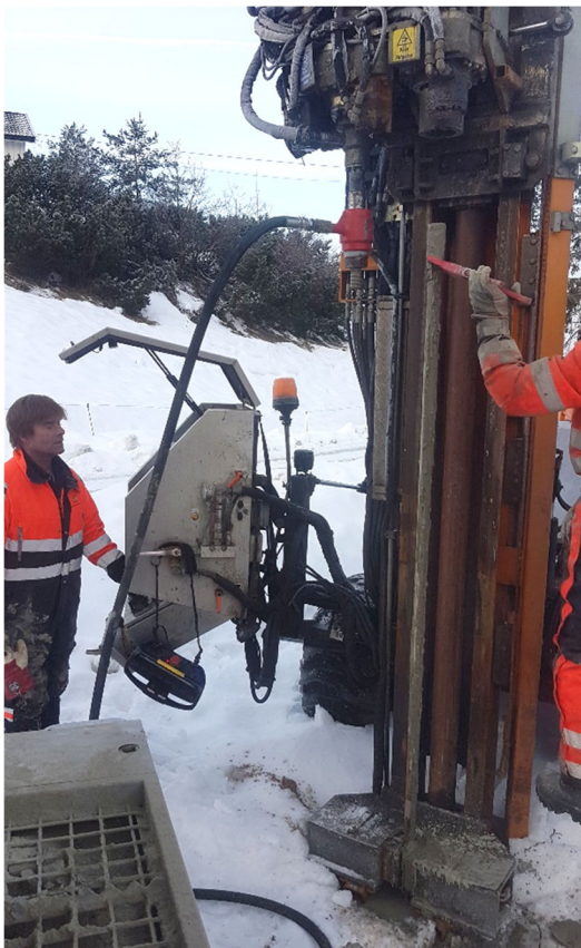
Figur 11 Tetting av borhull 89 med injeksjonsmasse ved Simostranda.
