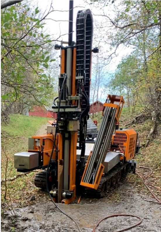
Figur 4 En av Statens vegvesen sine borerigger som ble brukt til å tette en artesiske lekkasje med injeksjonsmasse. Modell Geotech 607.
