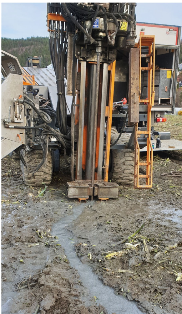
Figur 22 Borerigg plassert på borhull 1562.
