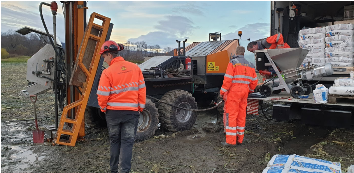
Figur 23 Tetting av borhull 1562.
