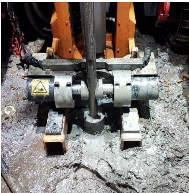
Figur 18 Veblungsnes. Tetting av borhull 4014 med injeksjonsmasse.
