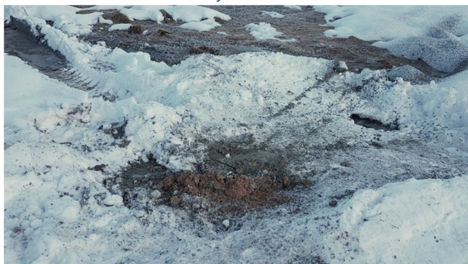
Figur 13 Tettet borhull.
