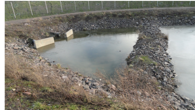
Terskel til høyre i bildet.
